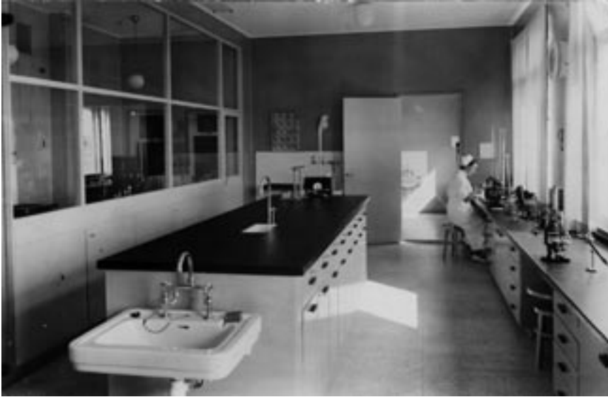
Uuden sairaalan hoito- ja laboratoriotilat olivat uudenäköiset. Kuva on otettu sairaalan juuri valmistuttua. Kuva Tampere-Seura.
