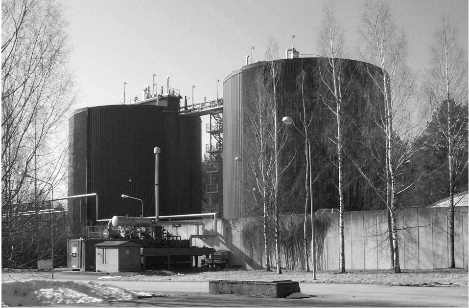
Suomenojalla päätettiin 1980-luvun alkaessa siirtyä lietteenkäsittelyssä mädättämöratkaisuun. Kuvassa mädättämöjen edessä kesällä 1997 hankittu oma kaasumoottorilaitos. (Rajala 2008)
