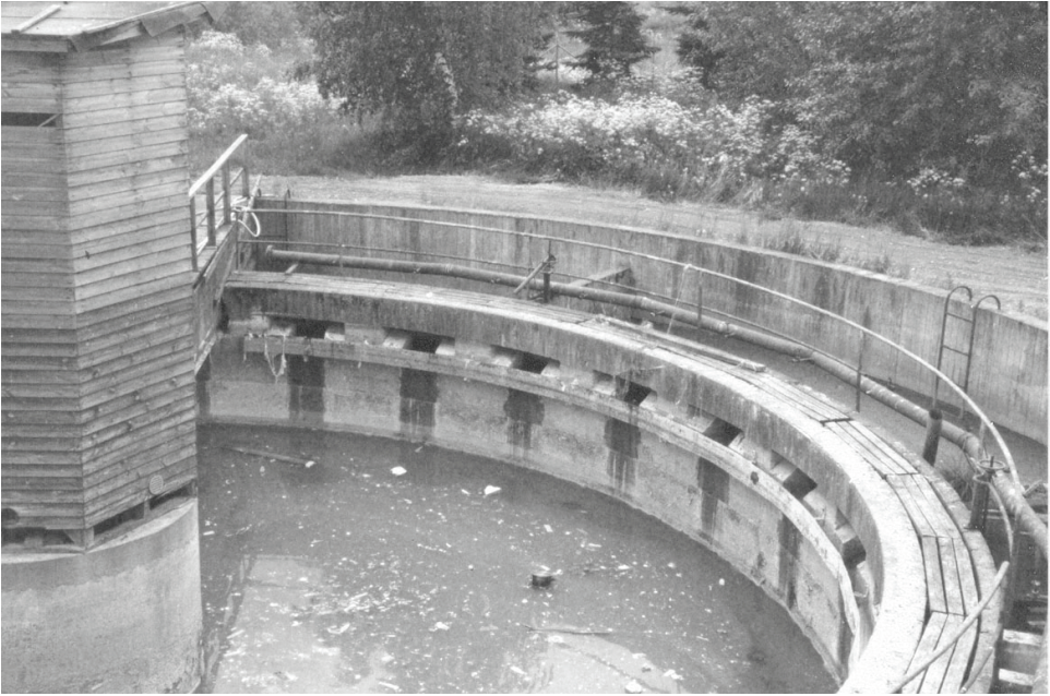
Näkymä Tapiolan jätevedenpuhdistamolta vuonna 1982. Muodoltaan puhdistamo oli pyöreä. (Espoon Vesi)
