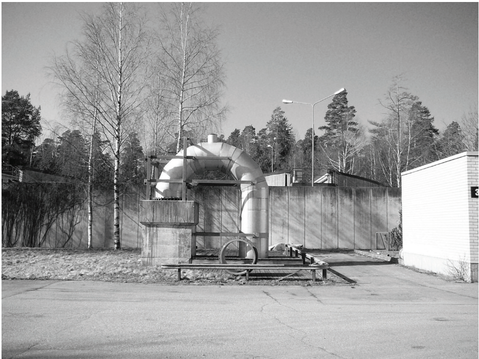
Suomenojan puhdistamolla on paljon maanpäällisiä ja maanalaisia rakenteita eri aikakausilta. (Juuti 2008)
