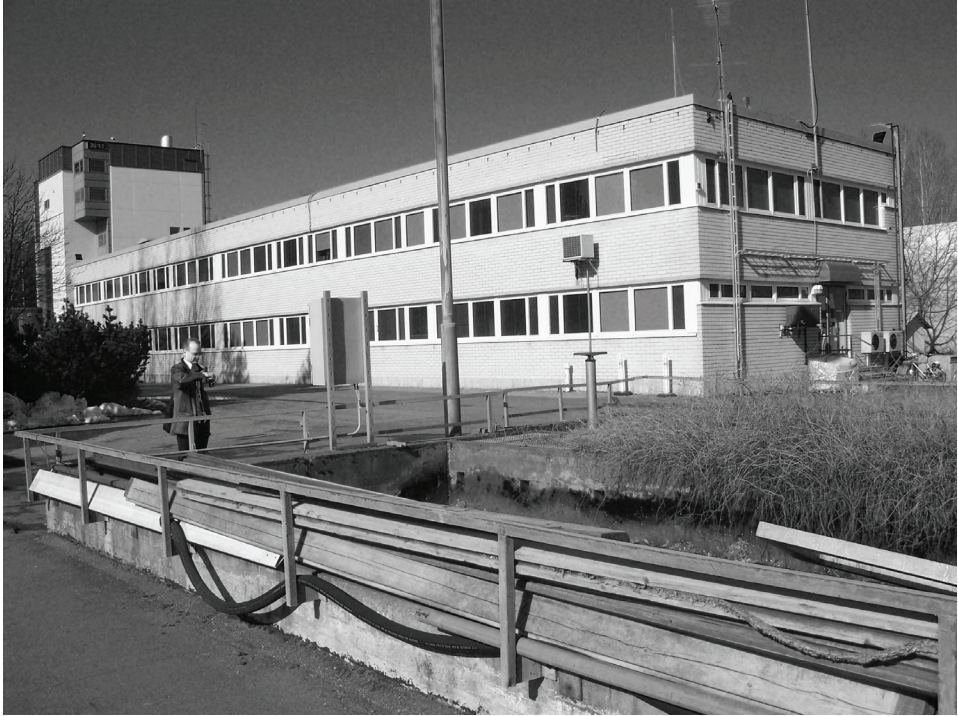
Kuvassa vuonna 1969 valmistuneen Suomenojan jätevedenpuhdistamon toimistorakennus. Toisessa kerroksessa on mm. laboratorio. Takavasemmalla näkyvä korkea rakennus on mädättämö. Lietteen mädättämö otettiin käyttöön helmikuussa vuonna 1981. (Rajala 2008)
