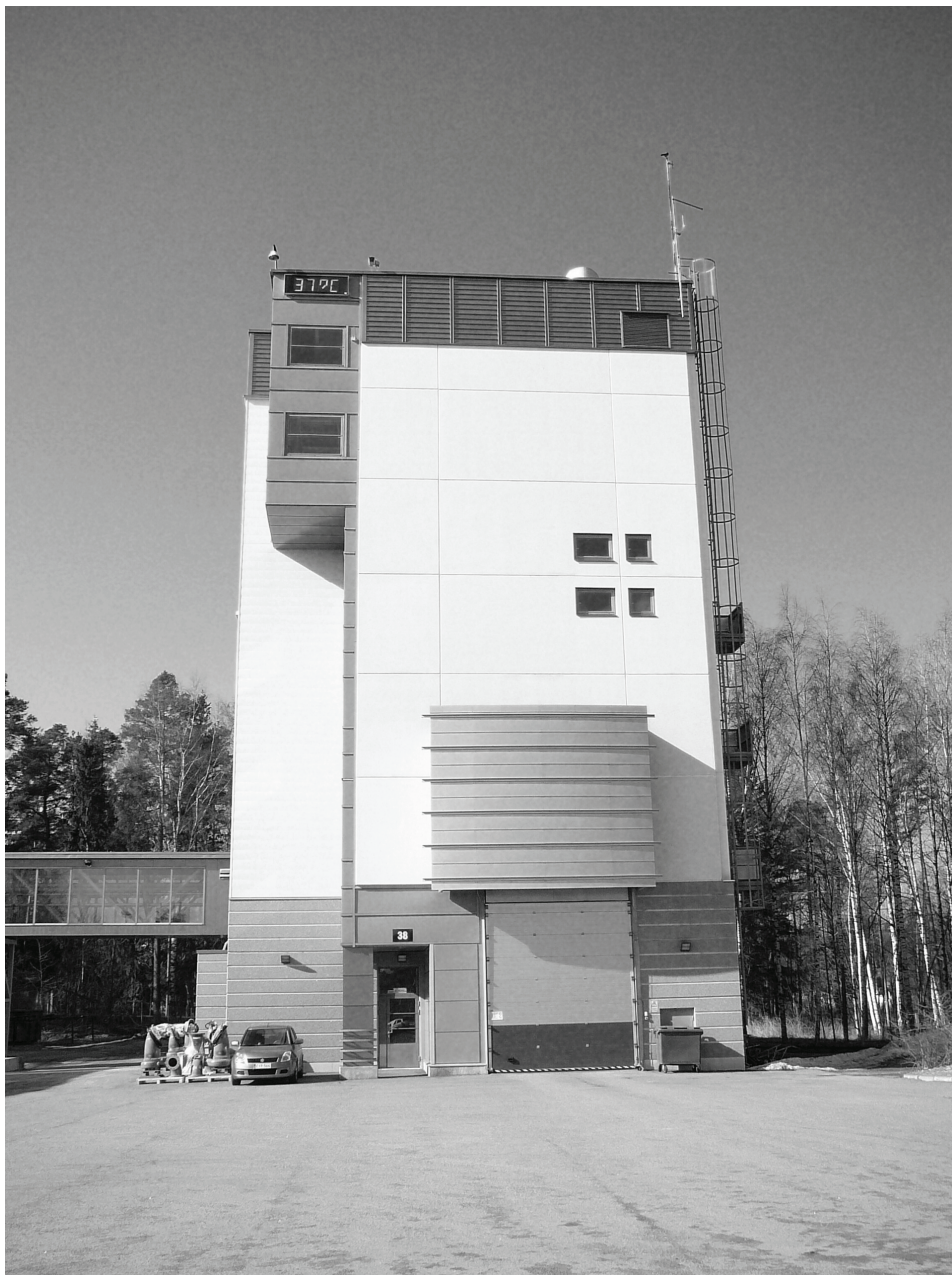
Lietteenkuivaamorakennus, joka otettiin käyttöön vuonna 1999. (Juuti 2008)
