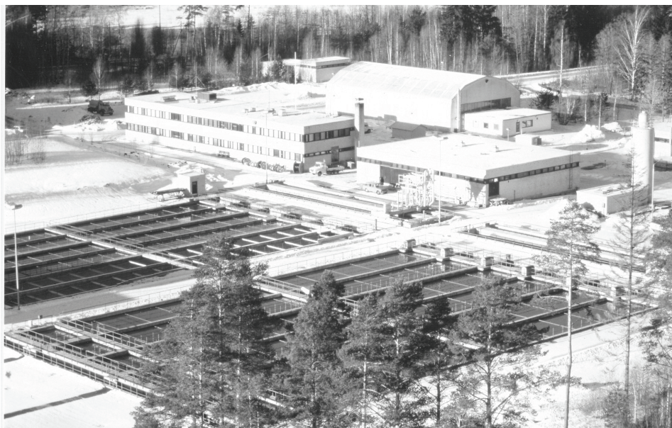
Kuva Suomenojan jätevedenpuhdistamolta ennen typenpoistolaitoksen rakentamista vuonna 1996. Taustalla näkyy ”kaarevakattoinen” Suomen Ympäristökeskuksen tutkimusasema. Sen edessä vasemmalla puhdistamon yhteinen valvomo ja laboratoriorakennus, jonka viereisessä rakennuksessa sijaitsee mm. ruuvipumppaamo. (Espoon Vesi)
