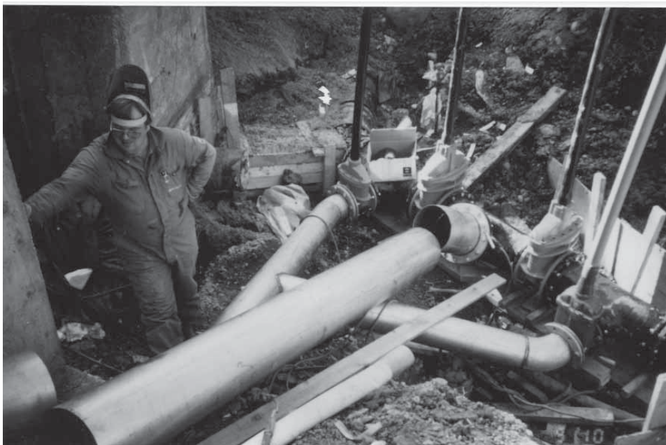
Kuva 6.22 ja 6.23 Yläkuvassa osan sovitusta montussa ja alakuvassa mietitään mistä springlerliittymän asennus aloitettaisiin vuonna 1988. (Vantaan Vesi)
