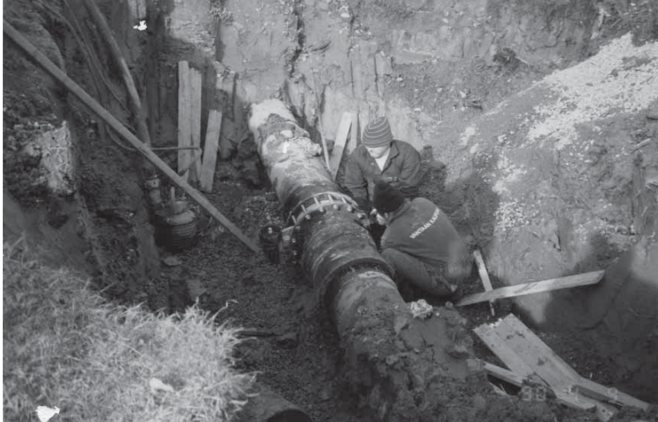
Kuva 6.26 Lämpäventtiilin asennus käynnissä huhtikuussa 1990. Kypärät ovat unohtuneet työn tiimellyksessä. (Vantaan Vesi)
