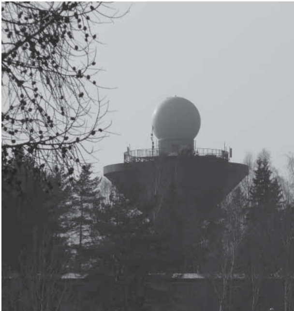
Kuva 5.18 Kaivokselan vesitorni vuonna 2007. Katolla sääpallasema. (Juuti 2007)
