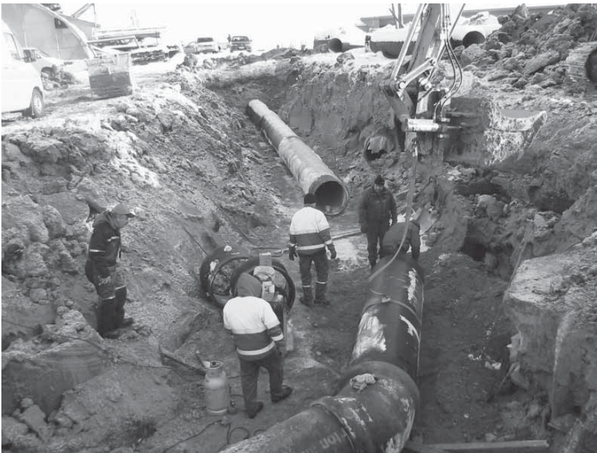
Kuva 9.13b Työmaata vielä riittää. (Vantaan Vesi)
