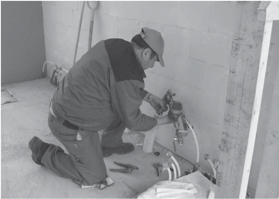
Kuva 9.20 Vesimittarin asennus menossa. (Vantaan Vesi)
