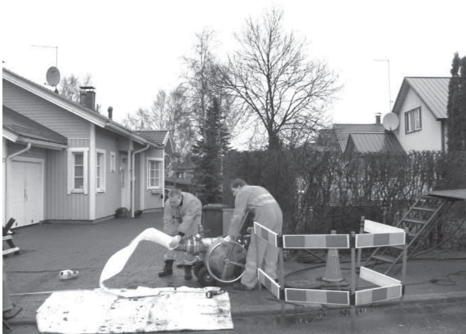
Kuva 7.19 Suutarilan saneeraus tehtiin sukkasujutusmenetelmällä joulukuussa 2006. (Vantaan Vesi 2006)
