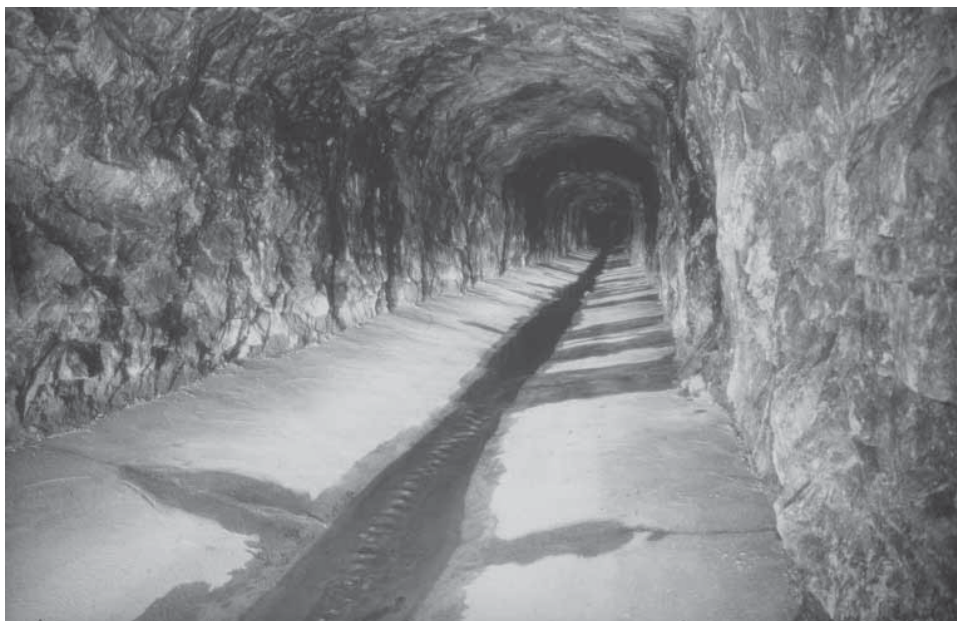
Kuva 7.16 Kuvassa meriviemäritunnelin leveintä osuutta. (KUVES)
