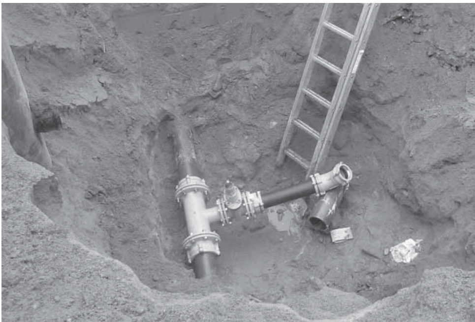
Kuva 9.21 Tonttiliittymän asennusmonttu. (Vantaan Vesi)
