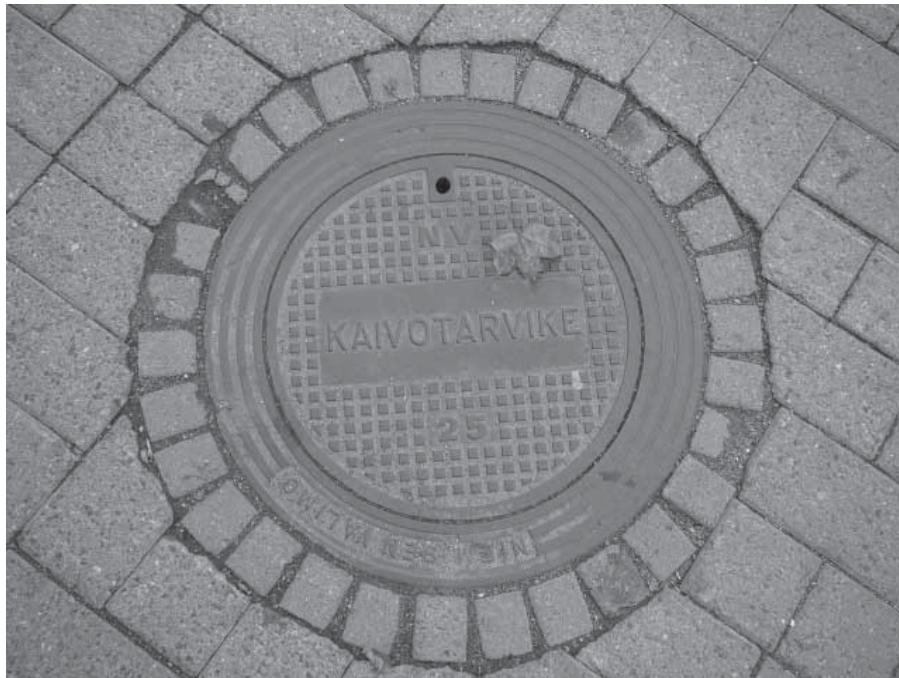
Kuva 10.2 Sadevesiviemärin huoltokaivo. (Juuti 2007)
