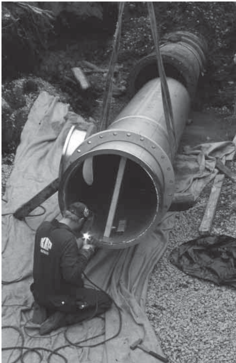
Kuva 6.24 ja 6.25 Yläkuvassa kau- luslaipan hitsausta ja alakuvassa 500 mm runkolinjan siirto käynnissä. (Vantaan Vesi)
