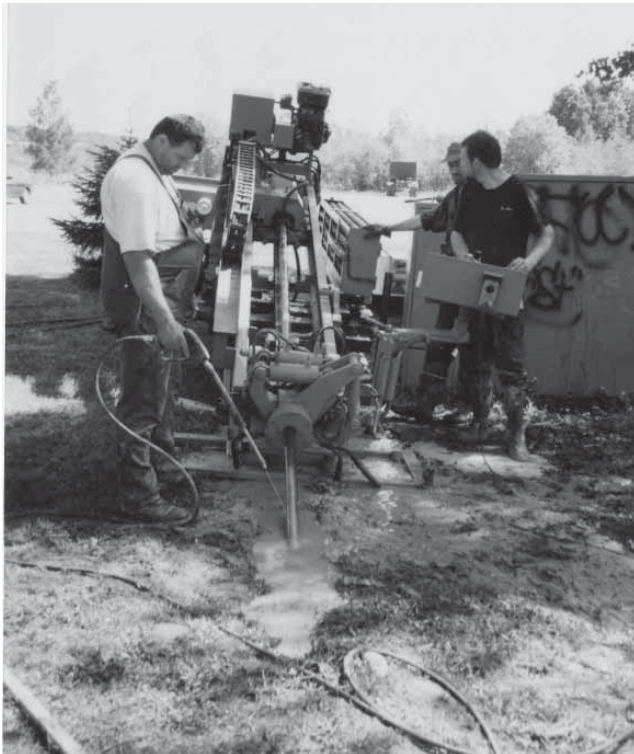
Kuva 9.13a Vaakaporausta Vapaalassa vuonna 1996. Vaakaporaamalla maan sisään vedettiin Ns 300m PE-vesijohto. (Vantaan Vesi)
