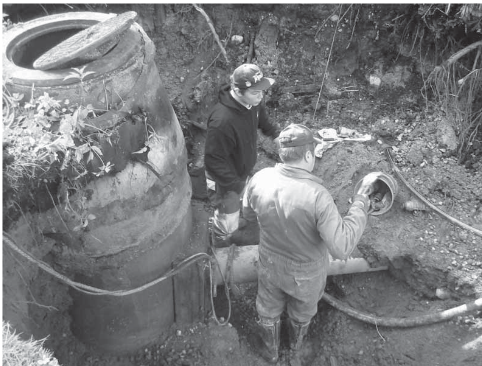
Kuva 7.23 Vantaan Veden miehiä viemäryömaalla. (Vantaan Vesi)
