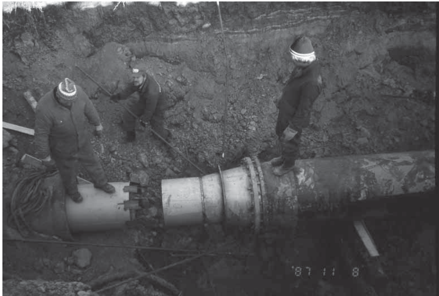
Kuva 9.10 Vuodonkorjaus menossa. (Vantaan Vesi 1987)
