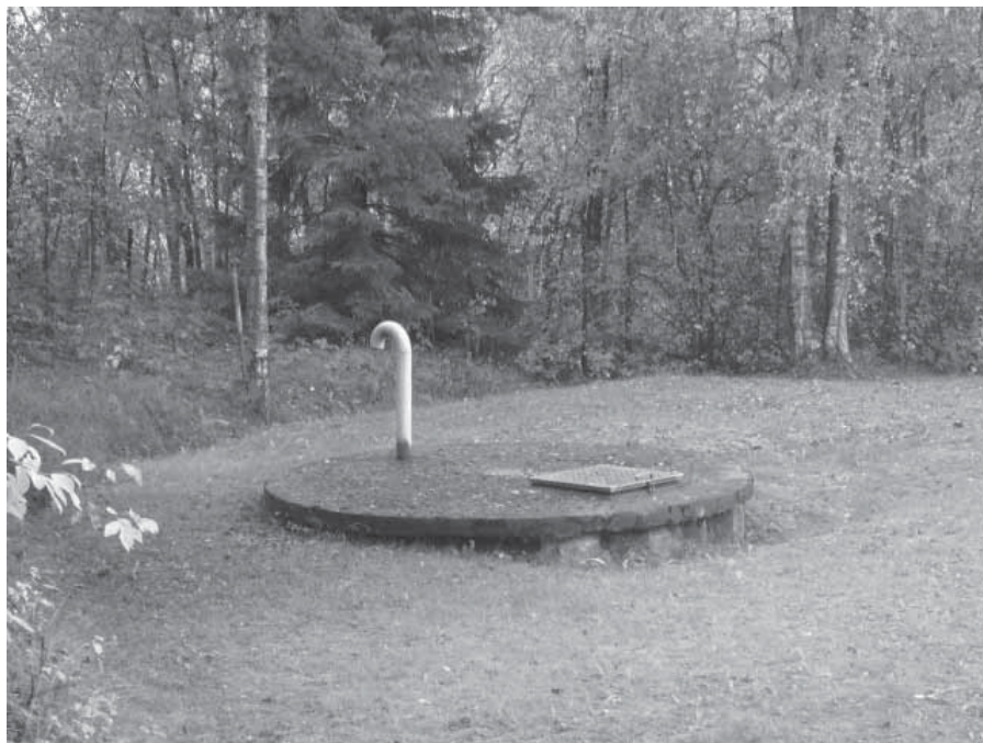
Kuva 5.20 Yksi Valkealähteen pohjavedenottamon kaivoista. (Rajala 2006)
