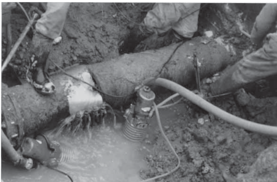
Kuva 9.9 Hankala vuodonkorjaus maaliskuussa 1988. (Vantaan Vesi 1988)
