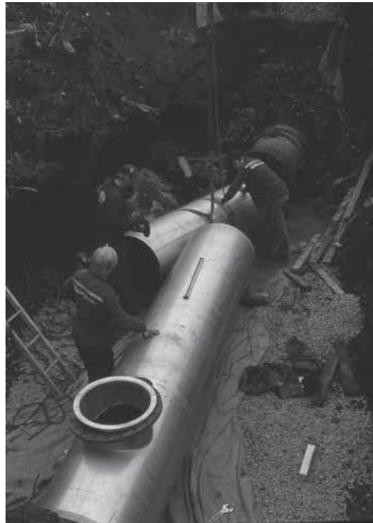
Kuva 8.3 Korjausosien sovitus menossa. (Vantaan Vesi)
