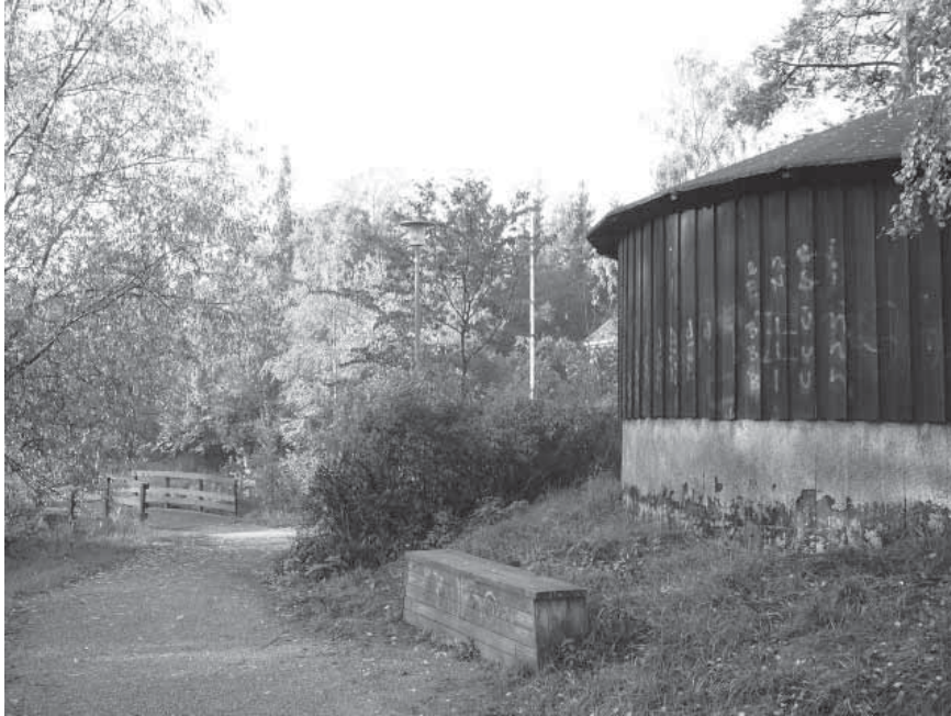
Kuva 7.2 Tikkurilan keskustan jätevesi johdettiin aluksi Keravanjoen rannalla olleen emscher-kaivon kautta jokeen. Emscher-kaivo kuvassa oikealla. (Rajala 2006)
