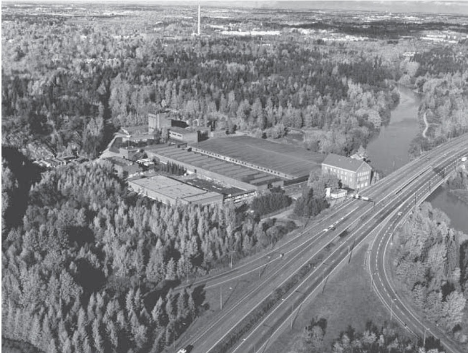
Kuva 6.17 Kuvassa Helsingin Vanhankaupungin vedenkäsittelylaitos. (Helsingin Vesi)
