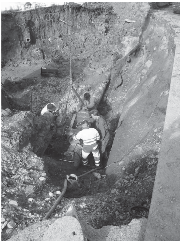
Kuva 9.12a Kuvassa sujutus menossa Pitkäsentiellä. (Vantaan Vesi)
