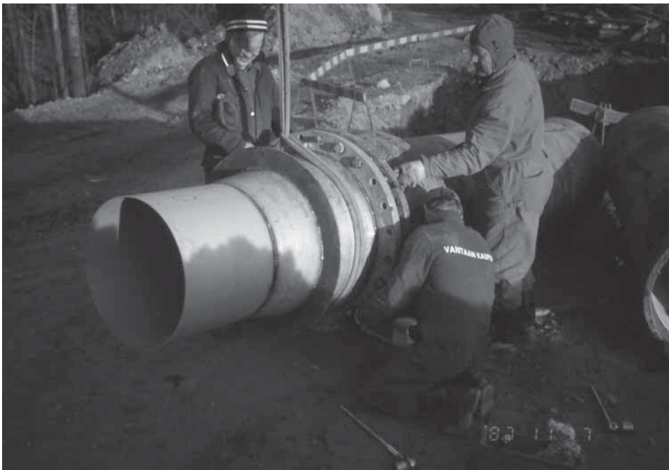
Kuva 6.21 Kuvassa kiinnitetään laipan pultteja. (Vantaan Vesi)
