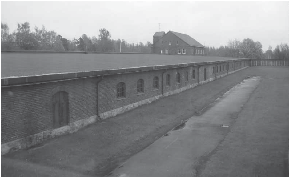
Kuva 6.18 Kuvassa osa Vanhankaupungin vedenkäsittelylaitosta, joka valmistui 1920-luvulla. (Rajala 2007)
