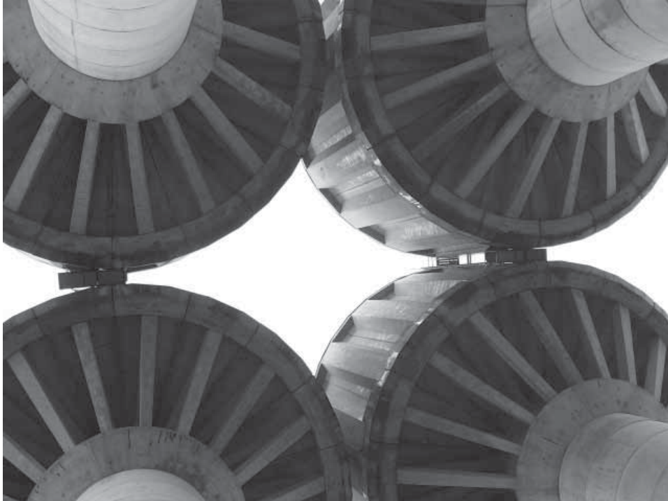
Kuva 5.11 Korson vesitorni koostuu neljästä osasta, jotka ovat yhteydessä toisiinsa. Tornin huippujen välillä näkyy huoltosilta molemmilla puolilla. (Juuti 2006)
