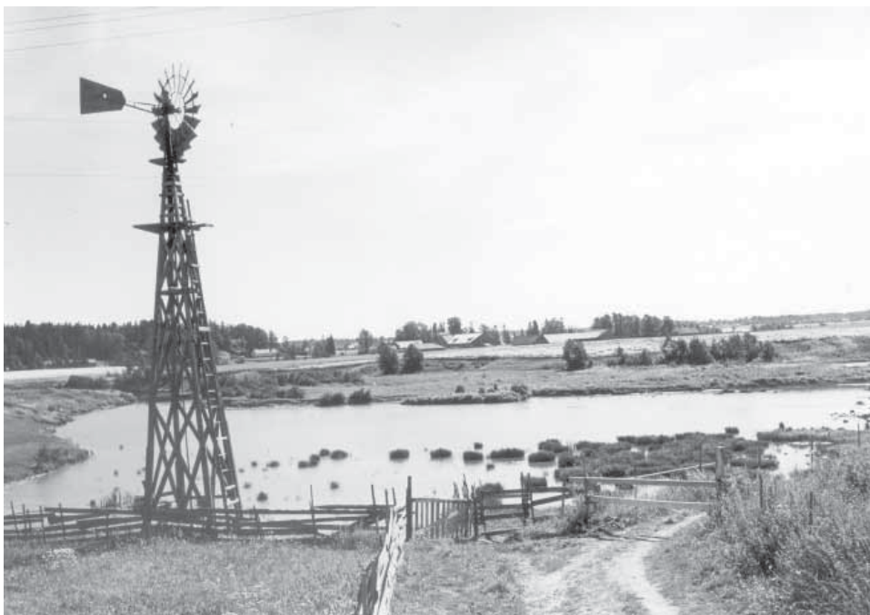
Kuva 3.4 Ruutinkoskella (Grotensfors) sijainnut vesipumppu. Pumppu rakennettiin 1880-1890-lukujen vaihteessa. Sillä pumpattiin vettä säiliöön ja edelleen omalla paineellaan Grotensin tilan talousrakennuksiin. Tuulimoottori on erittäin kätevä juuri veden pumppaamisessa, sillä se on varsin helppo huoltaa. Taustalla Tammistoa ja Haltialaa. Pumppu purettiin 1960-luvulla. (VKMKA Mannelin 1957)
