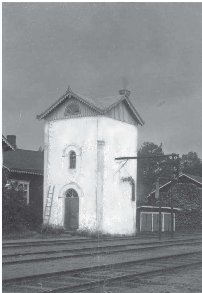
Kuva 3.5a Tikkurilan aseman vesitorni ja oikealla resiinatallit 1910-luvulla. Höyryveturit ottivat vettä aseman tornista. Rakennus on purettu 1960-luvun paikkeilla. (Suomen Rautatiemuseon kokoelma)
