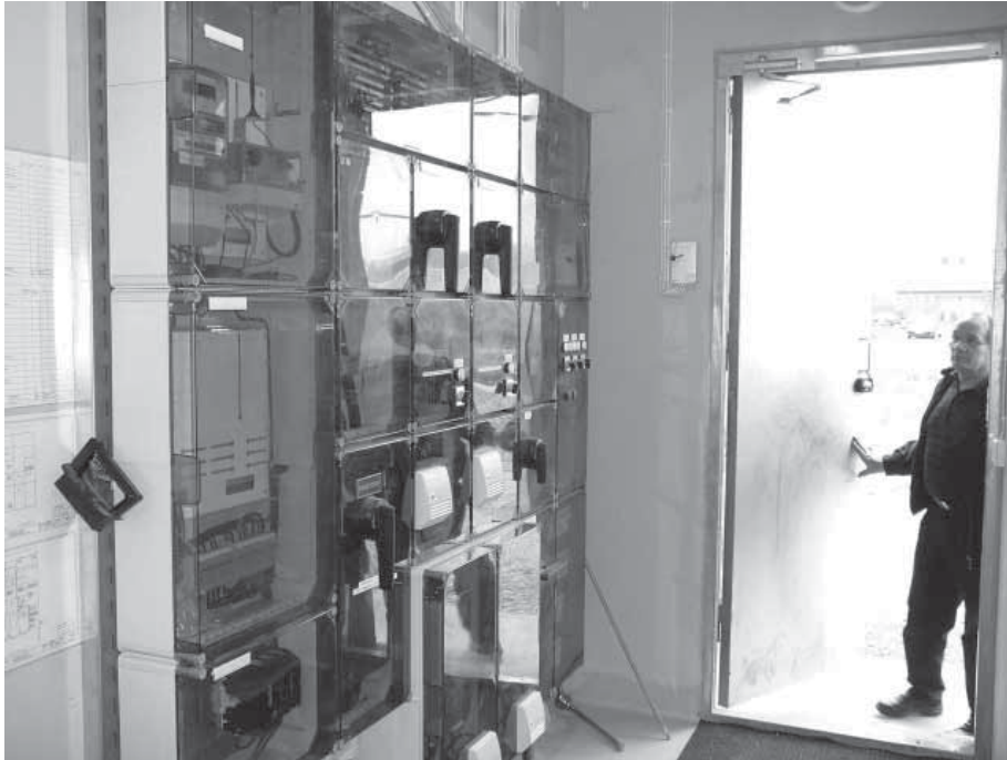
Kuva 7.12b Tapio Nurmi esittelee Vaaralan jätevedenpumppaamo vuonna 2006. (Rajala 2006)
