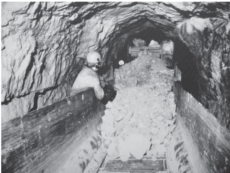
Kuva 7.14 Kuvassa kaivetaan meriviemärijärjestelmän tunneliosuutta. (KUVES)
