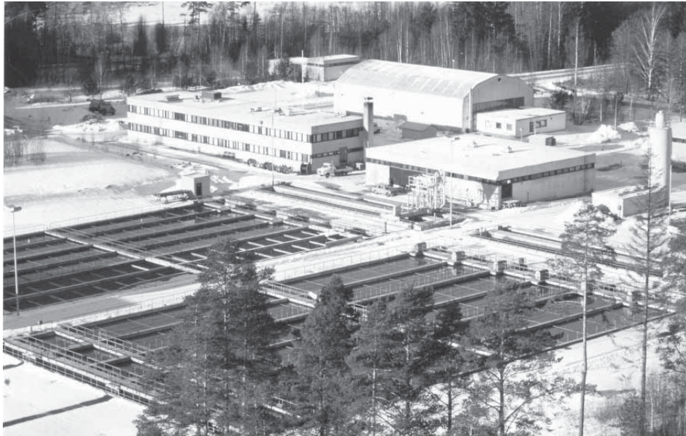
Kuva 7.9a Kuva Espoosta, Suomenojan jätevedenpuhdistamolta ennen typenpoistolaitoksen rakentamista vuonna 1996. (Espoon Vesi)
