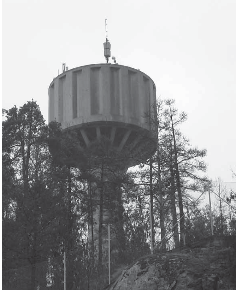
Bild. Vattentorn i Vanda, Hakunila. (Juuti 2007)
