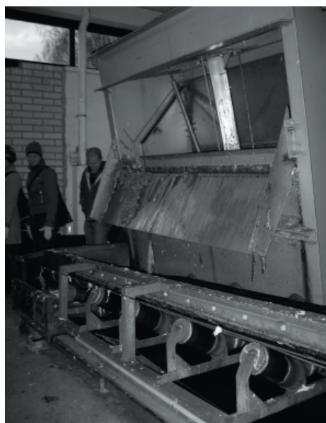
Kuva 7.9c Kuvassa välppäjätteen siirtohihna Suomenojan jätevedenpuhdistamolla. (Juuti 2006)
