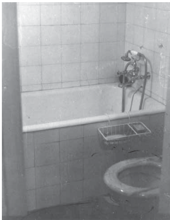
Kuva 4.2 Tikkurilan ensimmäisten kerrostalojen kylpyhuone, jossa oli kylpyamme sekä wc. (VKMKA Koistinen 1975)
