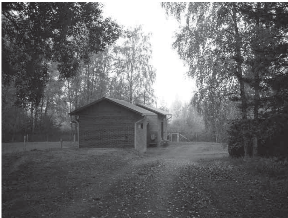
Kuva 5.1 Valkealähteen pumppurakennus vuonna 2006. (Juuti 2006)
