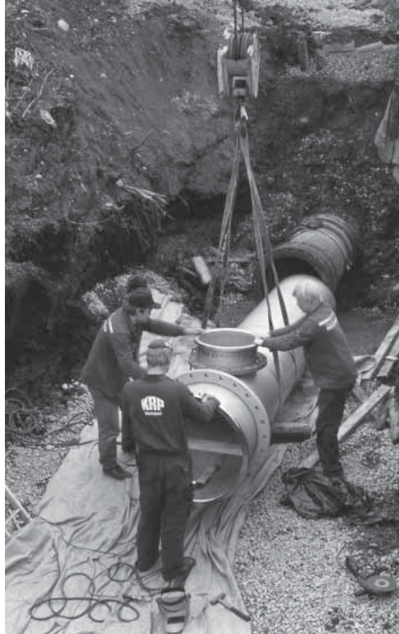
Kuva 6.22 ja 6.23 Yläkuvassa osan sovitusta montussa ja alakuvassa mietitään mistä springlerliittymän asennus aloitettaisiin vuonna 1988. (Vantaan Vesi)
