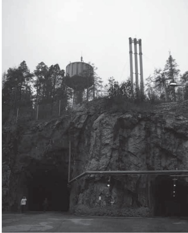
Kuva 5.15 Hakunilan 1973 valmistunut vesitorni on yksi neljästä edelleen käytössä olevasta Vantaan vesitornista. Vasemmalla alhaalla sisäänkäynti luolaan, jossa mm. alavesisäiliö.(Juuti 2006)
