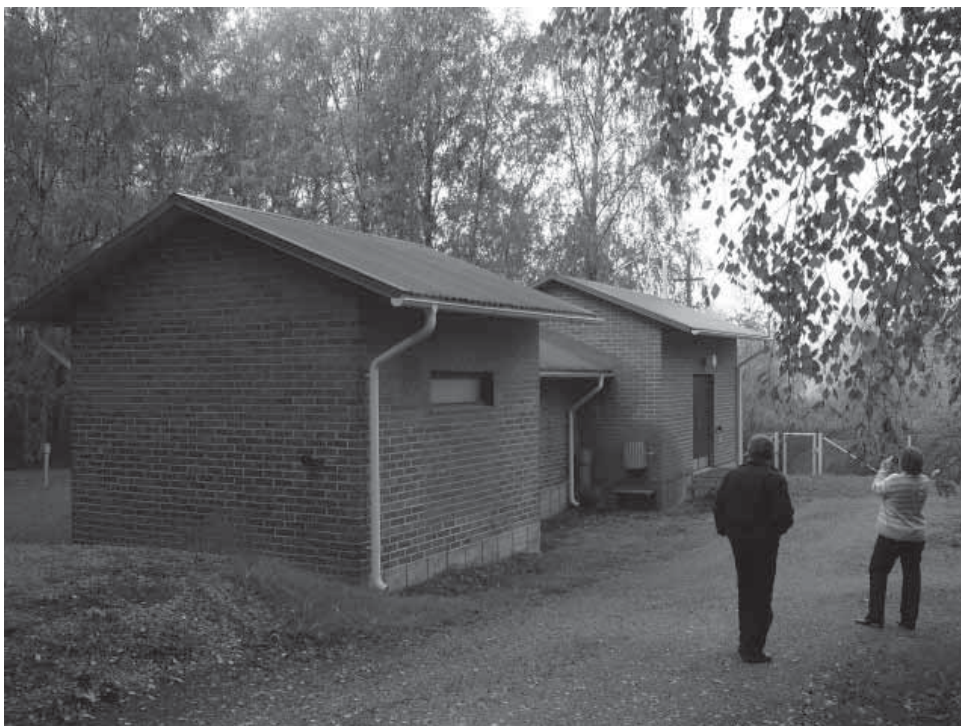
Kuva 4.8 Valkealähde on ensimmäinen Vantaan vedenottamo. Kuvassa pumppaamorakennus 1900-luvun lopulta. (Juuti 2006)
