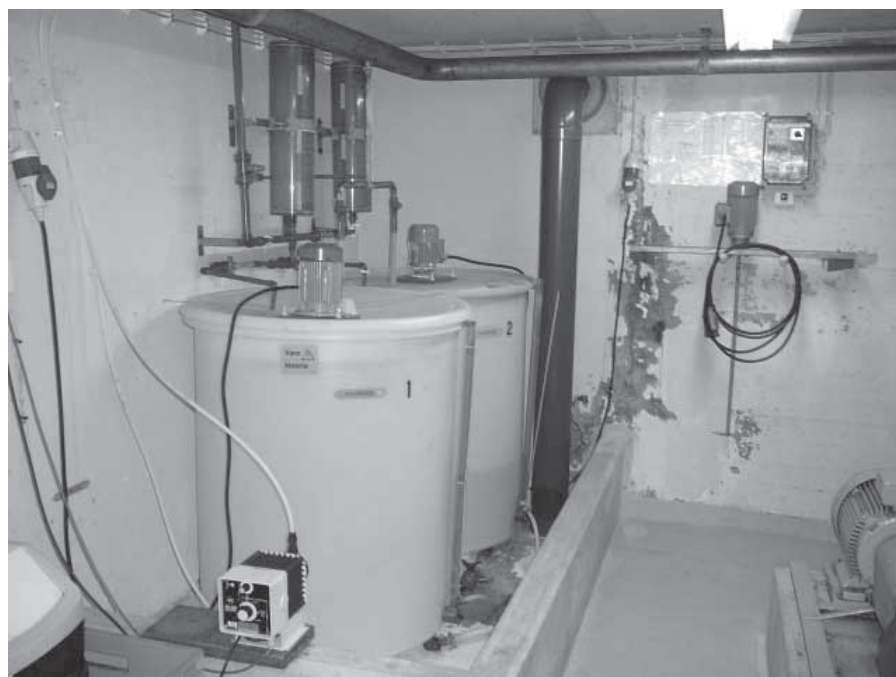
Kuva 5.21 Klooriliuosta käytetään Valkealähteen vedenlaadun turvaamiseen. (Rajala 2006)
