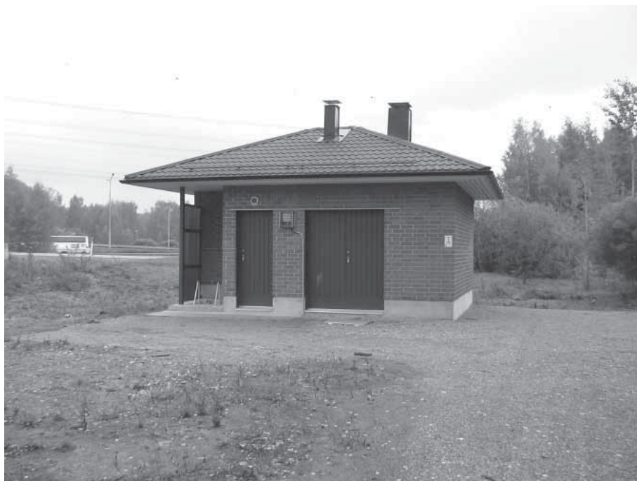
Kuva 7.12a Vaaralan jätevedenpumppaamo vuonna 2006. (Rajala 2006)
