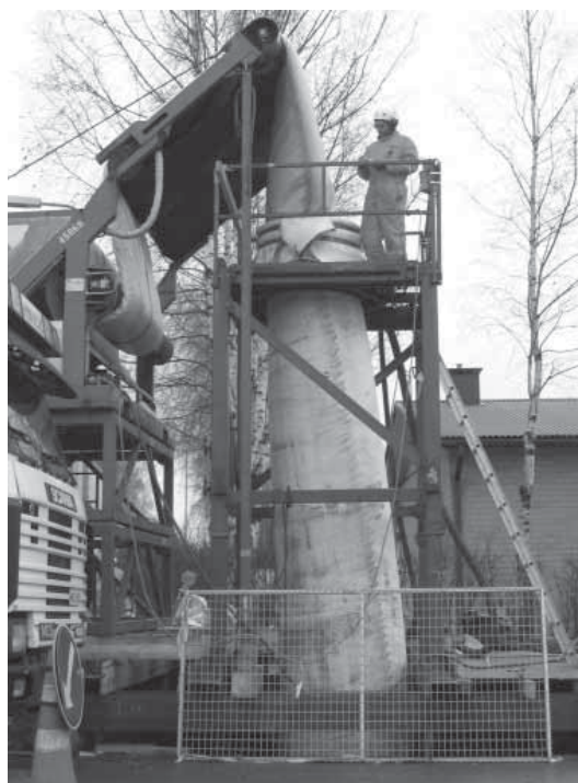
Kuva 7.20 Suutarilan viemäri-saneerausta joulukuussa 2006. (Vantaan Vesi 2006)
