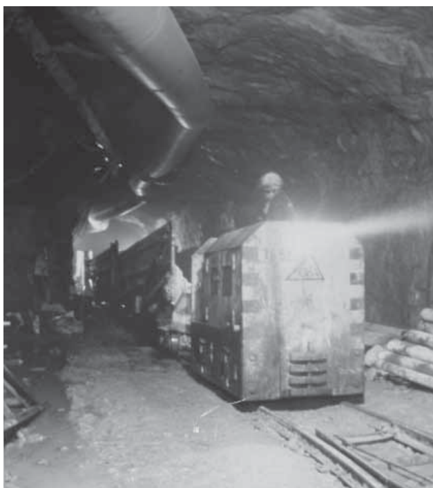
Kuva 7.15 Kuvassa kaivetaan meriviemärijärjestelmän tunneliosuutta. Tunneli oli niin tilava, että kuljetukset pystyttiin hoitamaan pienoisorjilla. (KUVES)
