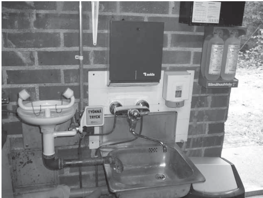
Kuva 6.9 ja 6.10 Yläkuvassa Kuninkaanlähteen klooriastiat ja alakuvassa työturvallisuuden liittyviä hätäapuvälineitä kuten silmäsuihku. (Juuti 2006)
