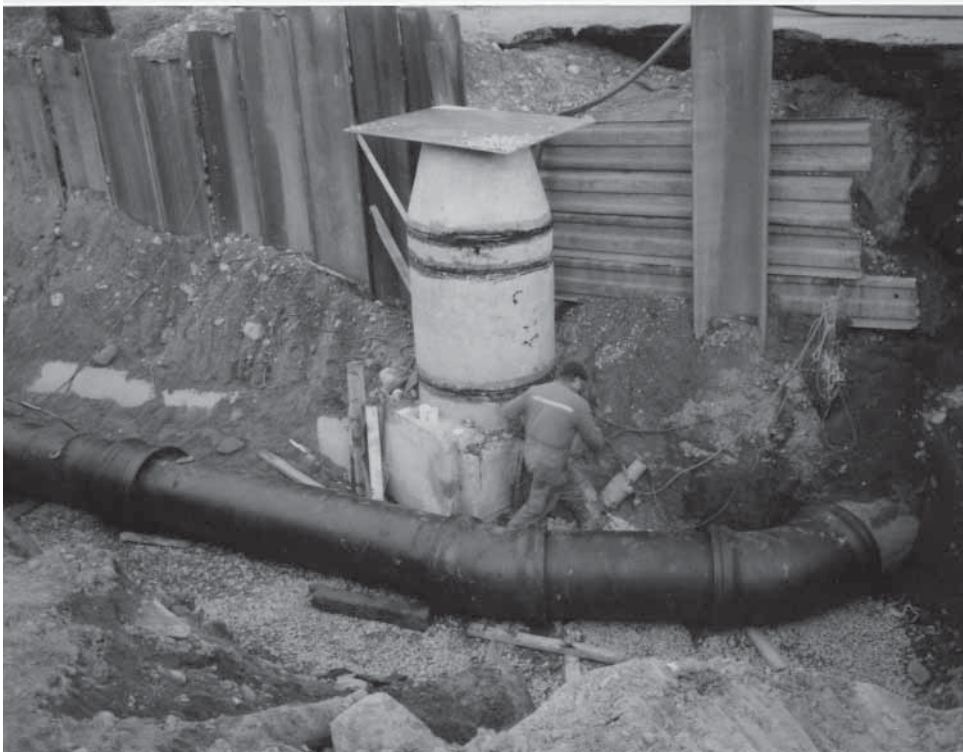
Kuva 6.24 ja 6.25 Yläkuvassa kau- luslaipan hitsausta ja alakuvassa 500 mm runkolinjan siirto käynnissä. (Vantaan Vesi)
