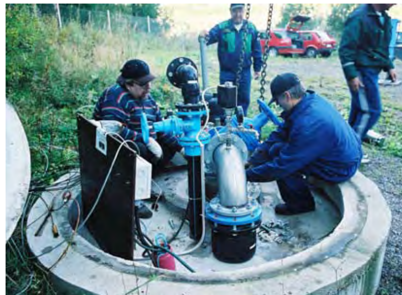
Kylmälahden raakavesikaivon numero 6 pumpun vaihto vuonna 2002. Vasemmalta Matti Nylund, Pekka Suvanto sekä Teuvo Mölsä. (HS-Vesi)
