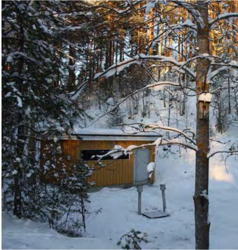
Isomäen vedenottamo. (HS-Vesi).
