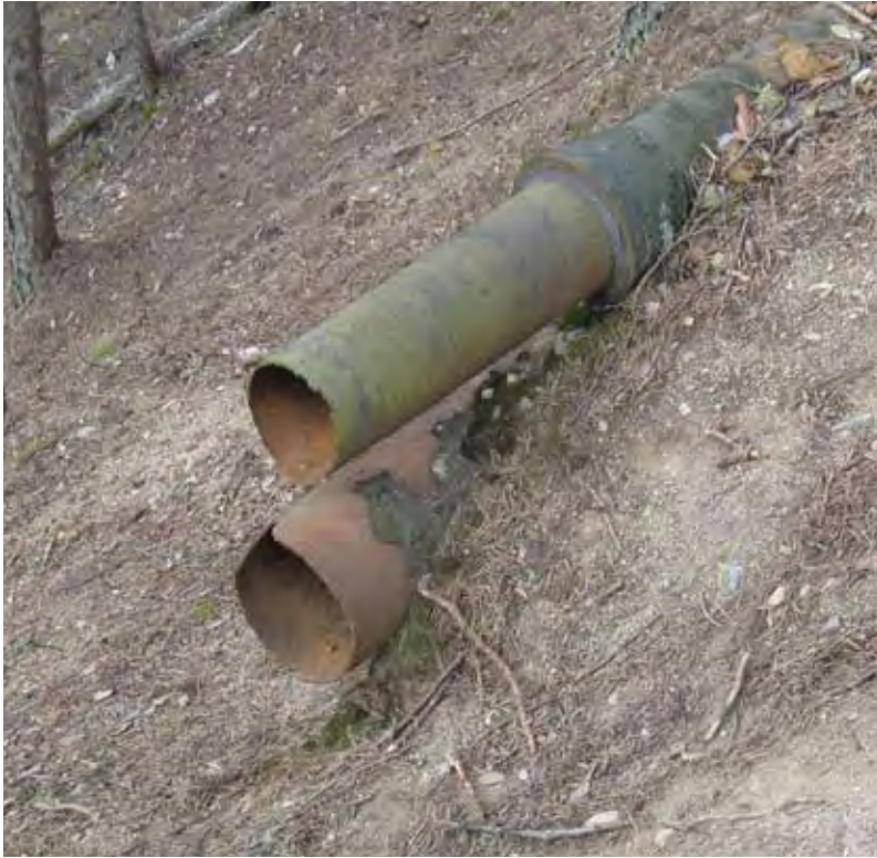
Ahveniston ensimmäiset putket ovat vielä näkyvissä. Ne rakennettiin vuonna 1910, eivätkä ole enää käytössä. (HS-Vesi)
