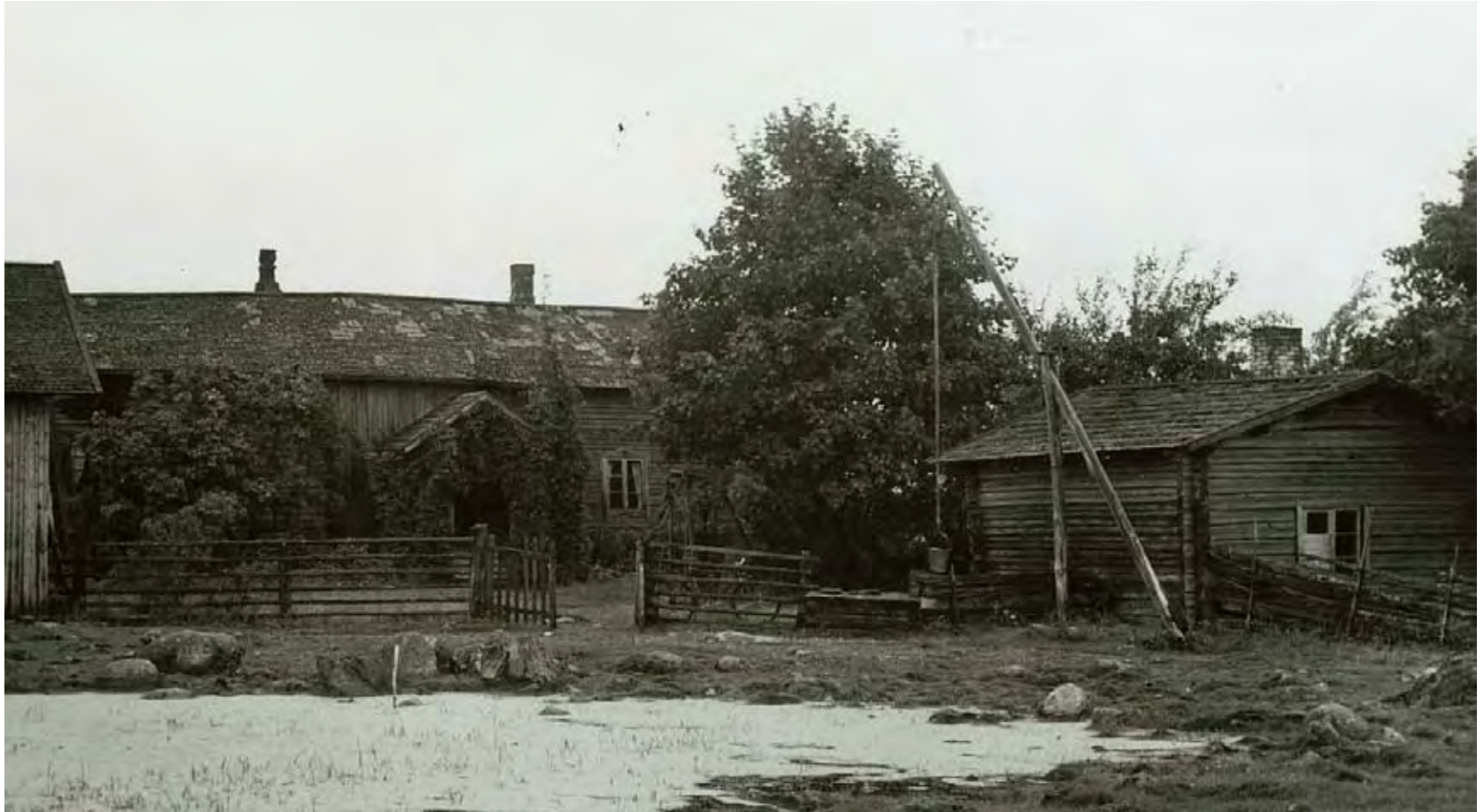
Kalvola, Torajärvi. Nikolai Alasentien talon karjapiha. Rakennusryhmään kuuluvat heinäladot, talli, navetta, sikölähti, aitta, sauna ja vinttikaivo. Pihan ja karjapihan välinen susiainen on poistettu. (HKHM) Kuva otettu arviolta 1800-1900-luvun vaihteessa.
