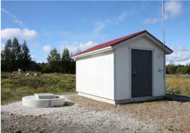
Sammonojan jätevedenpumppaamo on rakennettu vuonna 2009. (HS-Vesi)
