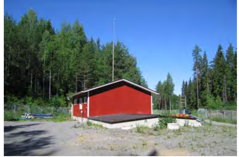
Lammin Pyssymäen pohjavesilaitos rakennettiin vuonna 2002. (HS-Vesi 2006))
