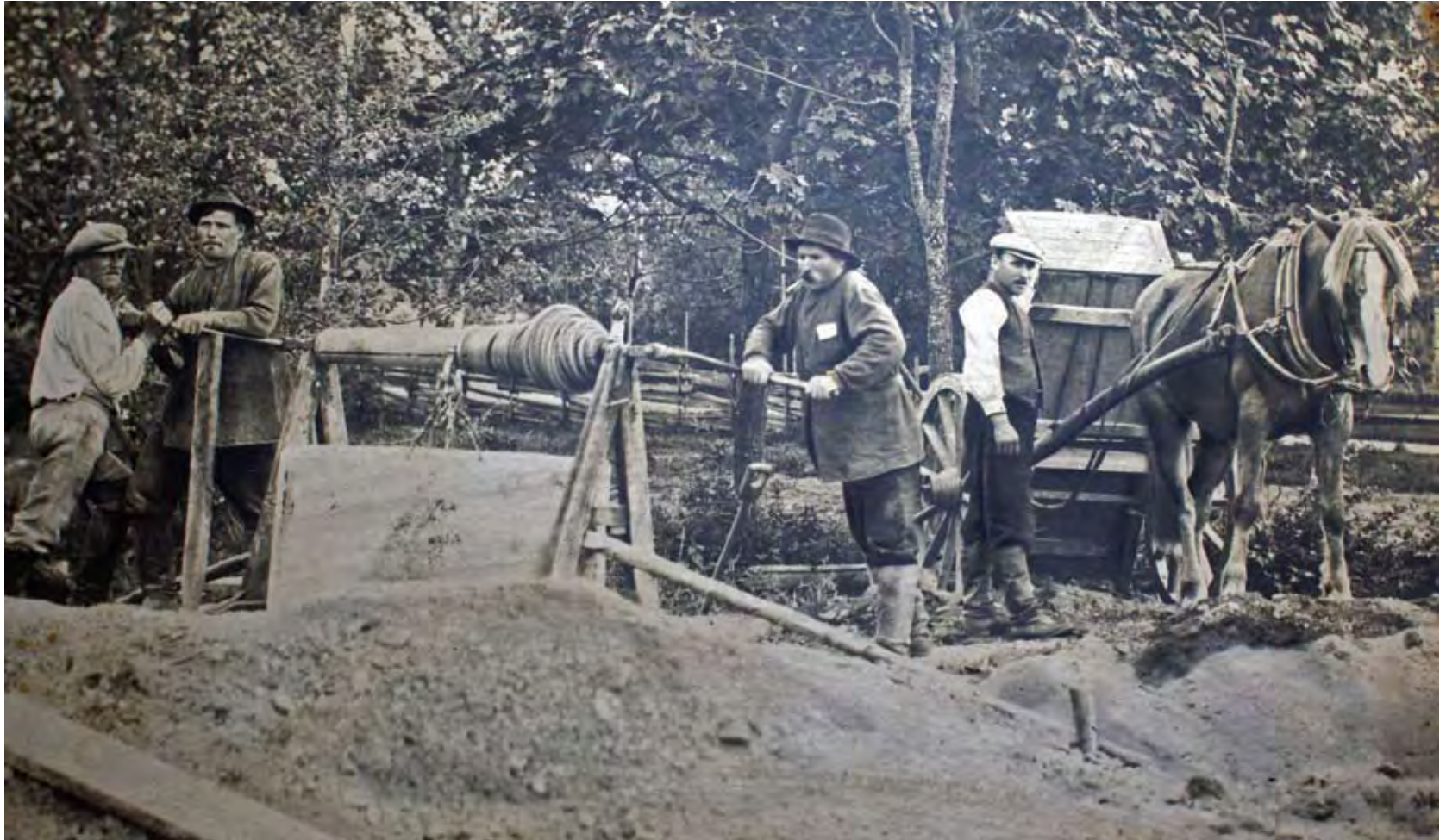
Kaivonrenkaiden laskua Tuuloksessa 1920-luvulla. Kuvassa vasemmalta Kalle Rantala, kaivomestari Vihtori Tuomi ja Vihtori Lehtinen. Kuvan oikeanpuoleisin henkilö on jäänyt tuntemattomaksi. Hän on todennäköisimmin isäntä, jolle kaivoa on oltu tekemässä. (Tuulos-Seura ry, Tuomi K.)
