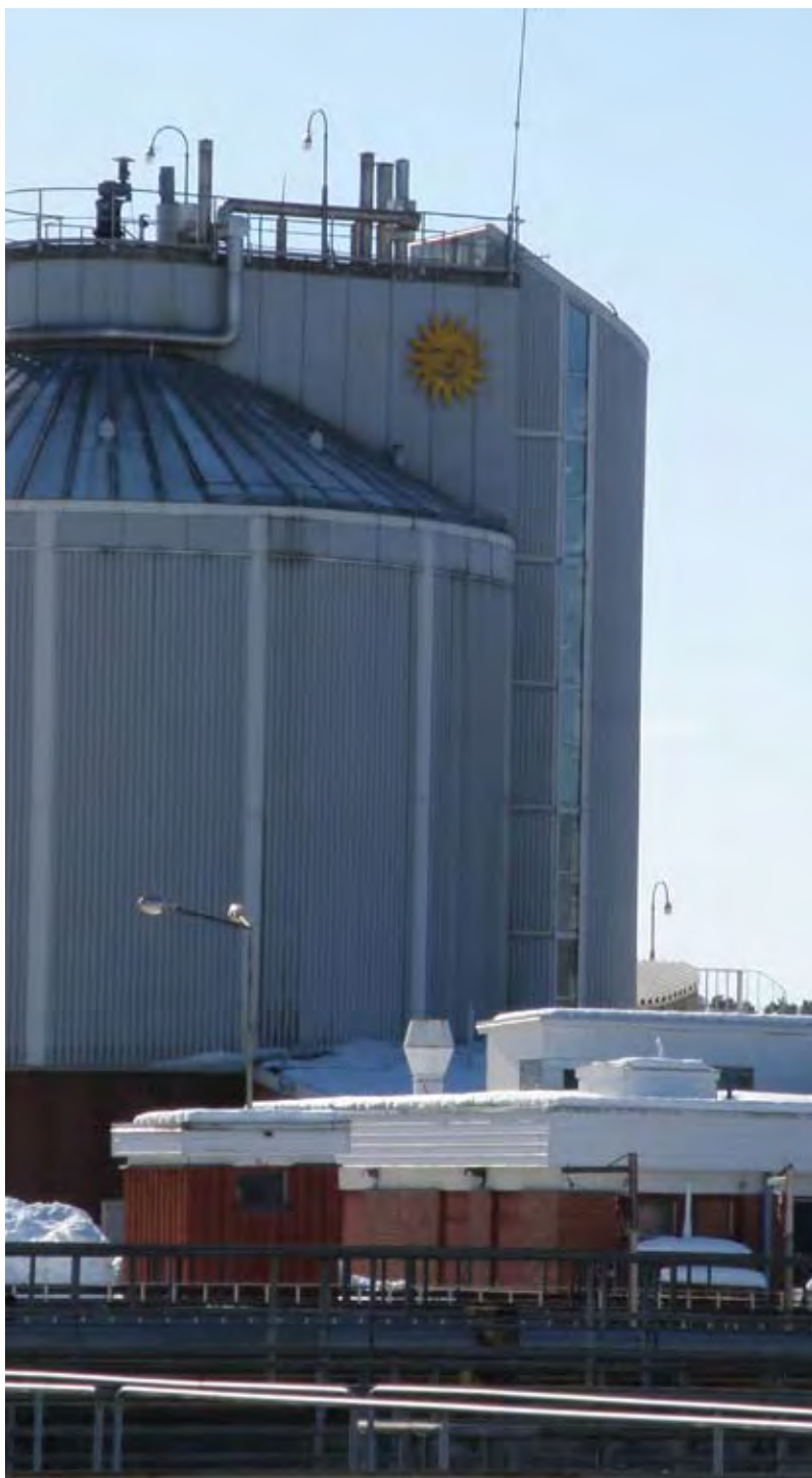
Paroisten jätevedenpuhdistamo. (Juuti & Rajala 2010)
