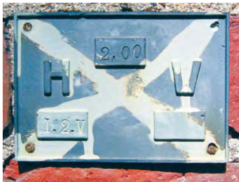
Vanhan Ahveniston vesilaitoksen seinässä on kaksi valkoisella maalilla ruksattua kilpeä. Ruksilla tarkoitetaan, että venttiilit eivät ole enää käytössä. I-kirjain tarkoittaa imupuolta ja V-kirjain tarkoittaa venttiiliä. P-kirjain puolesta tulee sanasta painepuoli. Ilmoitetut etäisyydet ovat metreinä. (HS-Vesi)
