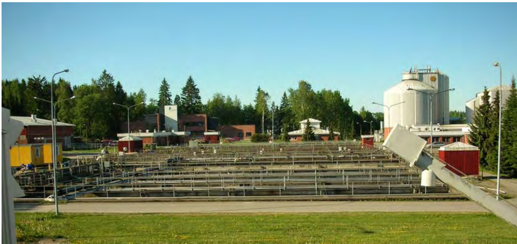
Paroisten jätevedenpuhdistamo 2008. Etualalla ensimmäisen biologisen vaiheen altaat ja taustalla HS-Veden pääkonttori. Oikealla mädättämö. (HS-Vesi)
