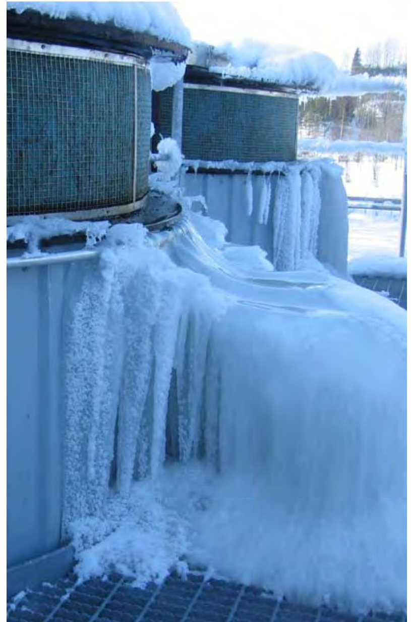
Talvi on hieno vuodenaika Suomessa ja sen aiheuttamat haasteet on huomioitava myös vesihuollossa. Kuvassa Kylmälahden ilmastustornin jäät helmikuussa 2007. (HS-Vesi)
