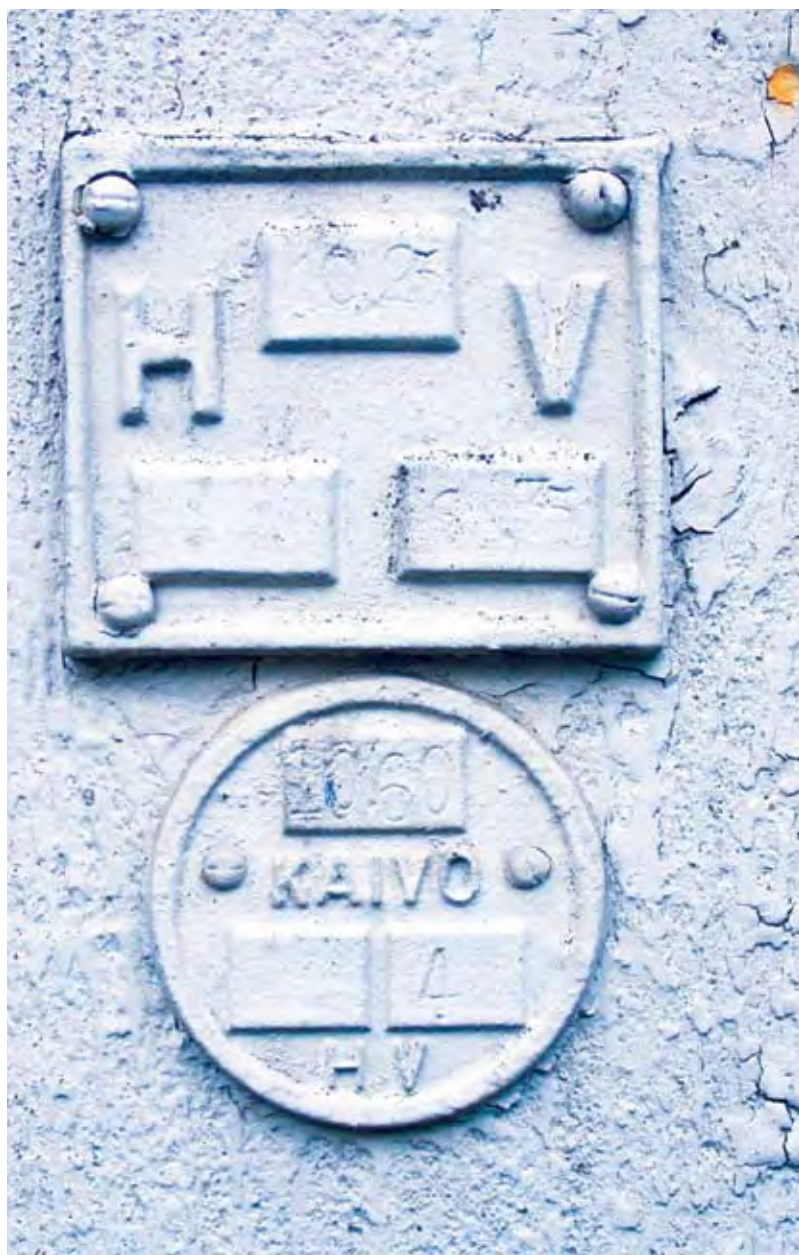
Tämä kilpi on valettu ja tarkoittaa viemärikaivoa. Yhteisesti oli sovittuna, että pyöreä muoto tarkoitti viemäriä. Yläpuolen kilpi kertoo talosulun paikan. (HS-Vesi)
