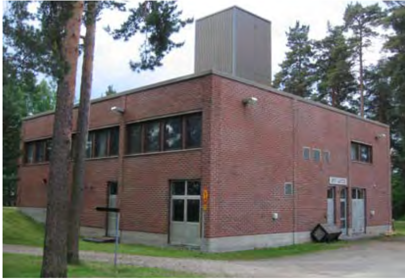
Ahveniston vuonna 1981 valmistunut pohjavesilaitos. (HS-Vesi)
