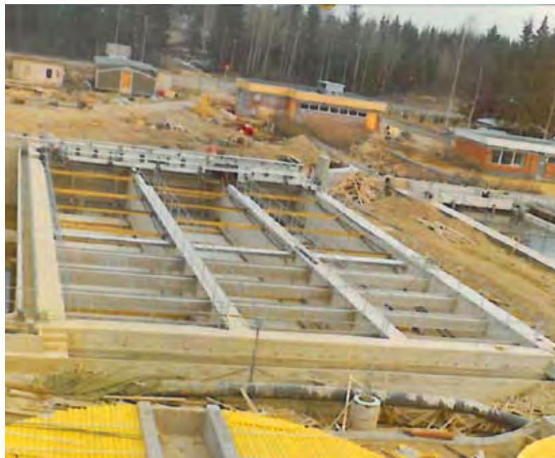
Kuvia Paroistenpuhdistamon laajennuksesta 1970-luvulta. Yläkuvassa vasemmalla Eero Harjula ja vieressä YIT:n mestari Seppänen. Alakuvassa rakentuvat ykkösvaiheen altaat.(HS-Vesi)
