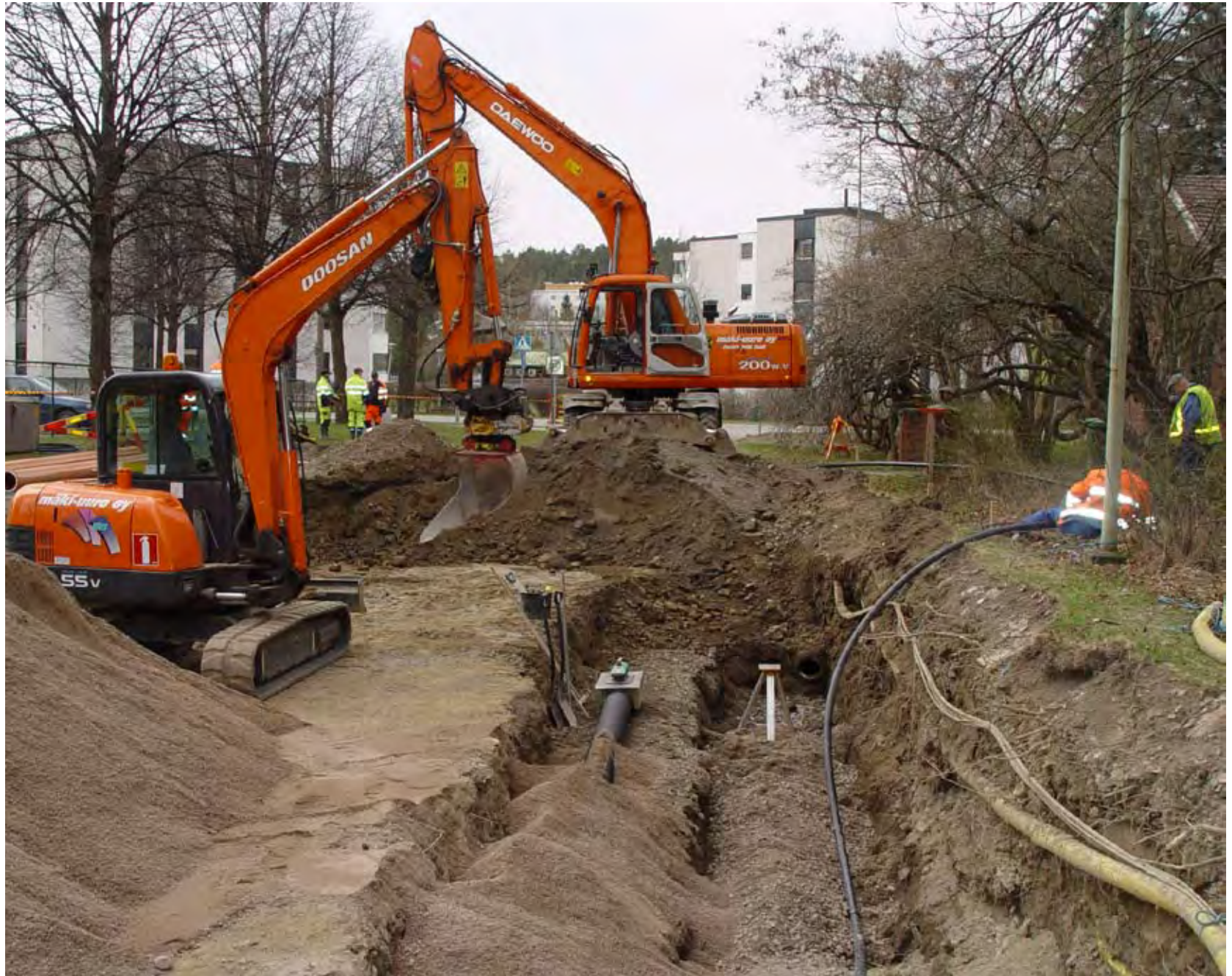
Kadun sekä vesi-, jätevesi- ja sadevesiverkoston saneeraustyömaa Kaurialassa vuonna 2009. (HS-Vesi)
