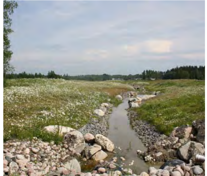
Sammonoja, joka tehtiin alueen sadevesien hallitsemiseksi. (HS-Vesi)
