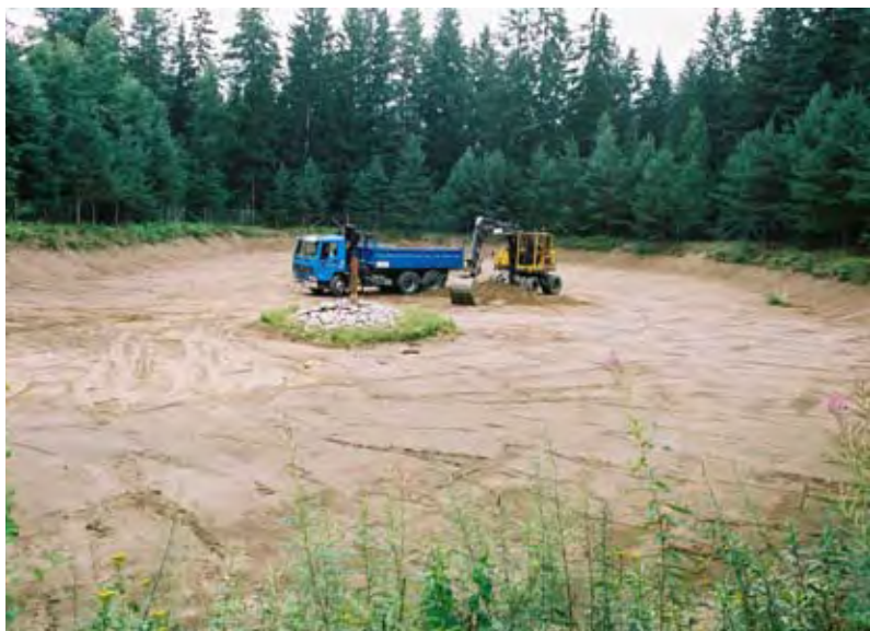
Imeytysallas ykkösen suodatinhiekan vaihto-operaatio vuonna 2001. (HS-Vesi)
