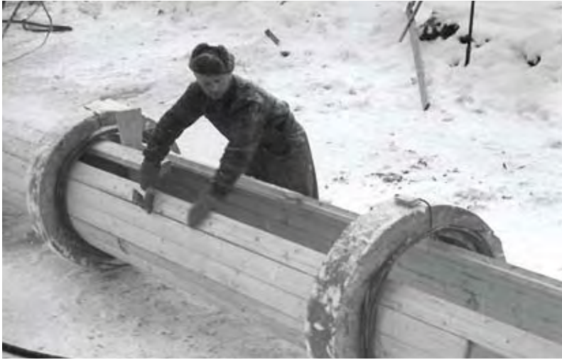
Katuman pintavesilaitoksen imujohto rakennettiin lankuista. Lan- kut sidottiin teräsvantein ja varustettiin betonipainoilla. Imujohdon
