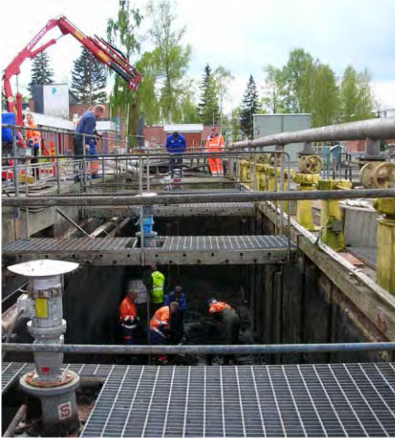
Vuonna 2008 remontoitiin myös rasvanerotusosa. (HS-Vesi)
