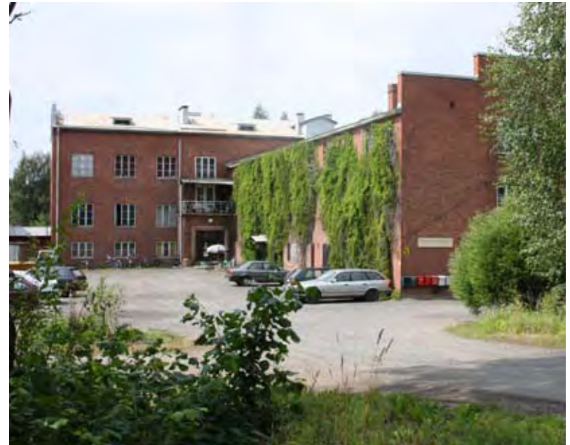
Hattulassa vesihuolto alkoi yksityisten kaivoista. Kunnanvaltuusto pohti vesihuoltoa ensimmäisen kerran 20.6.1949 Marja Oy:n aloitteesta. Kuvassa entisen Marja Oy:n talo vuonna 2010. (HS-Vesi)
