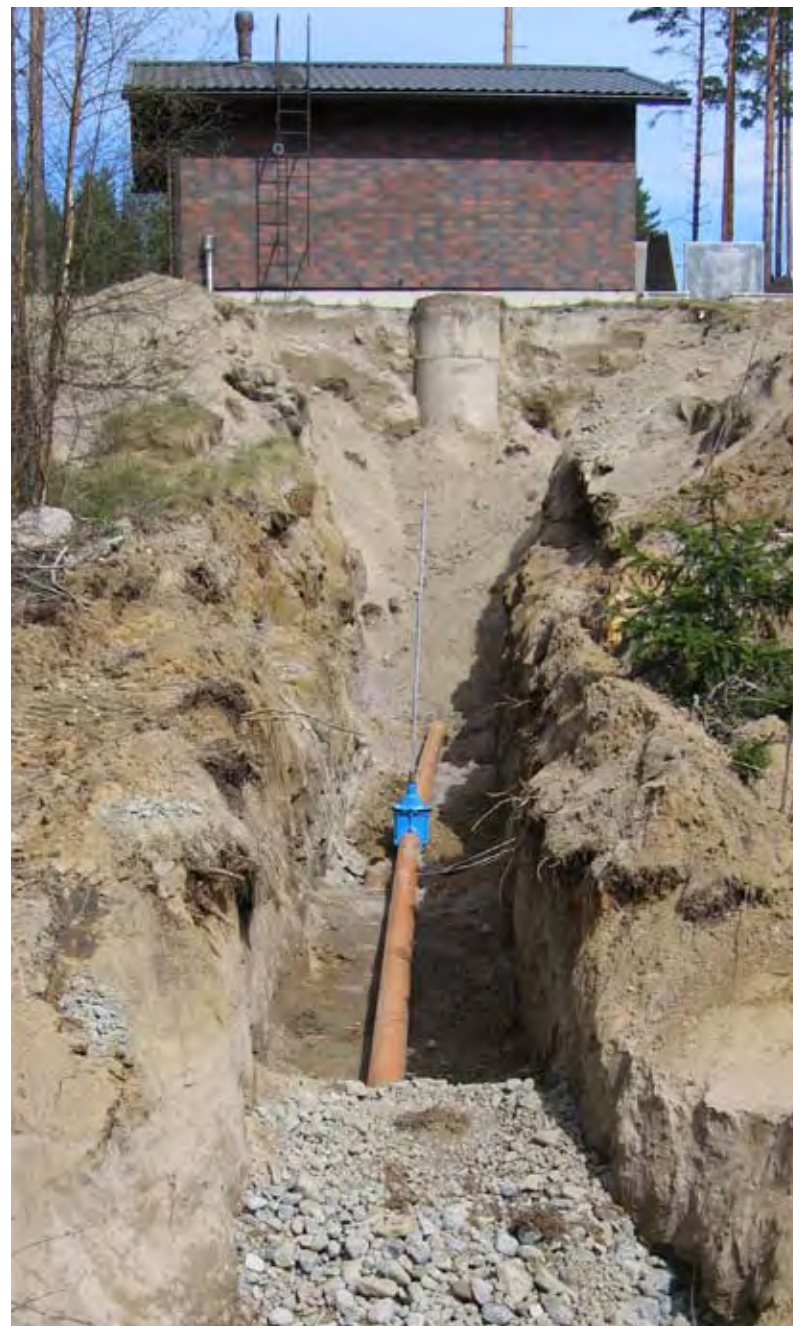
Hakonnummen ala-altaan tyhjennysputken rakentaminen. (HS-Vesi)
