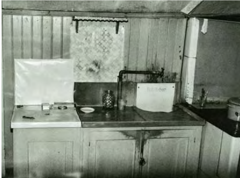
Kuva keittiöstä osoitteesta Lukiokatu 25 on tietojen mukaan vuodelta 1979. Vesihuoltoalan suurmiehen Robert Huberin nimi on tiskipöydän kaatokulpoissa. Likavedet kaadettiin kaatokulppoon ja ne menivät viemäriä pitkin pois talosta. (HKHM Pietilä K.)
