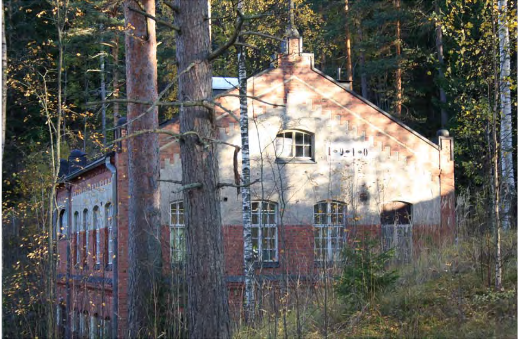
Ahveniston vesilaitos alkoi pumpata vettä vuonna 1910. Kaunis rakennus on edelleen pystyssä vuonna 2010. (HS-Vesi)
