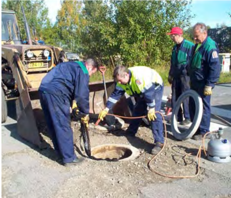
Kaivon nosto 2000. (HS-Vesi)
