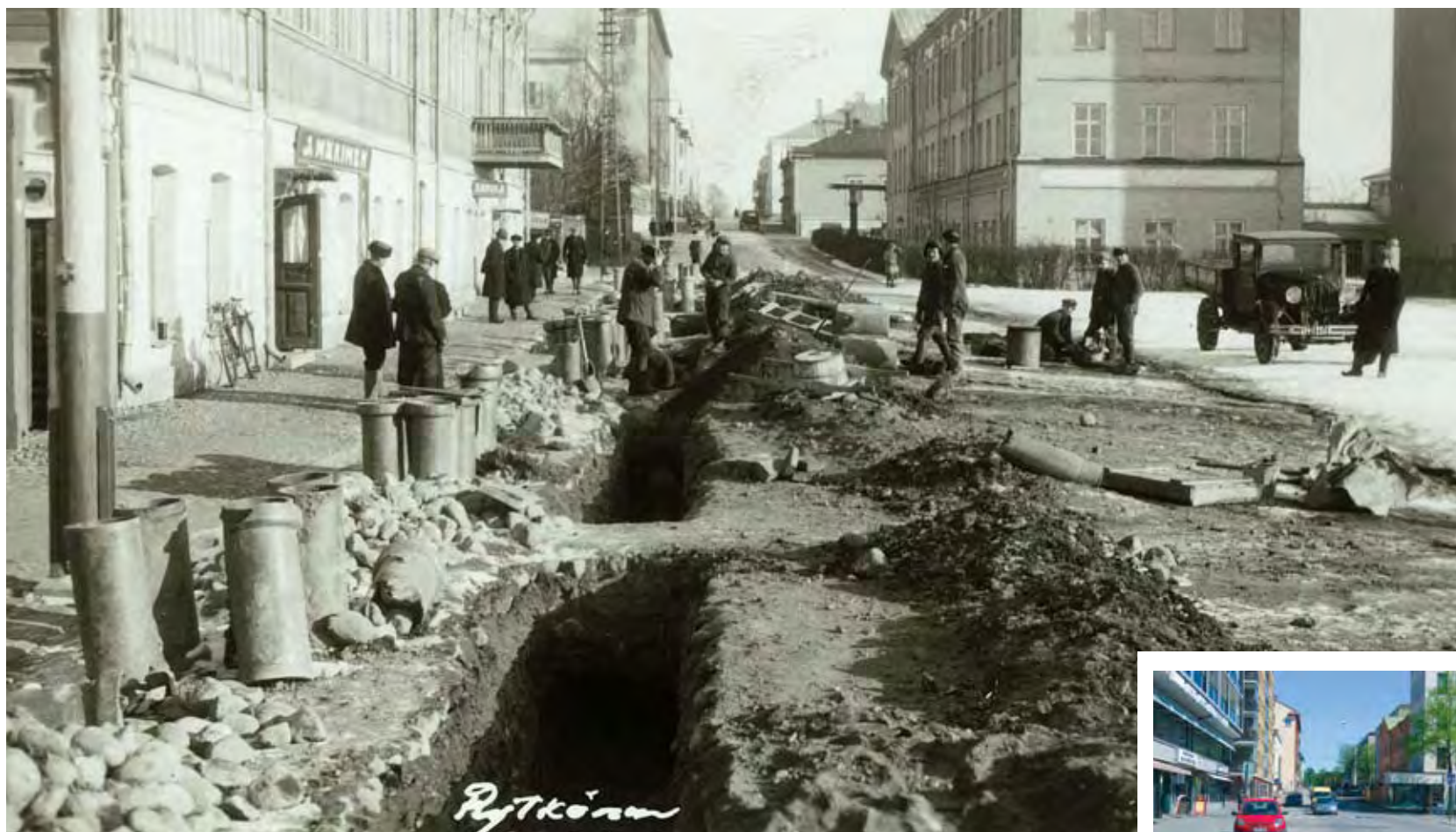
Kuvassa asennetaan Palokunnankadun viemäriä linja-autoaseman kohdalla vuonna 1934. Putket ovat lasitettuja saviputkia. (HKHM)
