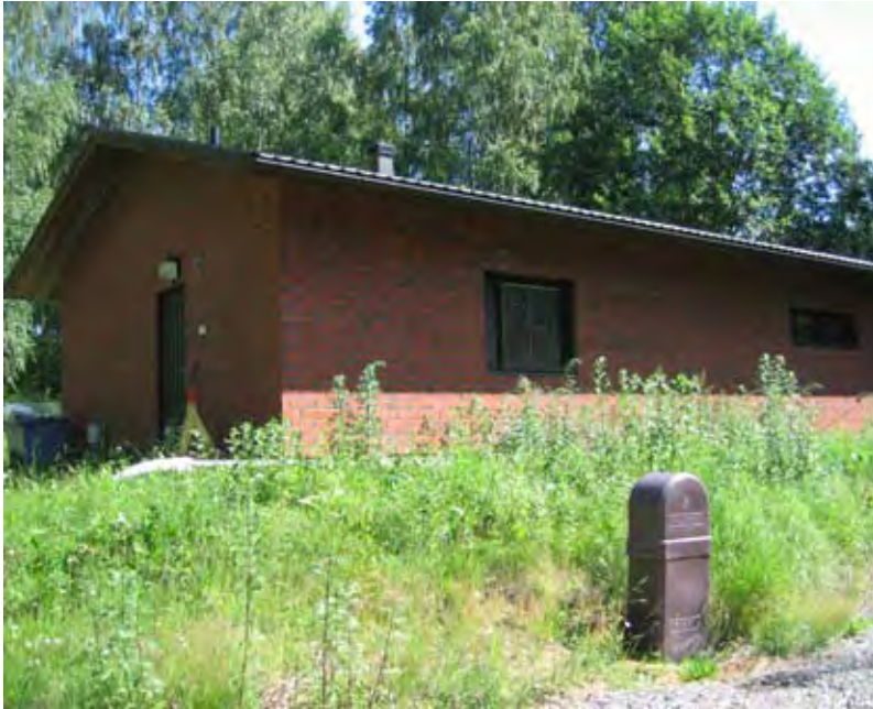
Kalkkonen pohjavedenottamo. Rakennuksen edessä on palovesiposti. (HS-Vesi 2006)
