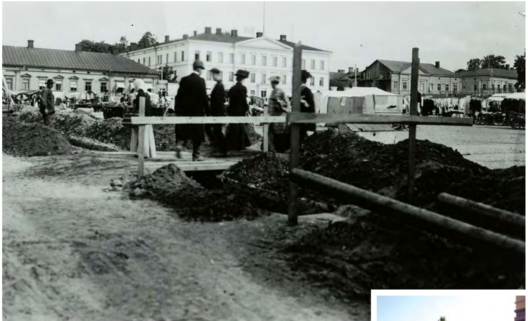
Vuonna 1910 vesijohtolaitoksen työt olivat edenneet Läntiselle Linnankadulle (myöh. Sibeliuksenkatu), jossa asennettiin vesijohtoa ja paineviemäriä. Rytkösen talo rakenteilla taustalla. Käytetyt putket olivat Mannesmanin menetelmällä valssattuja teräsputkia. Etualalla 125 mm vesijohtoputki ja paksumpi 150 mm paineviemäri. (HKHM)
