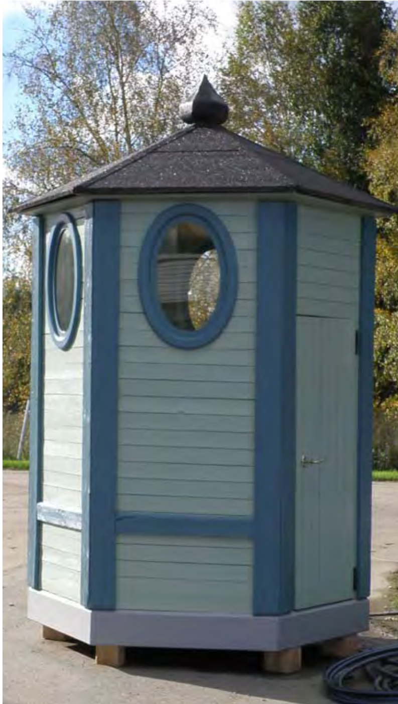
Ahveniston kaivo vuonna 1910 muistutti muumitaloa. Kaivorakennus on entisöity muistuttamaan vanhasta ajasta. (HS-Vesi)
