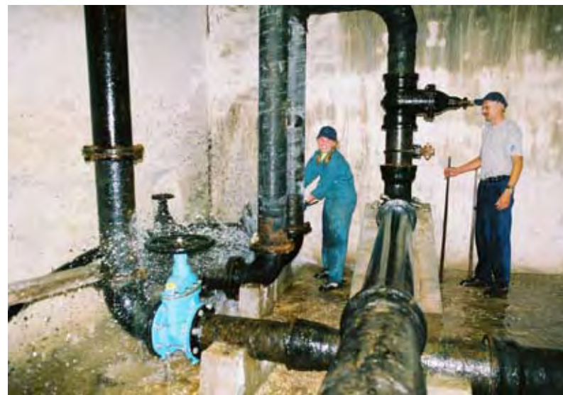
Ahveniston vesitornin ja säiliön pesu. Kuvassa on pesun jälkitilanne, jossa vaihdetaan pesun yhteydessä rikkoutunutta venttiiliä. Kuva on 2000-luvun alusta. (HS-Vesi)
