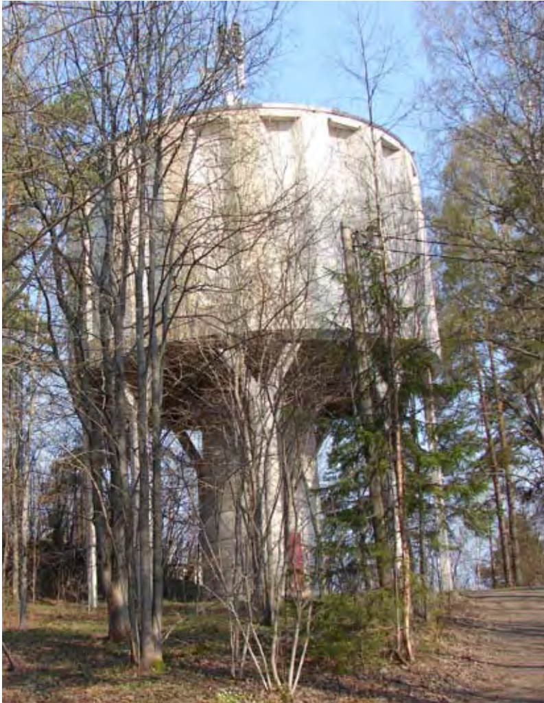
Lammin vesitorni on rakennettu vuonna 1973. Tornin tilavuus on tuhat kuutiometriä. (Asola 2003: kuva HS-Vesi)
