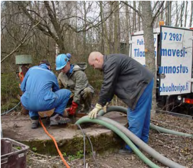
Kaivojen puhdistus 28.4.2004. Kaivoon vaihdettiin pohjahiekka. (HS-Vesi)
