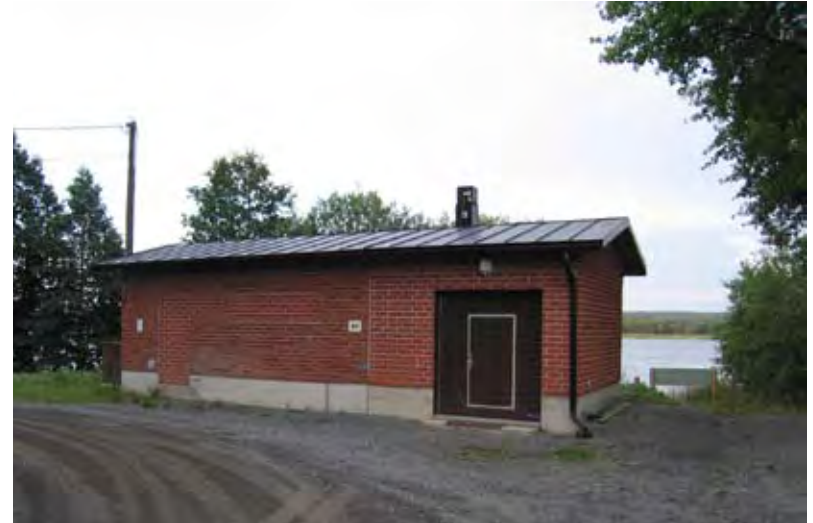
Kalvola, Sepänkaarten pohjavesilaitos, jossa raakavesi alkaloidaan lipeällä ja vesi desinfioidaan UV-käsittelyllä. (HS-Vesi 2006)
