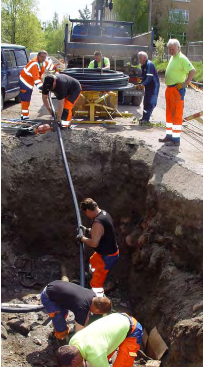
Vesijohdon sujutustyömaa vuodelta 2009. (HS-Vesi)
