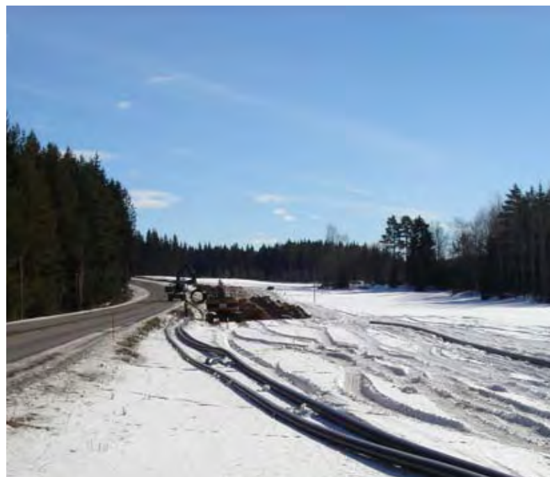
Yhteistyö kuntien vesihuollossa alkoi Hämeenlinnan seudulla jätevesien puhdistuksesta. Kuvassa Hauhon jätevedenpuhdistamo, joka ei ole enää käytössä ja rakennus on purettu. Alakuvassa Hauholta Paroille tulevan siirtoviemäriin rakennustyömaata. (HS-Vesi 22.3.2005)
