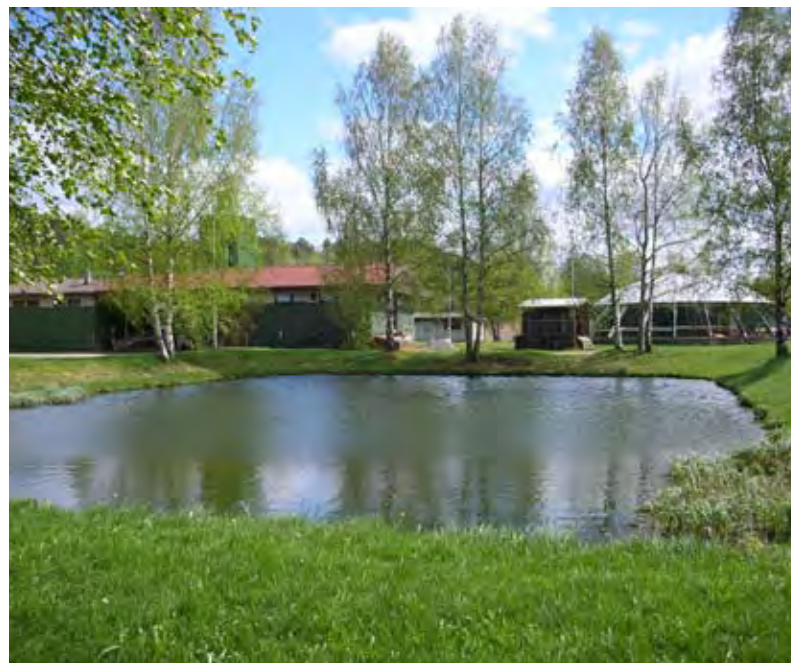
Lammin jätevedenpuhdistamo. (HS-Vesi 2008)
