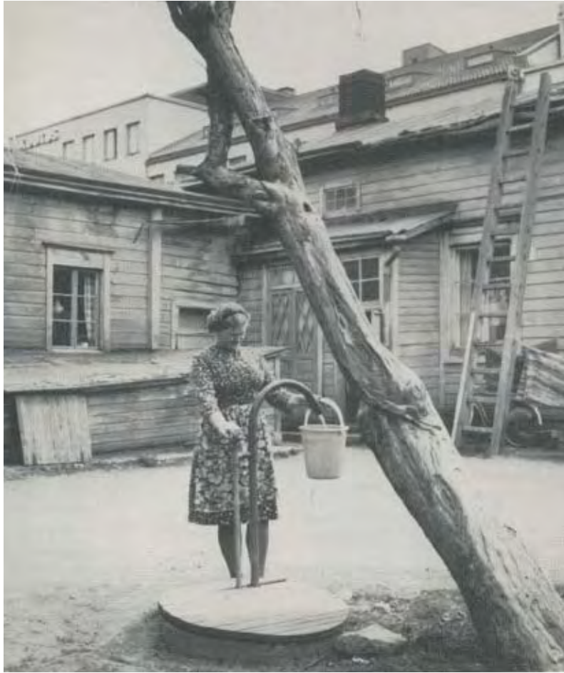
Siirtymävaiheen ratkaisu. Ämpäriin otetaan vesilaitoksen vettä. Huomaa ämpärille tarkoitettu koukku. Kuvassa Raatihuoneenkatu 12:n pihapiiri vuonna 1965. (Maunula 1989)
