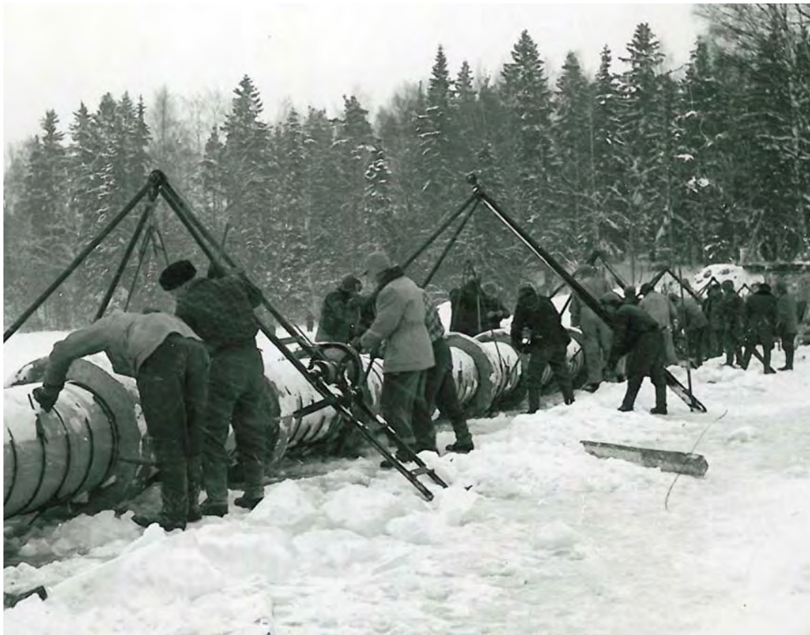
Katuman pintavesilaitoksen imujohto laskettiin järveen kolmijalkojen avulla. Uuden vedenkäsittelylaitoksen koekäyttö alkoi 7. marraskuuta 1955 ja vettä pumpattiin ensi kerran verkostoon marraskuun 12. päivä. 112 Kuvassa imujohdon lasku Katuman pumppuasemalla 18.2.1955. (HS-Vesi)
