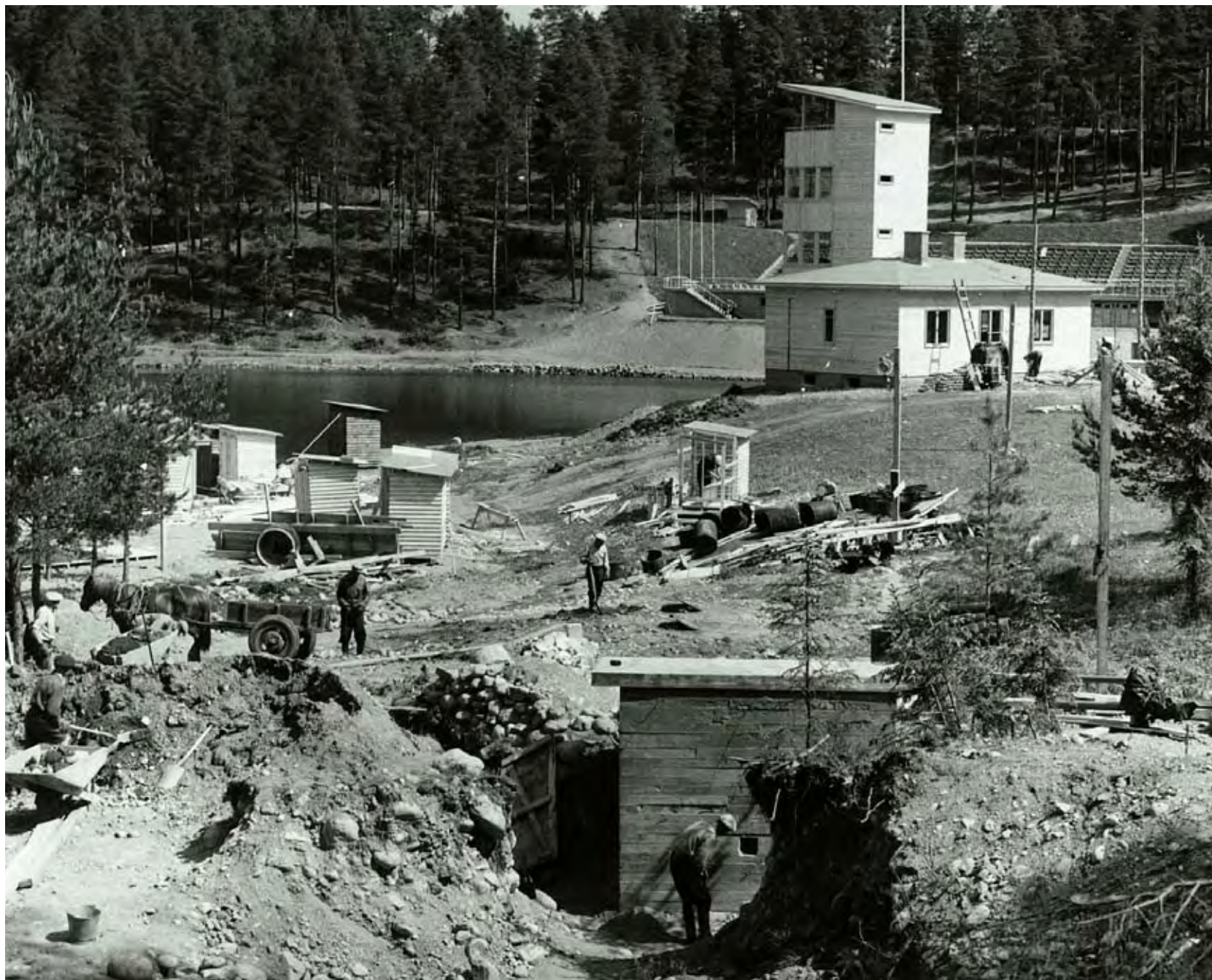
Ahveniston uimalan rakennustyöt. Maauimala ja valvontatornikahvila ovat valmiina. Kuvan etualalla luultavasti menossa saostuskaivon rakennustyöt. Kuva 1950-luvulta. (HKHM Olympiakuva Oy)
