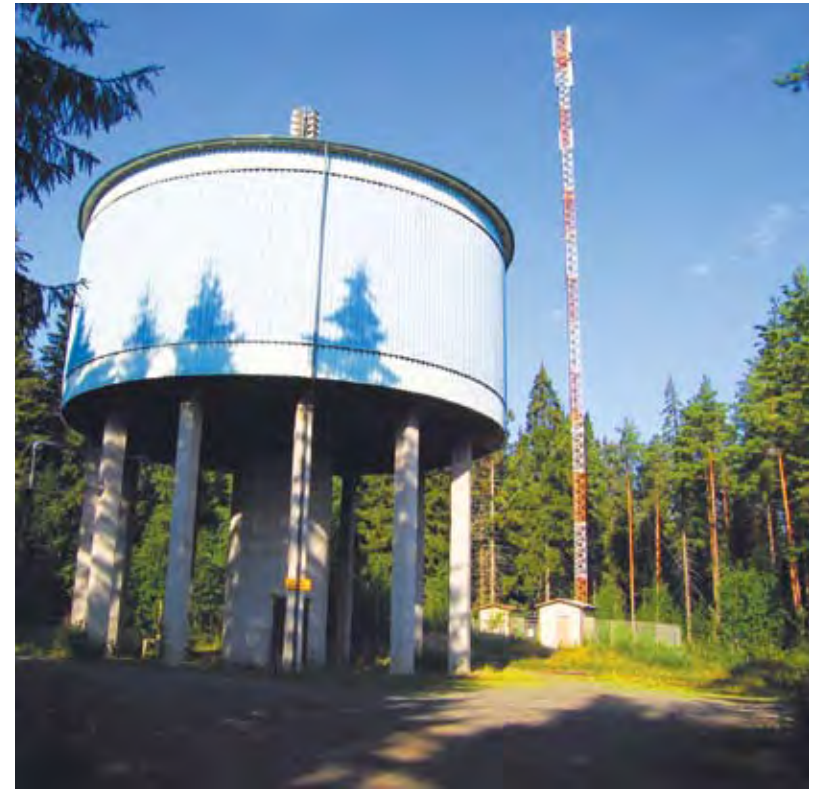
Kalvolan vesitorni on rakennettu vuonna 1976. Pääurakoitsijana oli Perusyhtymä ja arkkitehtuurista vastasi P. Helkiö. Tornin tilavuus on 800 kuutiometriä (Asola 2003; kuva: HS-Vesi 2006)
