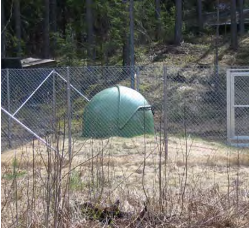
Kuvassa toinen Hakonnummen raakavesikaivoista, joka on rakennettu vuonna 1999. (HS-Vesi 2004)
