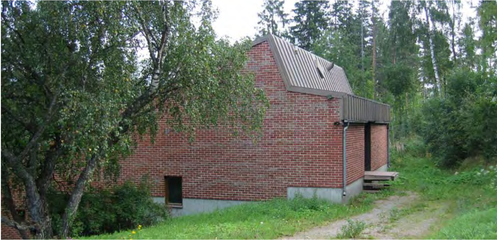
Kylmälahden pohjavedenottamo, joka valmistui 1969. Kuva on vuodelta 2004, joten myöhemmin rakennetut ilmastustornit eivät näy vielä rakennuksen seinustalla. (HS-Vesi)
