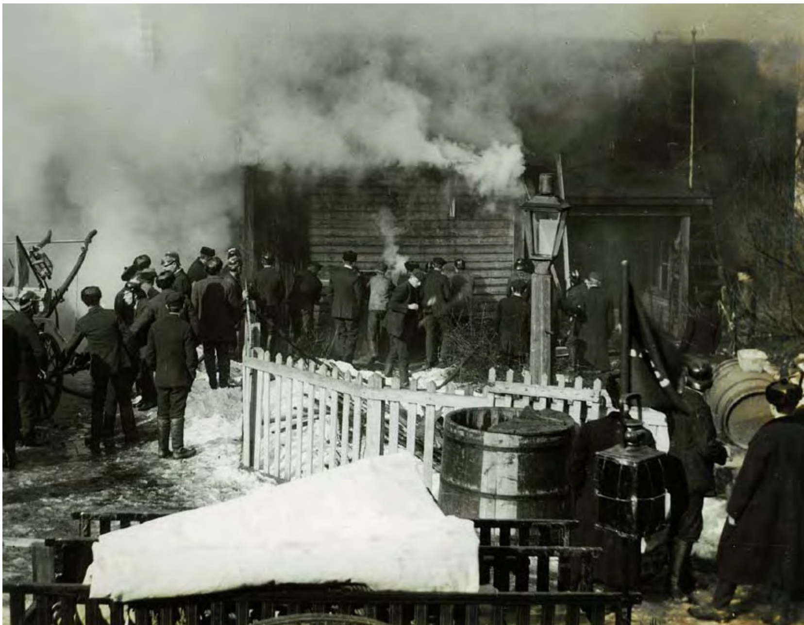
Stierin valokuvaamon palo 2.3.1910 eli muutama kuukausi ennen vesijohdon vetoa. Paikka on Linnakatu 10 - Birger Jaarlinkadun kulmassa. Huomaa palokalusto: vasemmalla hevosen paikalle kuljetama ruisku ja paloletkua pitelee sammutusosasto. Paineesta ei ole tietoaakaan. (HKHM Rytönen E.)
