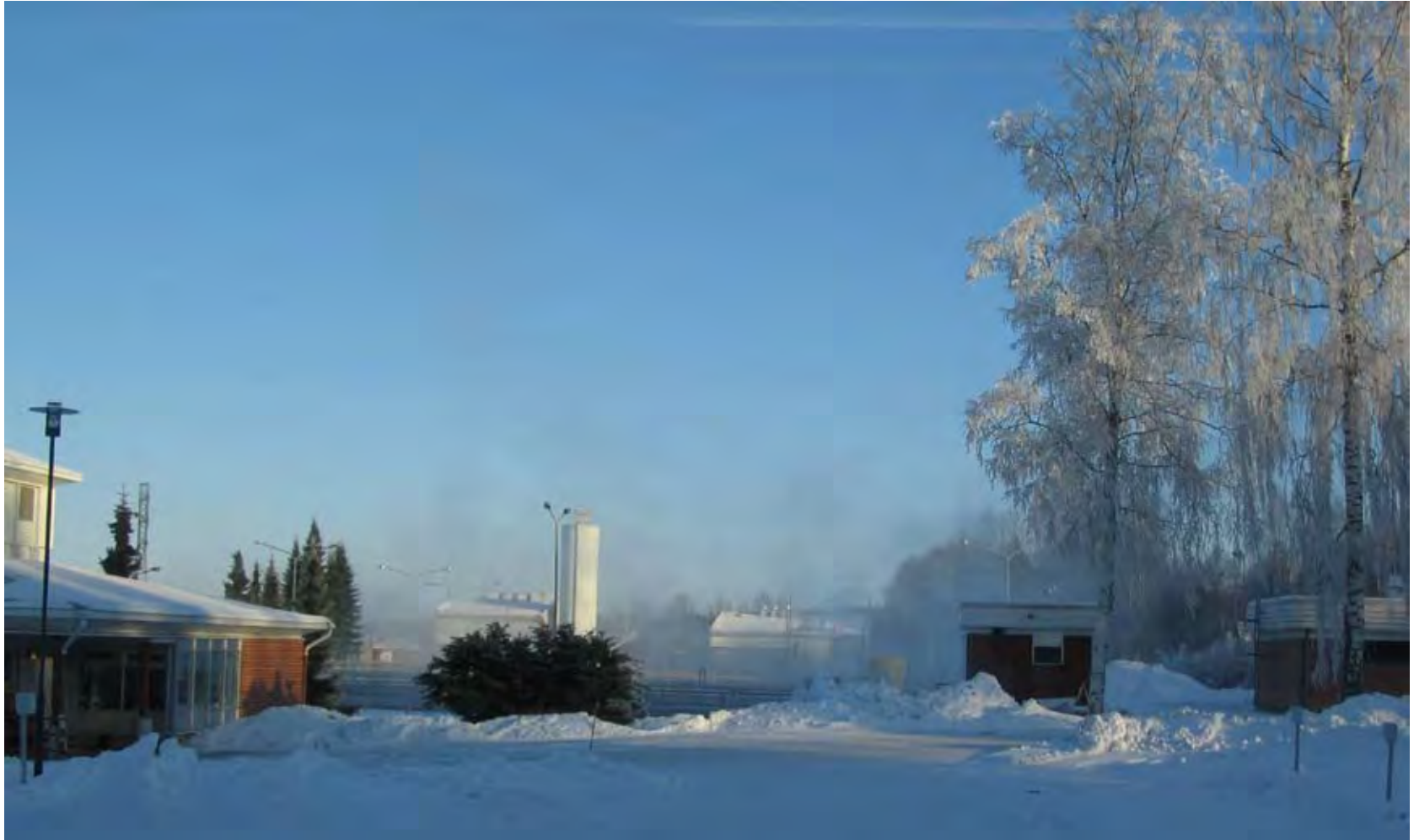
Talvinen maisema Paroisten puhdistamolta. (HS-Vesi)
