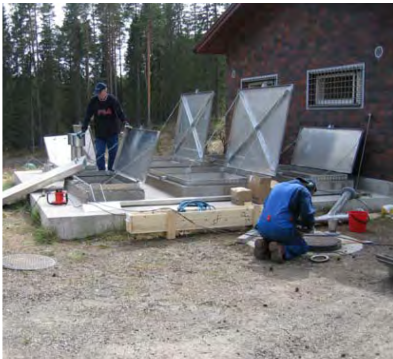
Hakonnummen kalkkialtaan huuhtelujärjestelmän korjaus. (HS-Vesi)
