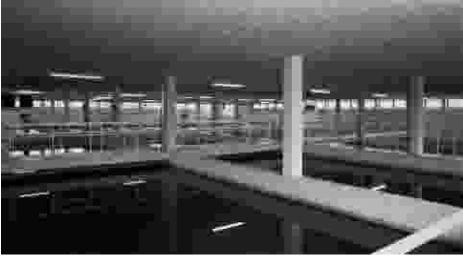
Kuva 7.6c. Dämmanin pintavesilaitoksella oli aluksi käytössä ns. Lovö-tyyppinen vaakaselkeytys. (Espoon Vesi)
