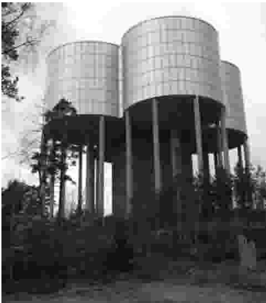
Kuva 9.11. Espoonlahden vesitorni valmistui vuonna 1995. Tornissa on neljä kiinteästi toisiinsa liitettyä lieriöosaa. (Juuti 2006)
