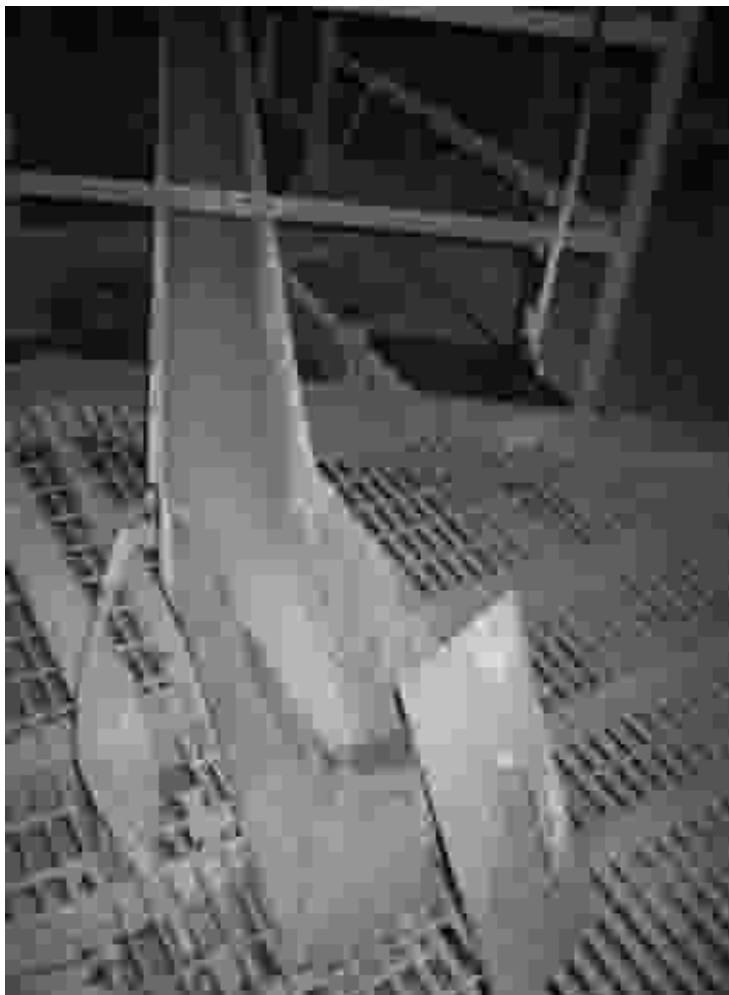
Kuva 7.21. Kuvassa kalkin syöttöpiste Dämmanin pintavesilaitoksella. (Juuti 2006)
