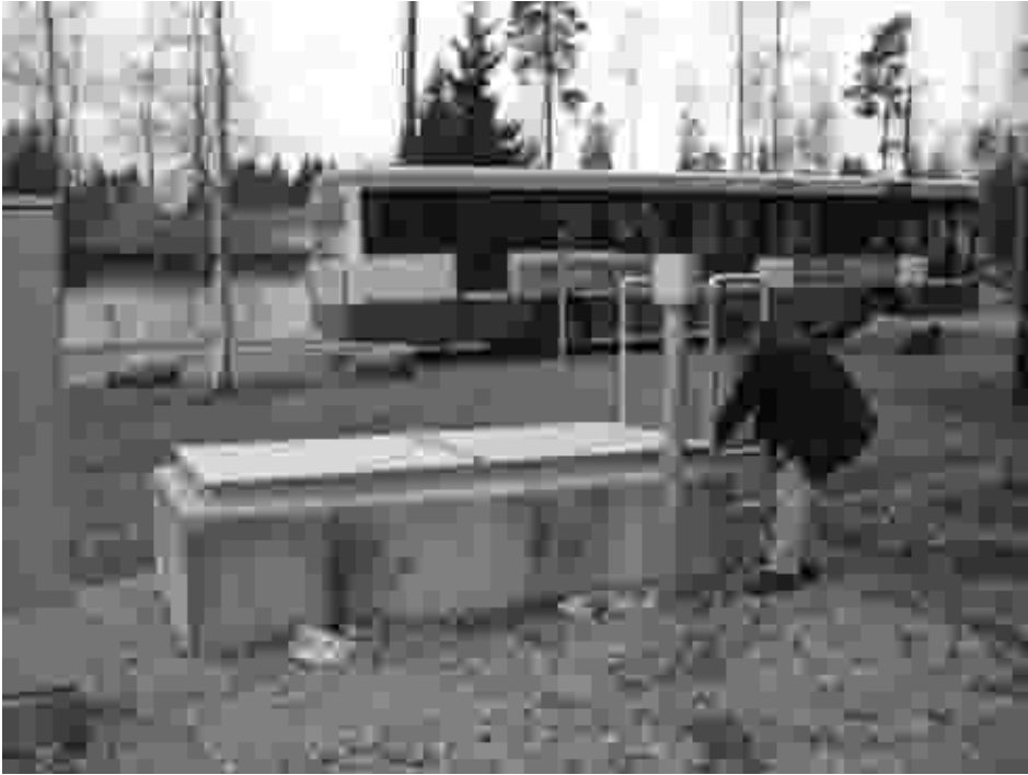
Kuva 10.14. Espoon Veden Kaskipuun mittauskaivo löytyy tämän luukun alta. Petteri Jokinen on menossa tarkistamaan, jotta paikat ovat kunnossa. (Juuti 2006)
