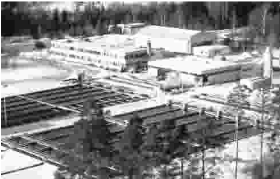
Kuva 8.24. Kuva Suomenojan jätevedenpuhdistamolta ennen typenpoistolaitoksen rakentamista vuonna 1996. Taustalla näkyy ”kaarevakattoinen” Suomen Ympäristökeskuksen tutkimusasema. Sen edessä vasemmalla puhdistamon yhteinen valvomo ja laboratoriorakennus, jonka viereisessä rakennuksessa sijaitsee ruuvipumppaamo. (Espoon Vesi)
