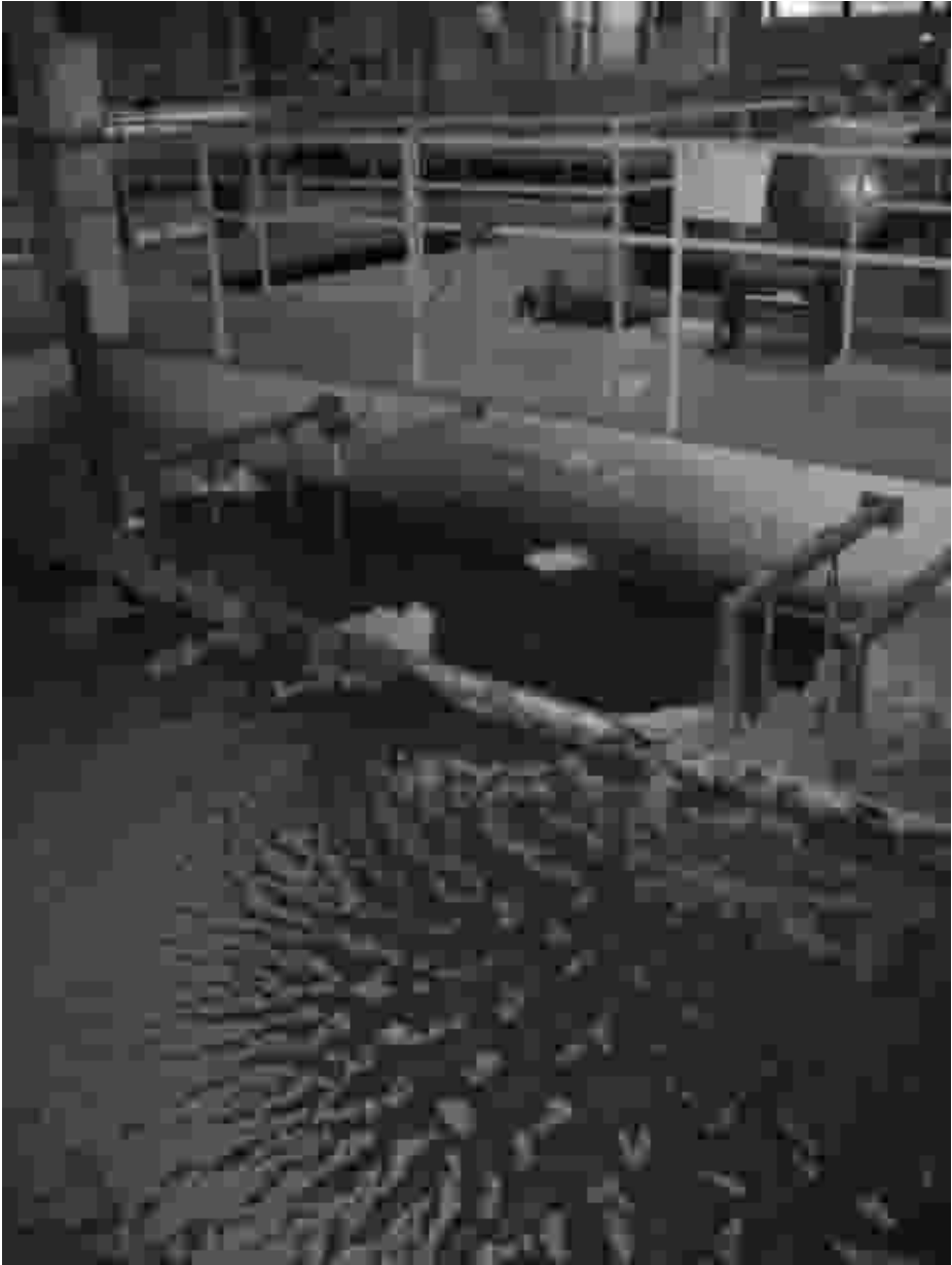
Kuva 7.18. Vuonna 2000 Dämmanin vedenkäsittelylaitoksella siirryttiin vaakaselkeytyksestä flotaatioon. Kuvassa flotaatioallas. Flotaatiossa veteen johdetaan pieniä ilmakuplia, jotka kiinnittyvät poistettaviin partikkeleihin ja nostavat ne veden pinnalle. (Juuti 2006)
