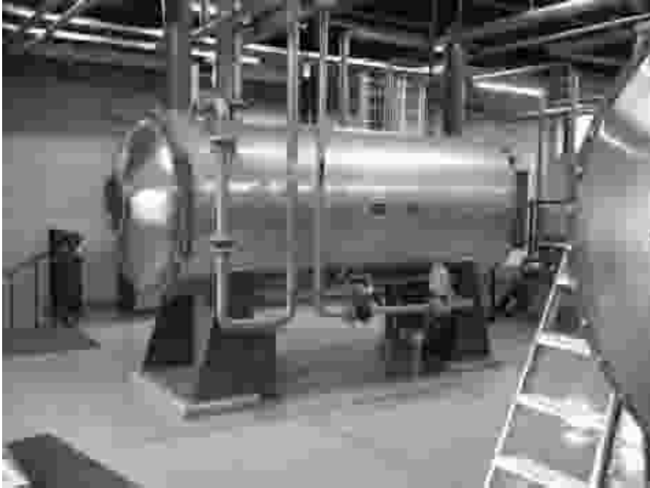
Kuva 7.16. Otsonointi aloitettiin Dämmanin vesilaitoksella kesäkuun viimeisellä viikolla vuonna 1979. Kuvassa toinen otsonointilaitteista. (Rajala 2006)
