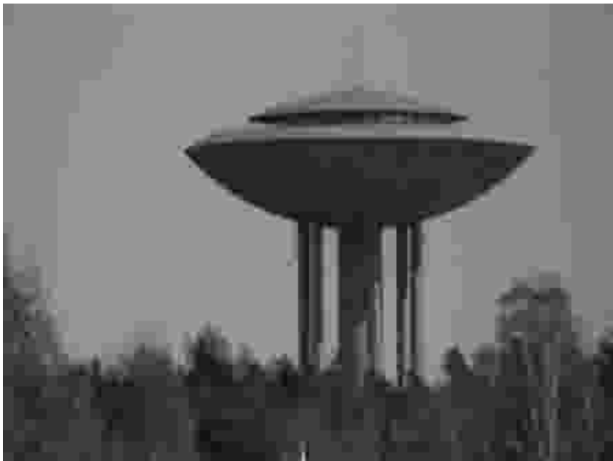
Kuva 5.8. Haukilahden pallokalotin muotoinen vesitorni valmistui vuonna 1968. (Juuti 2006)
