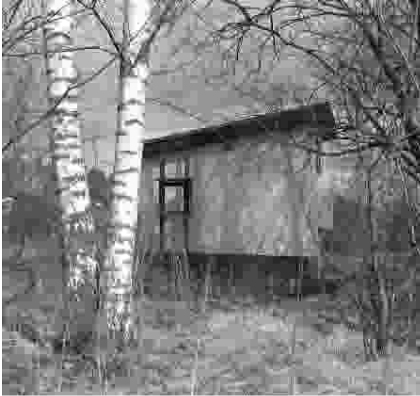
Kuva 9.14. Puolarmetsän pumppamorakennus vuonna 2006. Pohjavedenot- tamon käytöstä on luovuttu vuonna 1995. (Rajala 2006)
