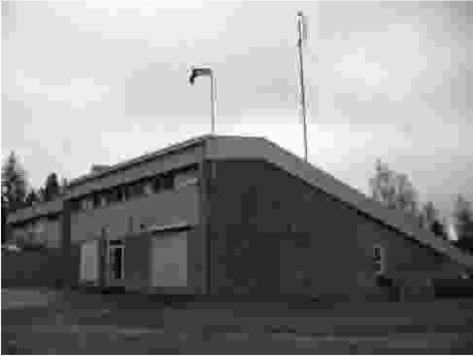
Kuva 6.2. Bodomin vesilaitoksen toiminta päättyi 1998. Kuvassa pintavesilaitoksen rakennus vuonna 2006. (Juuti 2006)
