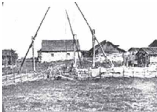
Kuva 20: Kolmen vintin kolhoosikaivo Kiteeltä. Fig. 20: Collective well with three counterpoise lifts from Kitee. [A III, B IV] ©Erkki Jormanainen
