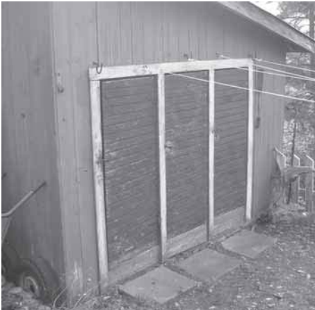
Kuva 85: Sarjakäymälä Pispalasta (Tampere), työväestön asuinalueelta. Jokaisella asunnolla oli oma käymäläkoppinsa. 1930-luku. Fig.85: From Pispala (Tampere), suburban area mostly inhabited by workers, the outhouse with several toilets – one booth for each flat. 1930s. [DIV,E III]
