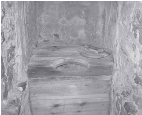
Kuva 61: Käymälän istuin, rakennettu myöhemmin. Fig. 61: Seat, constructed afterwards.
