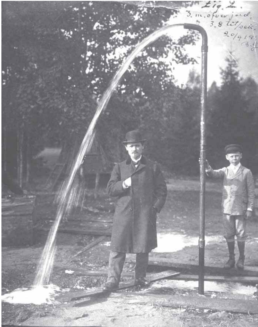
Kuva 44: Putkikaivo 1900-luvun alusta, Karjalan kannaksella. Kuvassa DI B. Gagneur (1874–1966).
