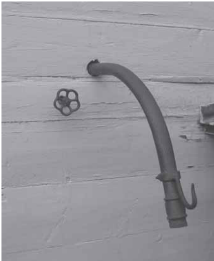
Kuva 88: Vesilaitoksen vettä “seinästä”. Vesi johdettiin alkuvaiheessa yleensä pihaan, vasta myöhemmin sisälle. Hamina.
