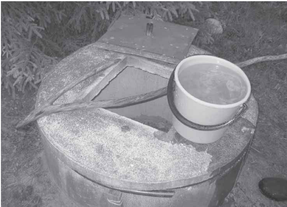
Kuva 5: Betonirenkainen kuilukaivo, kaivohaka ja ämpäri. Ruokolahti. Fig. 5: Dug well with concrete ring, bucket pole and bucket. Ruokolahti. [A III, B III]
