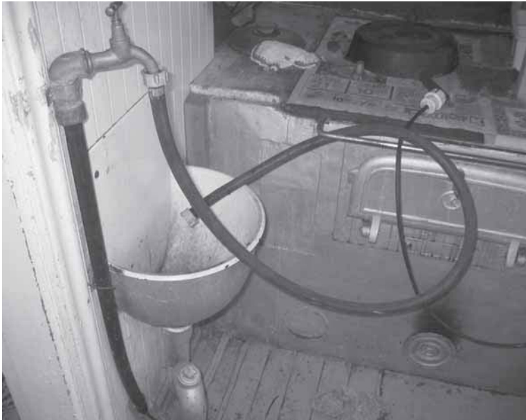
Kuva 87: Kaatokulppo, Pohjanmaa. Vesi kuilukaivosta sähköpumpulla. (ks. taulukko F) Fig. 87: Simple (sewer)sink, Ostrobothnia. Water from well. (see table F) [A III, B VIII]
