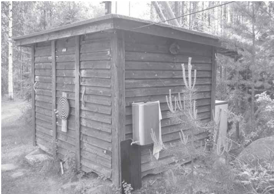
Kuva 36: Vaatimattoman näköinen, mutta asiallisesti hoidettu käymälä. Huomaa käsienvesupaikka. Ruokolahti. Fig. 36: Modest, but functional – there is even a wash basin on the wall. Ruokolahti. [D III]
