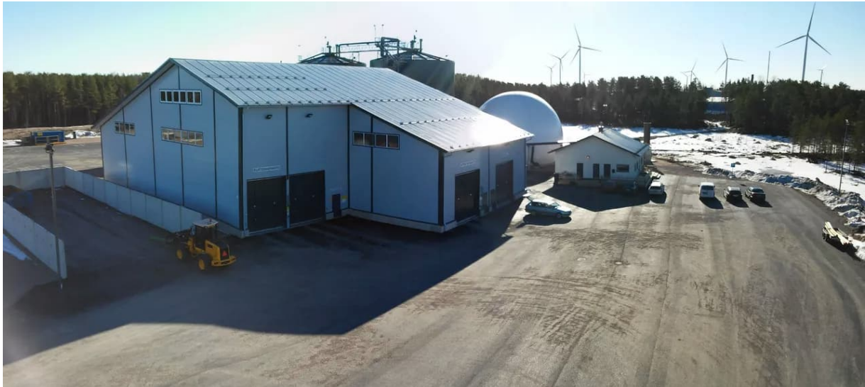
Kuva 4. Honkajoen biokaasulaitos (Gasum Oy 2023).
