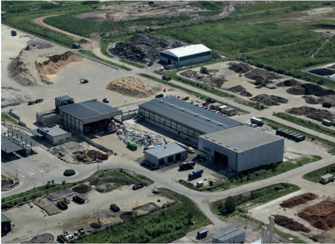
Kuva 2. LATE-lajittelulaitos ulkoapäin (Päijät-Hämeen Jätehuolto Oy)
