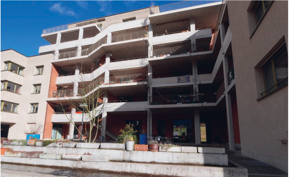
Kuva 18. Heizenholzin yhteisöasumisen kohde, Zürich. Porrashuone laajenee parvekkeiksi, joilla välttämätön liikkuminen, valinnaiset parvekeviljelmät ja sosiaalinen oleilu ja kohtaamiset yhdistyvät. Kuva vuodelta 2018.
