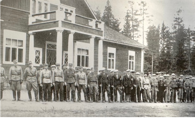
vasemmalla: Rakennus suojeluskuntatalona vuonna 1941, Pertunmaan kunnan veteraanimatrikkeli
