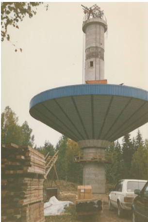
Kuva 73 yllä vasemmalla: Ylävesisäiliön nosto, AP
