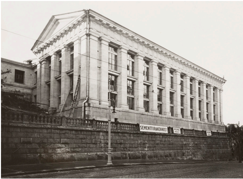
Kansallisarkiston laajennus valmistuttuaan. Kuva: Kuvaaja ei tiedossa, 1928. MV HK/ HK19730318:263.
