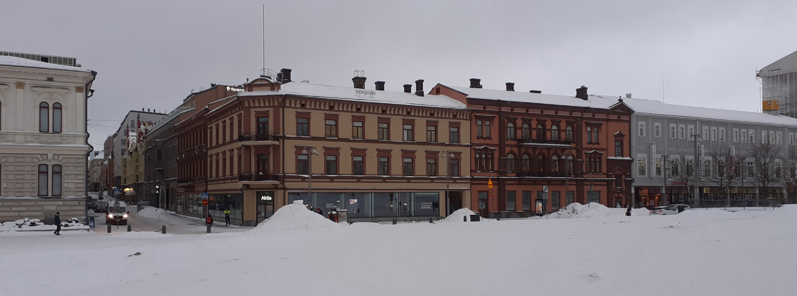
Tampereella Keskustorin laidalla sijaitsevaan Sandbergintaloon (kuvassa kolme rakennusmassaa ruskea-kellertävä-punertava) palautettiin alkuperäinen väritys nykyaikaisella dispersiomaalilla. Kuva: Aamu Koivistoinen, 2024.
