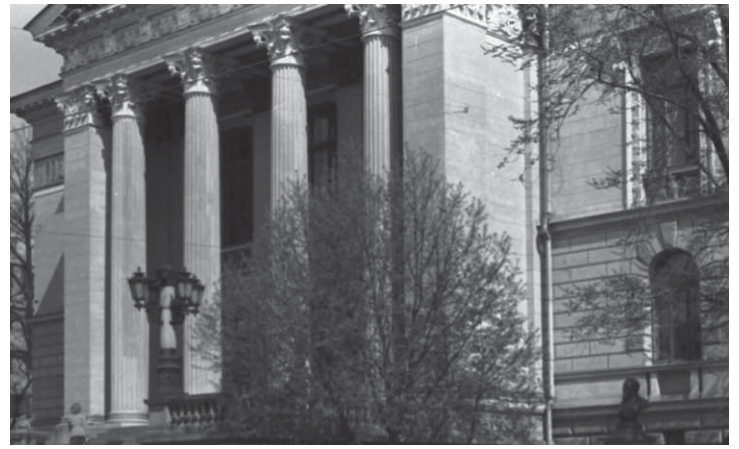
yllä Keskirisaliitin kapiteelit uusittuina ja pintakäsittelemättöminä. Kuva: Eeva Rista, 1975. HKM/ser531733.
