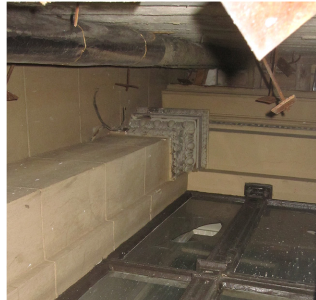
Kansallisarkiston aktirakennuksen julkisivun osa, joka on jäänyt piiloon tutkijarakennuksen korotuksen myötä vuonna 1928. Kuva: Anni Hassi, 2018.
