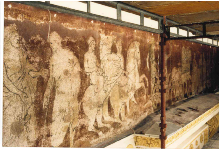
Kulkuefriisin kunnostuksessa osa alueista jouduttiin kokonaan maalaamaan uudelleen aiempien kalkkikopioiden avulla. Kuva: Säätytalon julkisivujen dokumentointi 10.11.1993.
