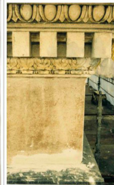
yllä ja alla Kapiteeli ja kipsireliefein koristeltu friisinauha ennen ja jälkeen kun- nostuksen. Kuva: Säätytalon julki- sivujen dokumentointi 10.11.1993.
