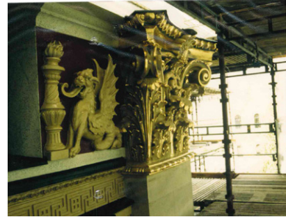
yllä ja alla Kapiteeli ja kipsireliefein koristeltu friisinauha ennen ja jälkeen kun- nostuksen. Kuva: Säätytalon julki- sivujen dokumentointi 10.11.1993.
