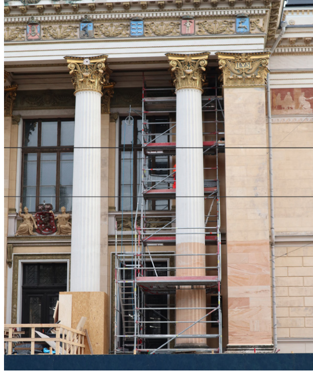
Keskirisaliitin mallialueen pylväessä on käytetty silikonihartsiemulsiomaalia ja seinäpinnassa kalkkimaalia.
