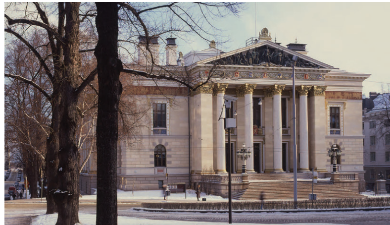
Korjaus valmistunut. Kuva: Simo Rista. Kuva lainattu teoksesta Säätöyhtalo - the House of Estates, 1999.
