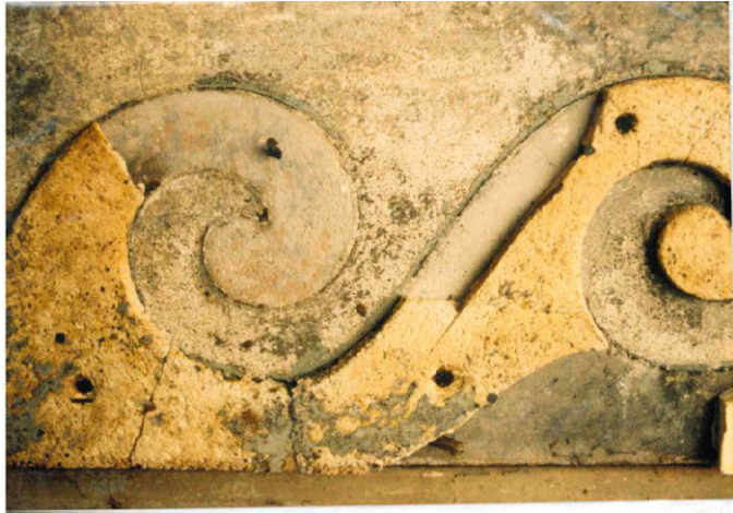
Juokseva koira - kipsikoristeen alta löytyneitä kerroksia. Kuva: Säätytalon julkisivujen dokumentointi 10.11.1993.
