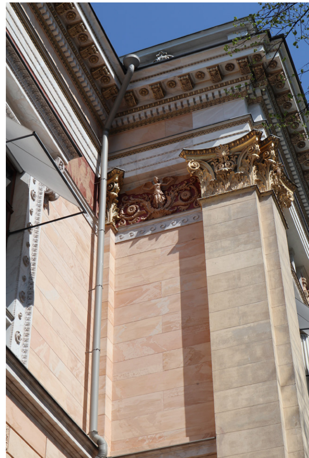
Vuoden 2020 mallialueen väriajaukset seinän yläosassa sekä räystäällä. Kuva: Aamu Koivistoinen, 2023.
