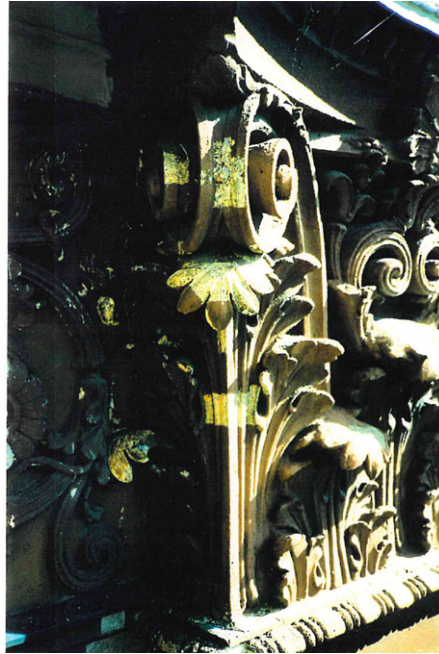
Kapiteelin kultauksen esiin otto. Kuva: Säätytalon julkisivujen dokumentointi 10.11.1993.
