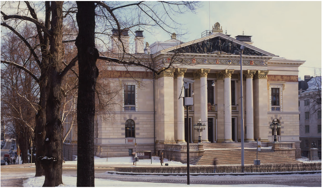
Korjaus valmistunut. Kuva: Simo Rista. Kuva lainattu teoksesta Säätytalo - the House of Estates , 1999.
