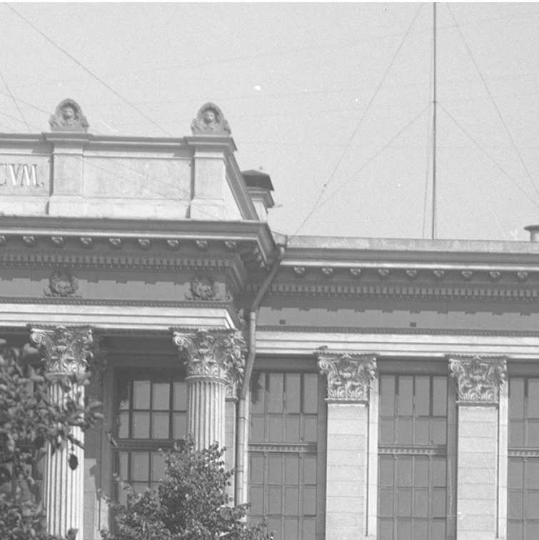
Kansallisarkiston julkisivun yläosan sävyerot. Kuva: Daniel Nyblin, 1890-99. MV HK/ HK7878:73. Kuvaa rajattu.
