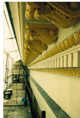
yllä ja alla Kapiteeli ja kipsireliefein koristeltu friisinauha ennen ja jälkeen kun- nostuksen. Kuva: Säätytalon julki- sivujen dokumentointi 10.11.1993.
