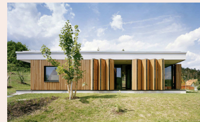
Avattavat seinät/ikkunaluukut
