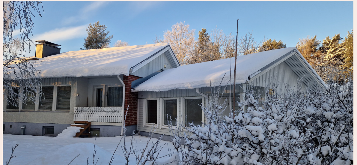
Kuva 41 Laajennus Huikkaan alueelta, jossa on käytetty eri julkisivumateriaalia kuin päärakennuksessa
