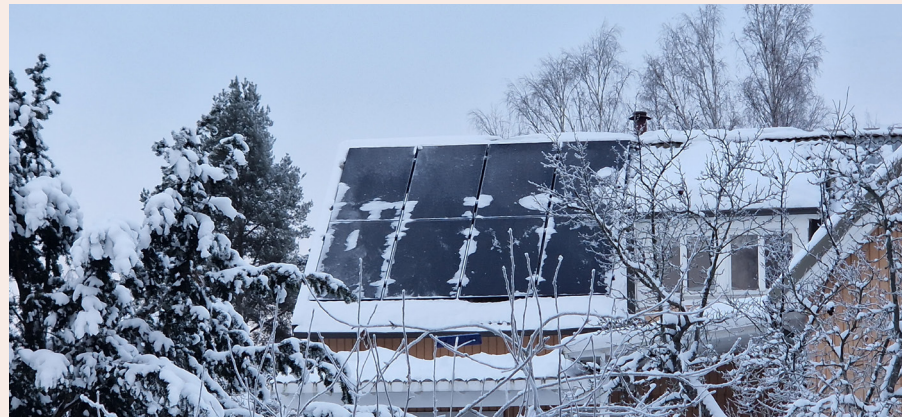
Kuva 66 Aurinkopaneelien asennustapa katon lappeen suuntaisesti
