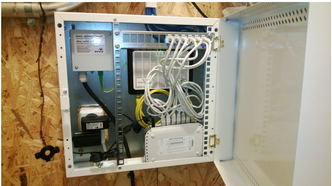
Kuva 5. Teknisen tilan jakamo, missä valokuitu menee kuitumuuntimelle, jolta se jaetaan Ethernet-kaapeleilla rakennuksen eri huoneisiin (Kotikarhuvuorelle 2013)
