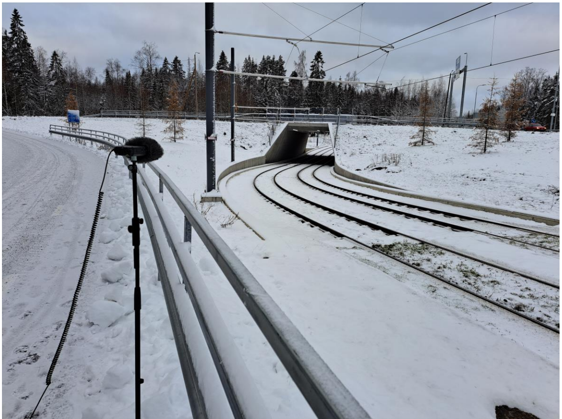
Kuva 14 Mittausjärjestelyt Ruskonkehän alikulkutunnelin kohdalla 16.11.2023
