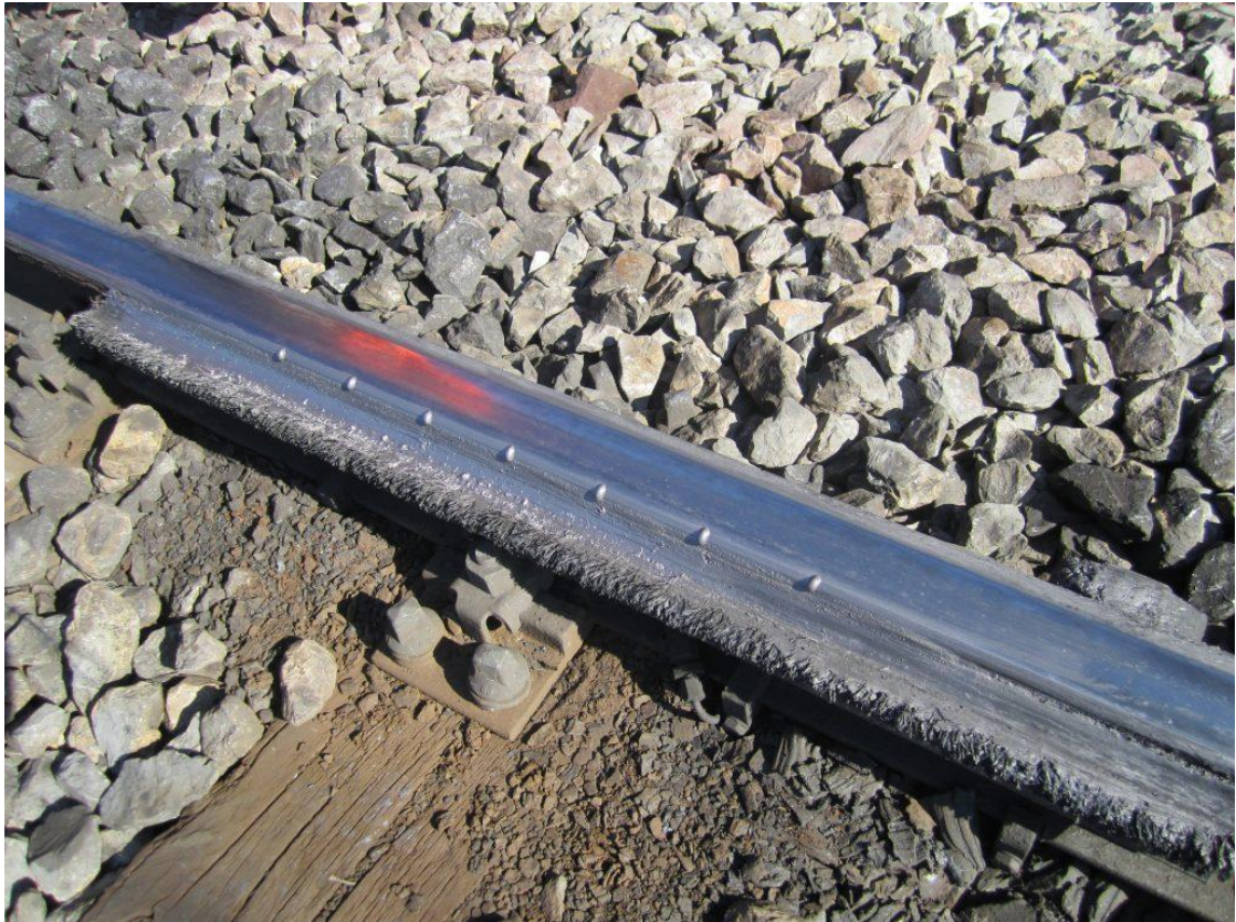
Kuva 3 Kiskoon asennettu voitelulaite (ELPA d.o.o. 2023)
