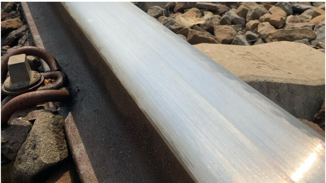
Kuva 5 Akustisesti hiottu kisko (RailTechnology GmbH ei pvm.)
