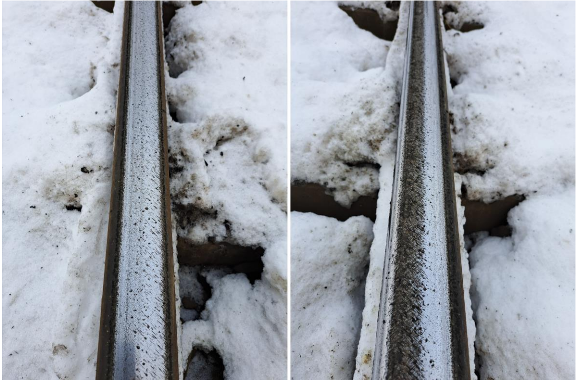
Kuva 15 Ruskonkehän alikuluttunnelin äänityspaikan kiskot 16.11.2023. Vasemmalla sisä- ja oikealla ulkokisko.
