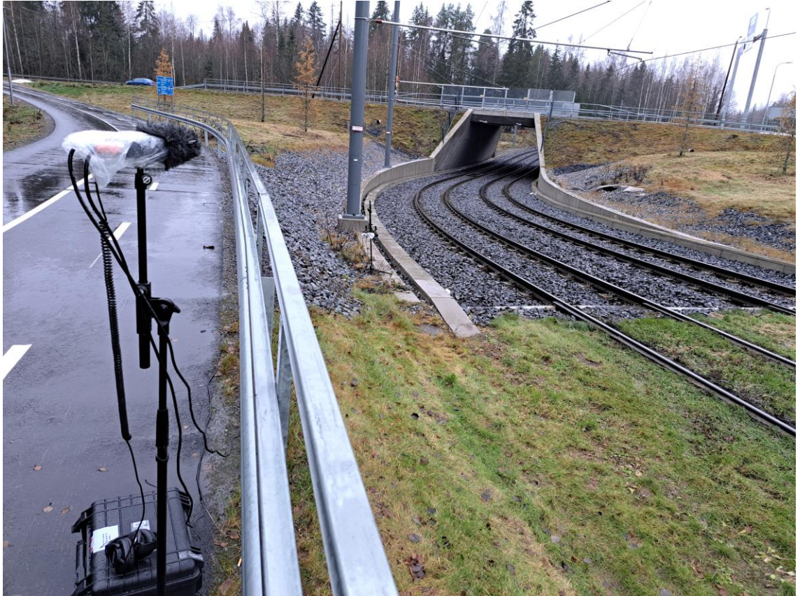
Kuva 12 Mittausjärjestelyt Ruskonkehän alikulkutunnelin kohdalla 10.11.2023.
