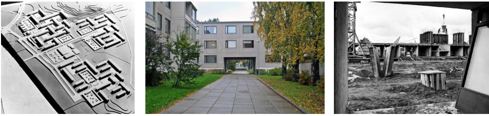
Kuvat 64–66: Siltämäen kompaktilähiö: Pienoismalli, jalkenkulkuakseli ja ruutusandwich-julkisivuja sekä rakennusvaiheen suurmuottivalua ratanosturin avustamana.
