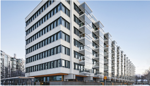
Kuva 112: Yleisradion entinen pääkonttori (Kurt Simberg, 1968) muutettiin trendimukaisesti asuinkäyttöön. Julkisivun perusidea säilytettiin muutoksessa, joskin alkuperäinen klinkkerilaattapinta vaihtui struktuuriltaan vastaavaan silikonimuottivaluun. Rasiaparvekkeiden soveltuvuus nauhajulkisivulle lienee makuasia, mutta toisaalta ne indikoivat toiminnon muutosta muuten peruspiirteiltään säilytetyllä julkisivulla. Rakennus on säilynyt muutoksessa tunnistettavana.
