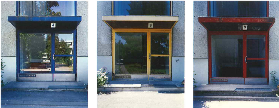
Kuva 40: Porraskäytävien väriaiheita Helsingin Siltamässä. Värejä käytettiin opasteina ja toimintojen indikaattoreina. Erityisesti lähiöissä painotettiin myös kirkkaiden väriaiheiden psykologista merkitystä.
