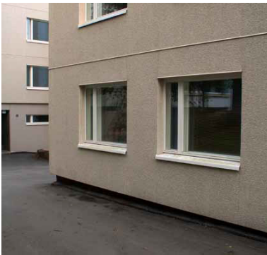
Kuvat 82 ja 83: Alkuperäisen julkisivupinnan imitointia verhoukorojauksilla.
