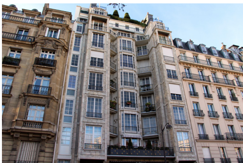
Kuva 9: Auguste Perret: 25 bis rue Franklin (Pariisi 1909).
