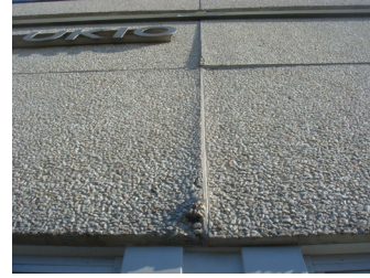
Kuva 74: Pakkasrapautumisen aiheuttamaa elementtien paisu-mista sekä saumojen puristu-mista ja lohkeilua.
