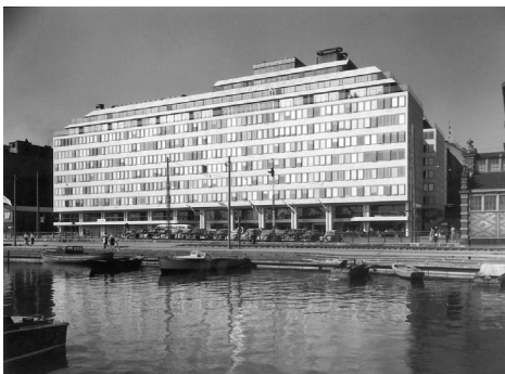
Kuva 36: Viljo Revell ja Keijo Petäjä: Teollisuuskeskus (Helsinki 1952). Rakennuksen esivalmisteinen julkisivu edusti aikanaan merkittävää edistysaskelta.
