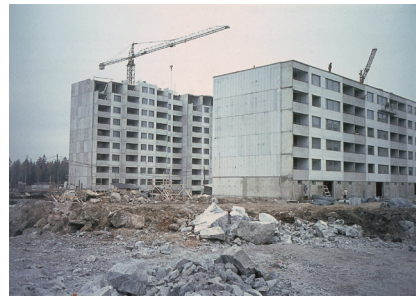
Kuva 56: Tyypillistä 1970-luvun ruutuelementti-tuotantoa, tosin sisäänvedetyillä parvekkeilla ja melko nauhamaisella julkisivuilmelällä. Rakentamisen mittakaava tyypillisesti kasvoi alkuperäisistä suunnitelmista.
