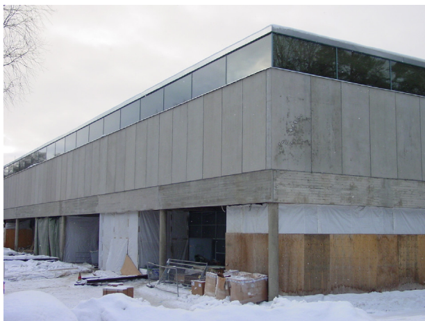
Kuva 110: Rakennuksen logiikalle luonteva korjaustapa saattaa vaihdella rakennusosan mukaan. WG:n entisen painotalon ulkoseinien betonielementit uusittiin ja paikalla valetut osat kunnostettiin, kun rakennus muutettiin museokäyttöön. Uusien elementtien oikean sävyn löytämiseen kiinnitettiin tarkkaa huomiota. Vanha painotalo on 1990-luvun alussa päättyneen alkuperäiskäytön jälkeen joutanut monenlaiseen käyttöön, mutta säilynyt tunnistettavana. (ks. Jetsonen & Lehtinen s. a.)
