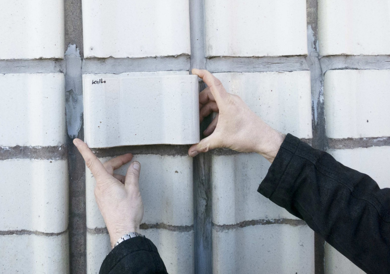
Kuva 84: Julkisivulaattojen mallitarkastelua Helsingin kaupunginteatterin korjauksessa.
