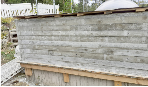
Kuvat 100 ja 101: Mantteloinnilla toistettua lautamuottipintaa ja muottipinnan mallitarkastelua Kuhmoisten siunauskappelissa (Hyyrynen 2022).
