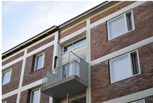
Kuvat 82 ja 83: Alkuperäisen julkisivupinnan imitointia verhoukorojauksilla.
