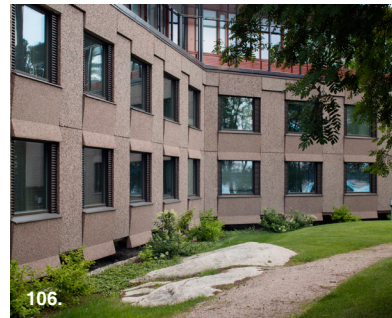
Kuvat 104 ja 106: Hanasaaren kulttuurikeskuksen peruskorjauksessa pakkasrautumisen kaareuttamat rouhepintaiset kuorielementit vaihdettiin suurilta osin uusiin. Ulokkeiden alla ja sisätiloissa hyväkuntoisina säilyneet elementit säilytettiin, ja uusien käyttöäksi asetettiin 100 vuotta. Kallioluonnosta ja maastonmuodoista kasvavaa orgaanisuutta ja teollista rationalismia yhdistävää kohdetta leimaavaan rouhebetoniin ja Kemiön punaiseen maasälpärouheeseen on jo rakennushistoriaselvityksessä paneuduttu tarkasti. (Luhtala et al. 2013; Penttinen 2017)
