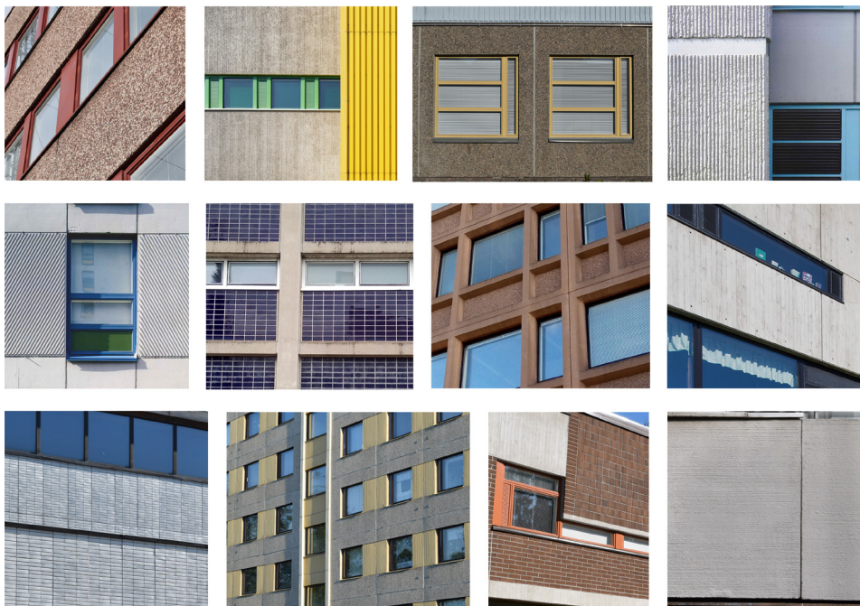
Kuva 57: Betonielementtirakentamisen pintatekstuureja. Toisteinen teollinen elementtitekniikka mahdollisti mainetaan moninaisemman materiaalsen ja muodollisen ilmaisuuden. Samalla tällaiset nyanssit edustavat eri-ikäisiä rakennuksia toisistaan erottavia ajallisia ominaispiirteitä.
