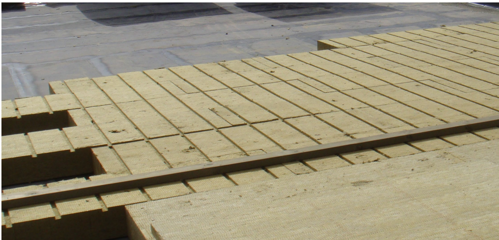
Kuva 1. Tuuletusuritetun mineraalivillakaton rakentaminen käynnissä.
