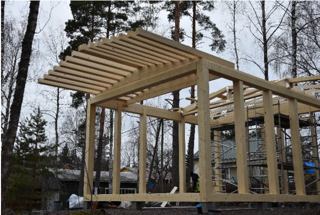
Kuva 3. Talon rungon pystytys kesti yhden työpäivän.
