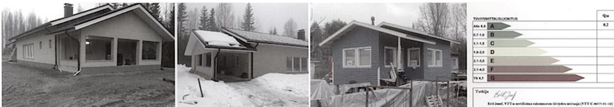
Kuva 5. Esimerkki Palikka-elementeillä toteutetun talon ilmatiiviydsmittauksesta, jossa ilmanvuotoluokaksi q 50 on saatu 0,2 m 3 /(m 2 h). Arvo alittaa selvästi mm passiivitalolta vaaditun arvon 0,6 m 3 /(m 2 h).
