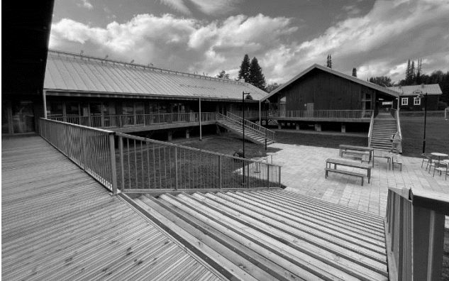
Kuva 2. Yksi Helsingin yliopiston metsätieteellisen kenttäaseman, Hyytiälän, uudisrakennuksen monista tutkimustehtävistä on puurakennuksen, ympäristön ja käyttäjien vuorovaikutuksen tutkimus [5].
