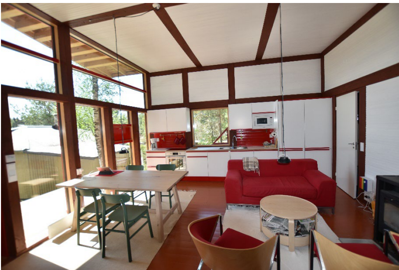
Kuva 4. Ristikkotalolle luonteenomaiset kantavat hirret jätettiin näkyviin vain sisäpuolelle.
