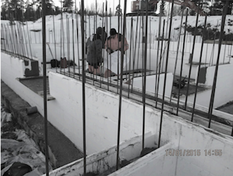
Kuva 11. Palikka-elementti on muotoiltu siten, että teräksien ympärillä on vaadittu suojabetonipaksuus.
