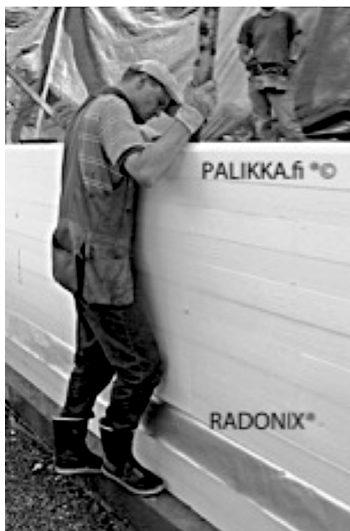
Kuva 2. RADONIX-profiili asennetaan helposti ennen valua.
