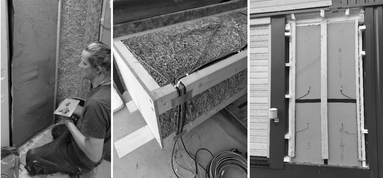
Kuva 1. Olkielementin sisäpinnan savirappausta ja ulkopinnan anturointia.
