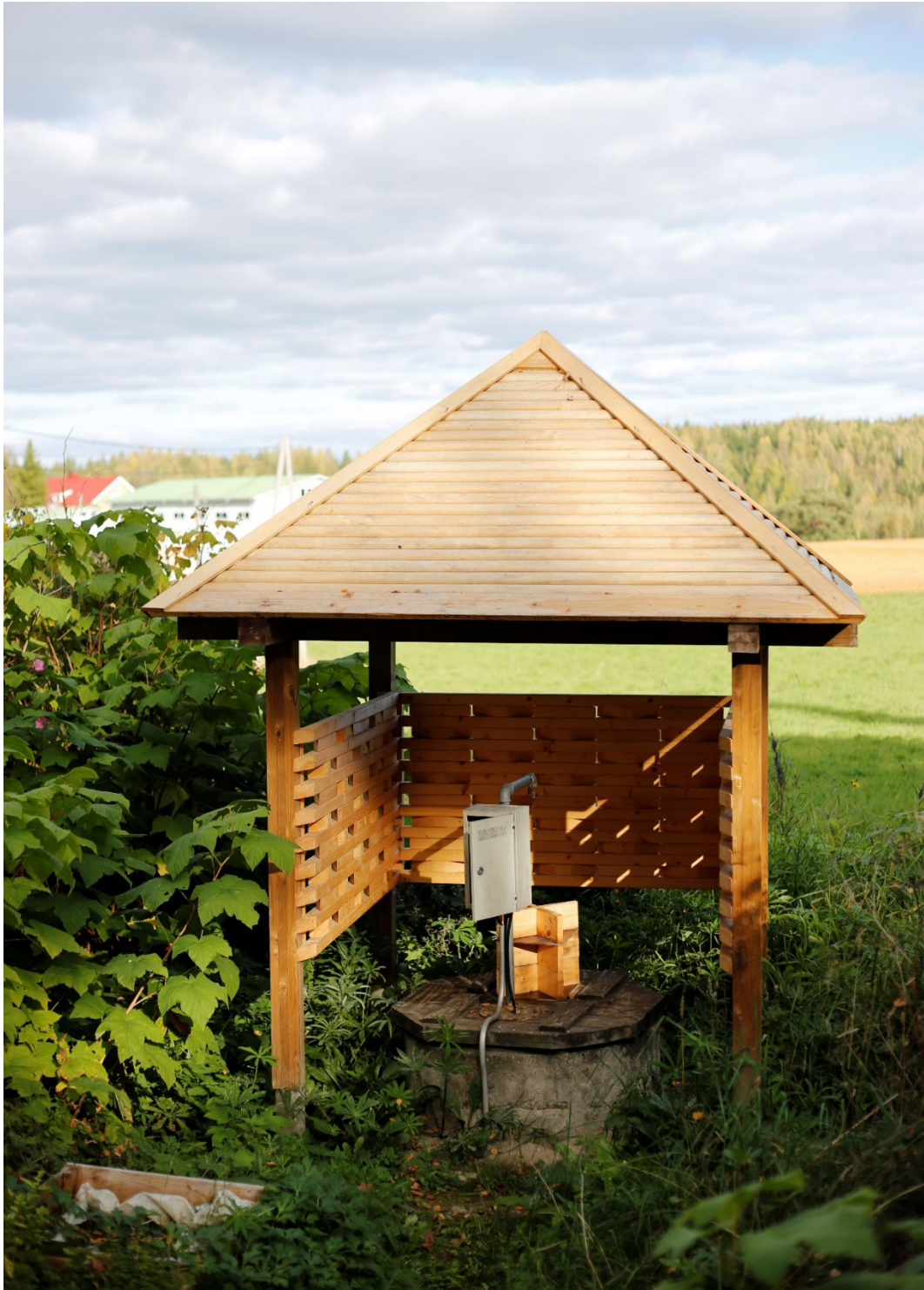
Kuva 37: Kaivon seinämät päästävät valoa lävitseen.
