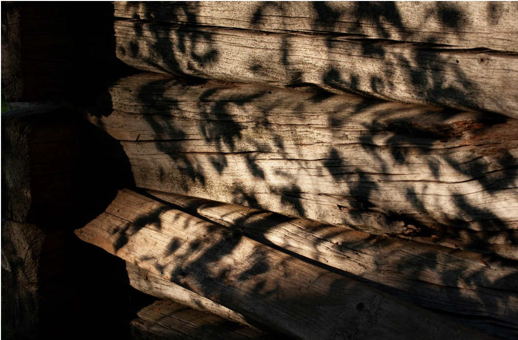
Kuva 26: Ruutikkalan aitan hirsiseinä iltavalossa.
