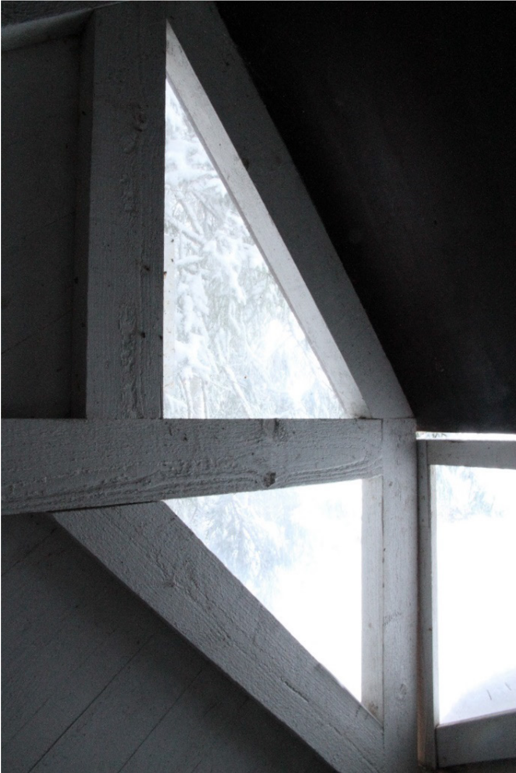
Kuva 44: Maisemäkäymälän ikkunoiden liitoskohta.
