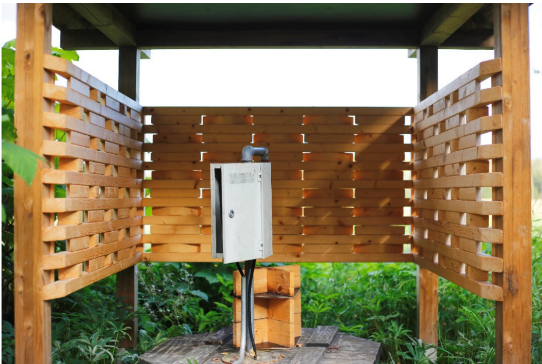
Kuvat 35–36: Seinämien rakenteet muistuttavat korirakennetta. Ylemmästä kuvasta voi nähdä kuinka puu on harmaantunut ajan mittaan.
