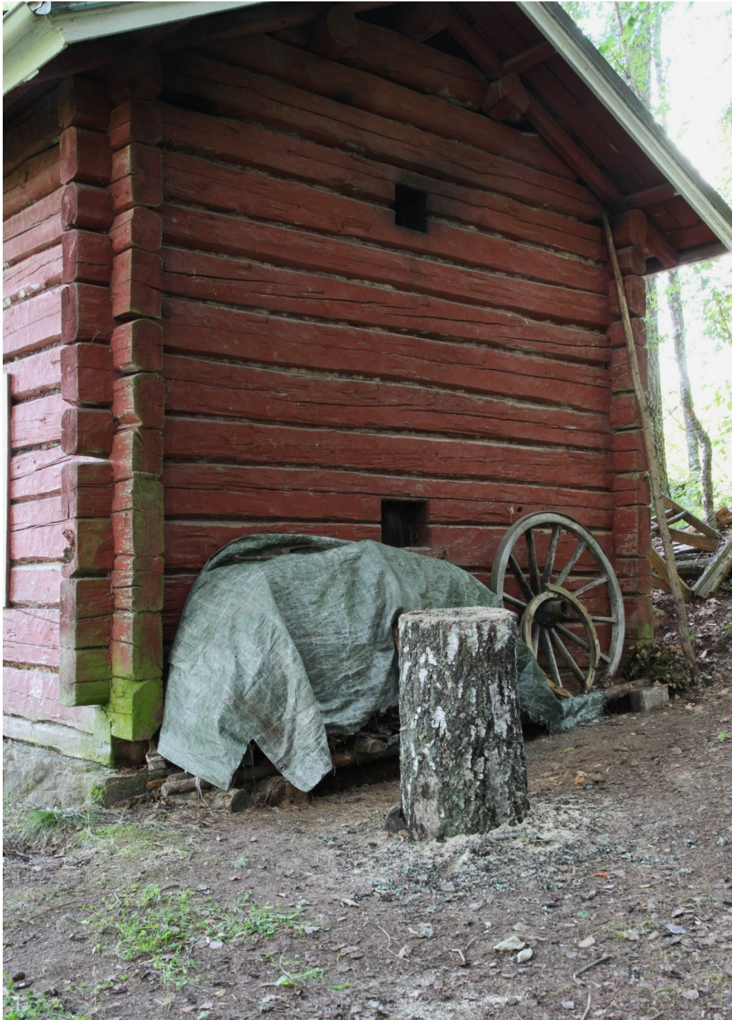
Kuva 21: Savusaunan tuuletusluukut ja polttopuita seinämän vierellä.
