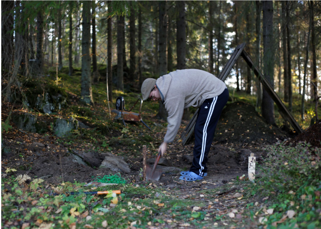
Kuva 38: Minä aloittelemassa maisemakäymälän rakentamista 2016 syksyllä.
