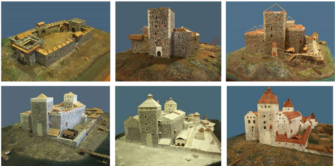
Kuva 6: Pienoismallit Turun linnan rakentumisesta havainnollistavat Ilkka Kronqvistin ja C.J. Gardbergin tulokintojen mukaisia rakennusvaiheita. Pienoismallit on kuvattu Merja Niemisen toimesta Turun linnan rakennushistorian näyttelyssä vuonna 2013. (Nieminen 2023a, 12)
