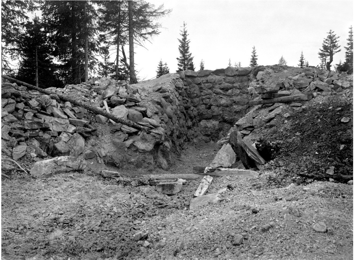
Kuva 3: Mäenrinteeseen kaivettu kalkkiuuni Kainuussa (Frosterus 1904).
