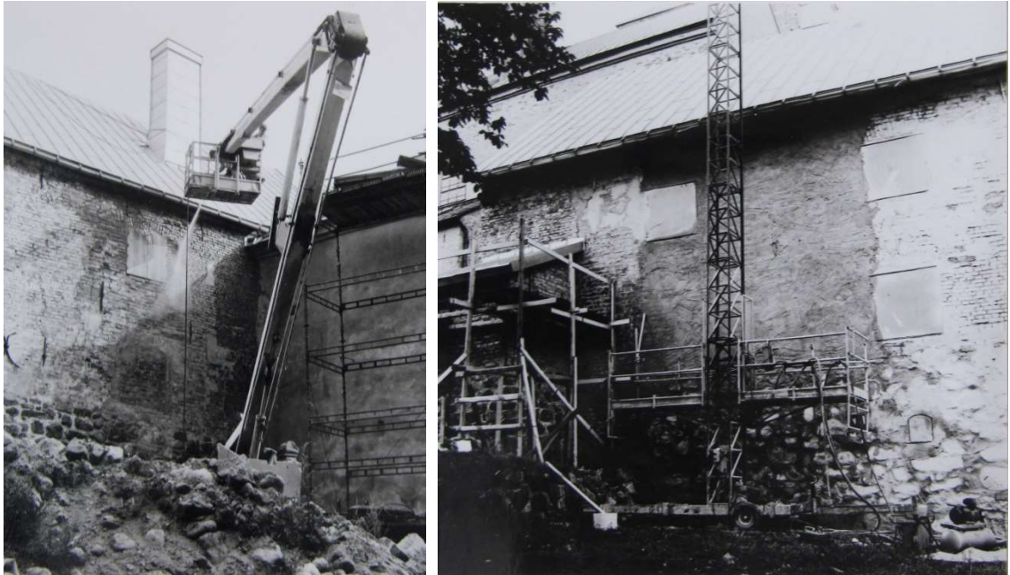
Kuva 13: Vasemmalla eteläsiiven vanha rappaus poistetaan painepesulla (Ilmo Kajala 1982a). Oikealla eteläsiipeen tehdään uutta rappausta (Ilmo Kajala 1982b).
