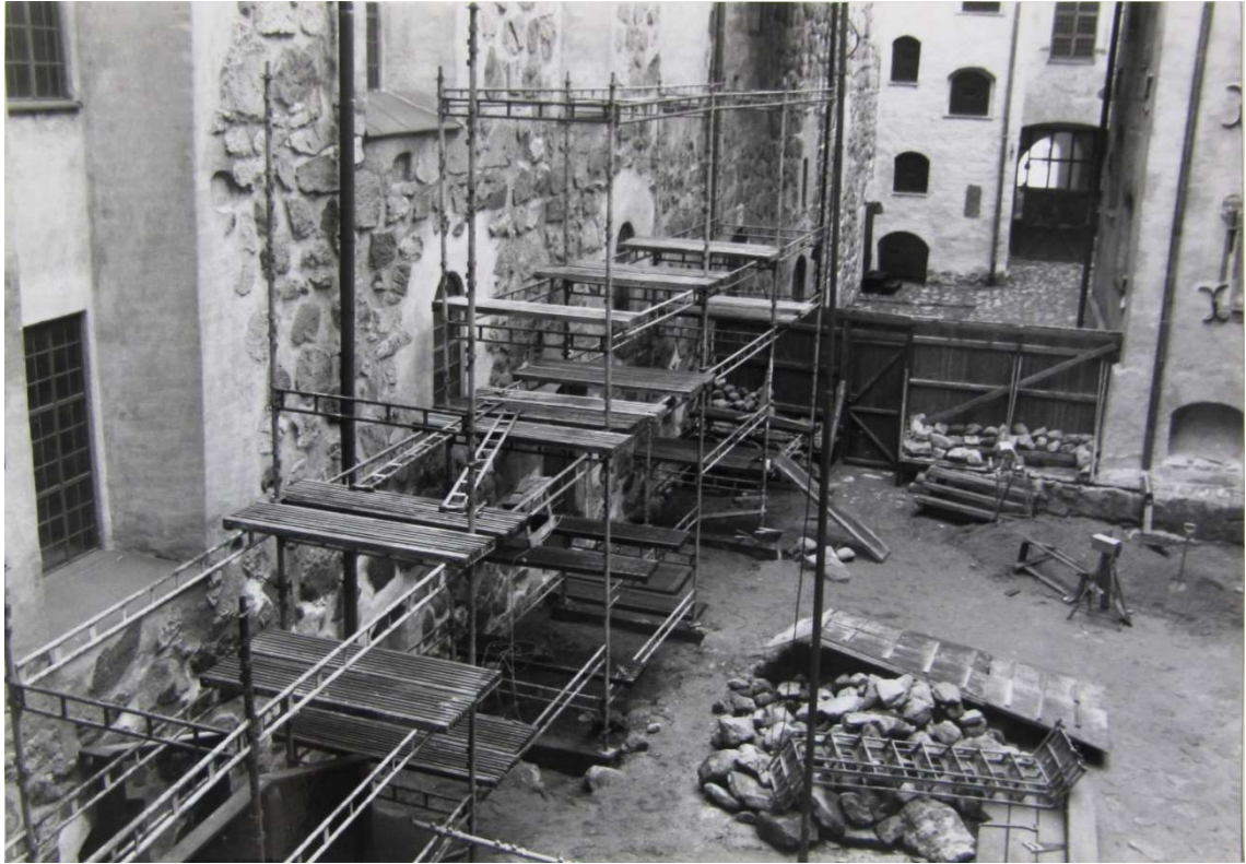
Kuva 15: Päälinnan pohjoissiiven eteläjulkisivun korjaustyöt vuonna 1990 (Ilmo Kajala, 6.8.1990).
