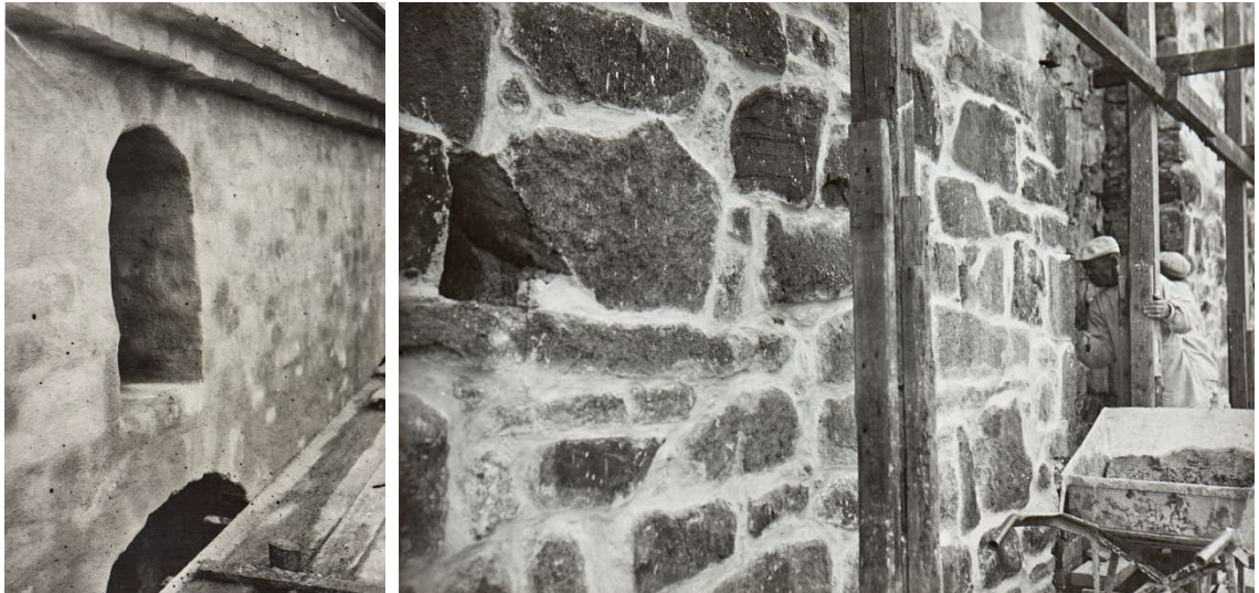
Kuva 8: Vasemmalla tiilipinnan rappaus vuonna 1950 ( Turun linnan länsitornin läntinen julkisivu, ylimmän kerroksen keskimmäisen ikkunan päällä oleva pienempi aukko , tuntematon valokuvaaja 1950). Oikealla luonnonkivimuurin tasasaumaus vuonna 1954 (Per-Olof Welin 1954).
