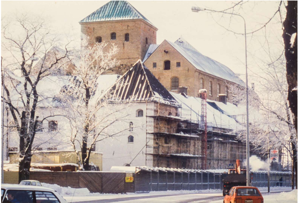
Kuva 14: Esilinna saa uuden rappauksen (Kotkas 1985).
