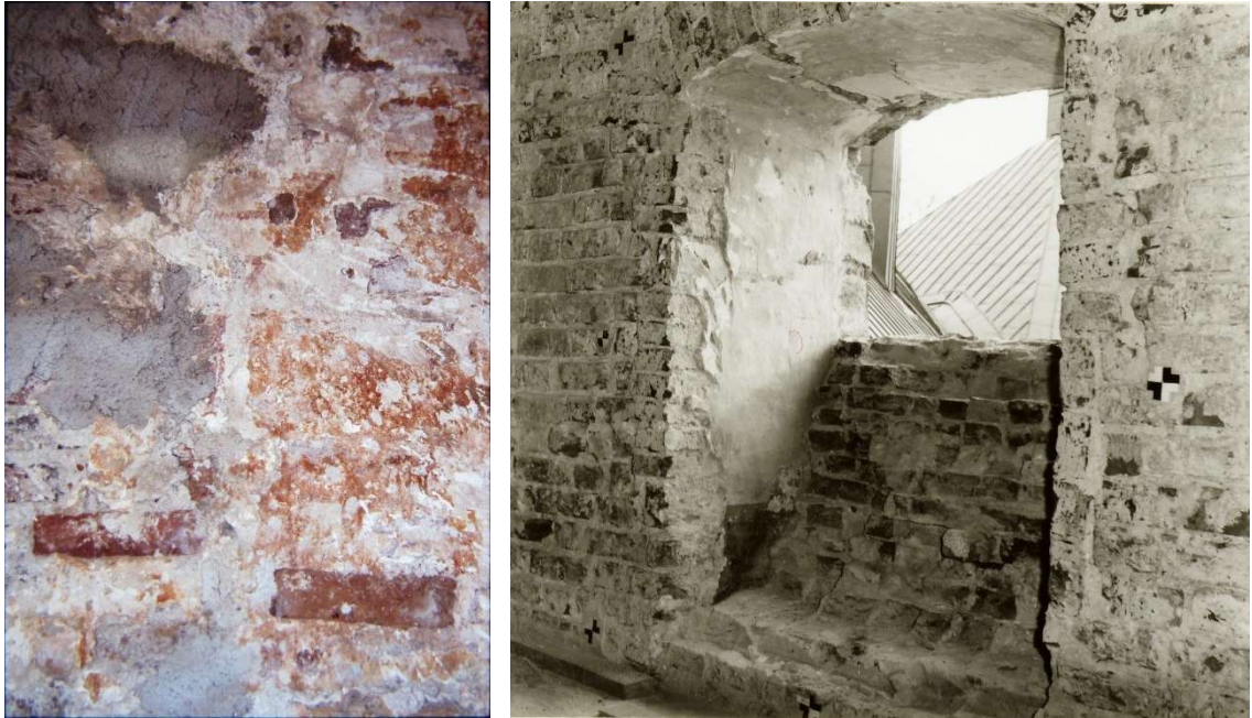
Kuva 11: Vasemmalla esilinnan pohjoissiiven julkisivurappauksessa erottuvat vanhat värit ( Pohjoissiiven eteläjulkisivun rappauskorjauksen värit , tuntematon valokuvaaja 1985). Oikealla eteläsiiven ikkunasyvennys, jossa on vielä jäljellä vanhaa rappauspintaa (Ilmo Kajala 1978).
