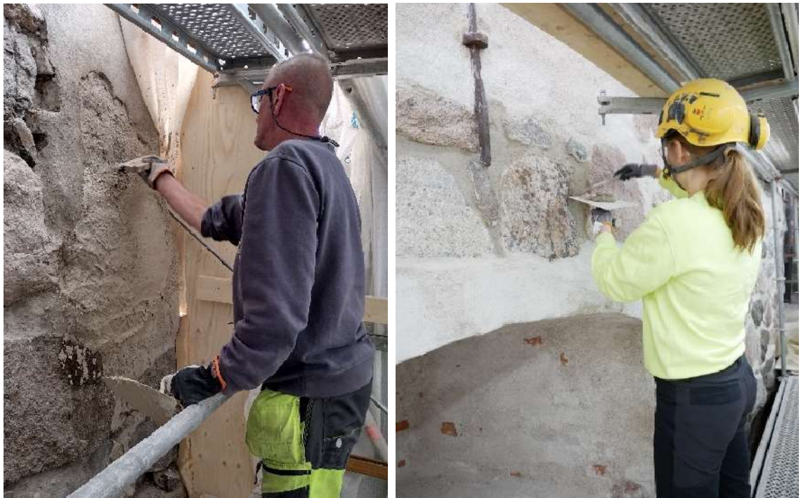
Kuva 20: Vasemmalla Markku Nykänen rappaa tiilipintaa Turun linnalla 4.5.2023. Oikealla kokeilen luonnonkivimuurin saumaamista Erkka Vainio-Ketolan ohjauksessa. (Helena Salo, 12.5.2023)
