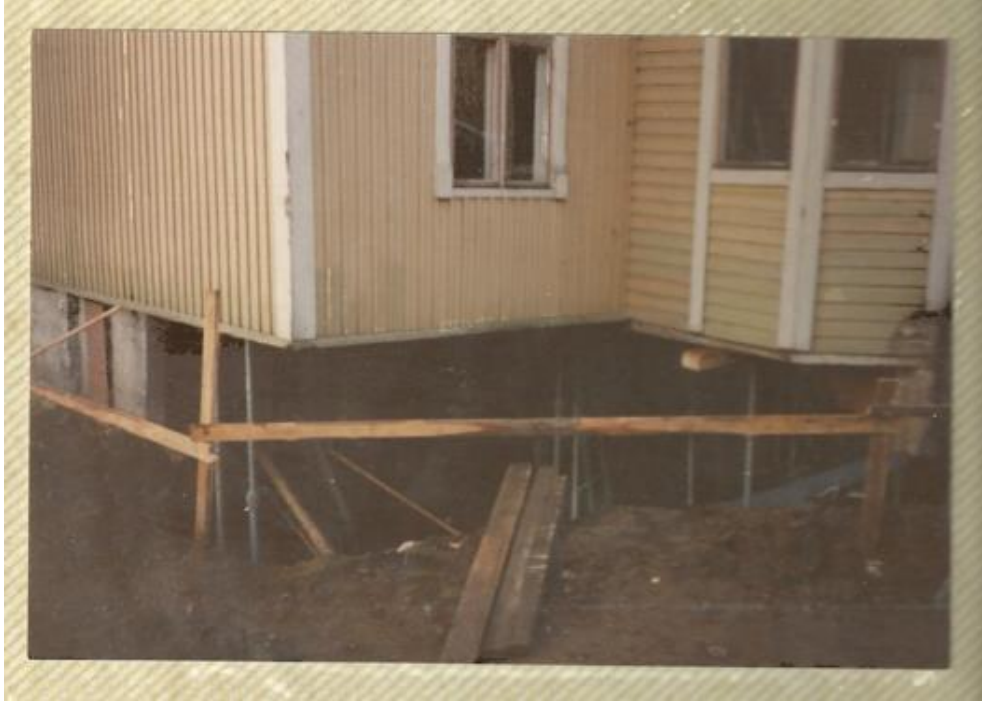
Kuva 5. Sokkelin korjaustyöt ja rakennuksen tukeminen. (Marja Alastalo & Jorma Alastalo, 2023).
