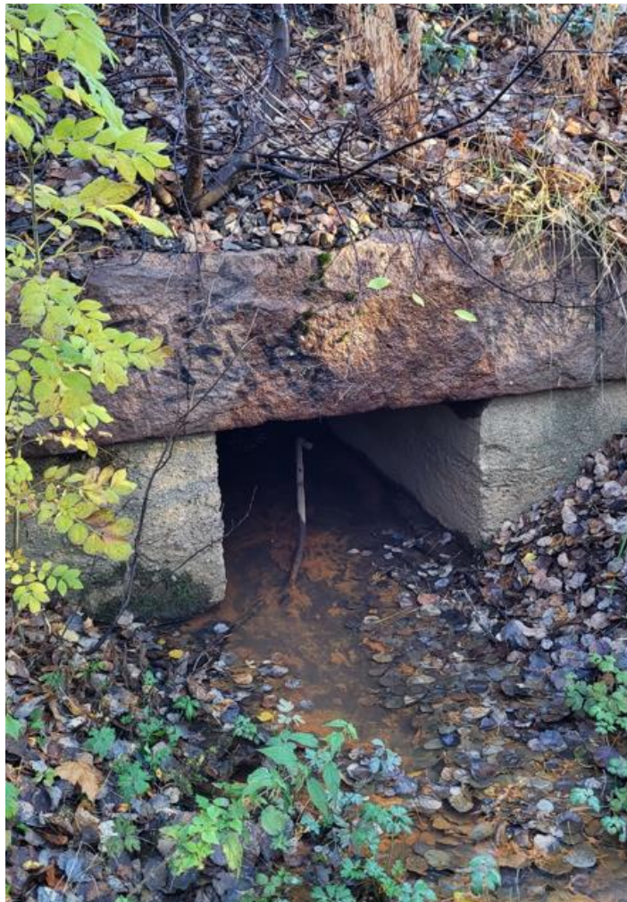
Kuva 48. Heikkilän tavararatapihan alittava kivirumpu. (Sweco 2023)
