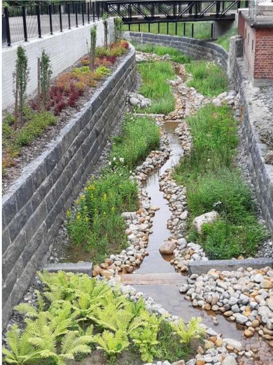
Kuva 5. Kankaan hulevesikanava Jyväskylässä. (Jyväskylän kaupunki)
