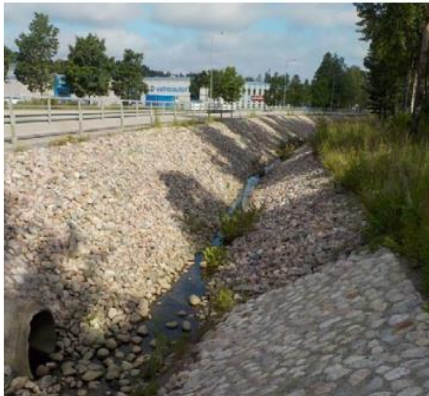
Kuva 4. Rakennettu uoma. (RT RTS_1727 Hulevesirakenteet 2017)
