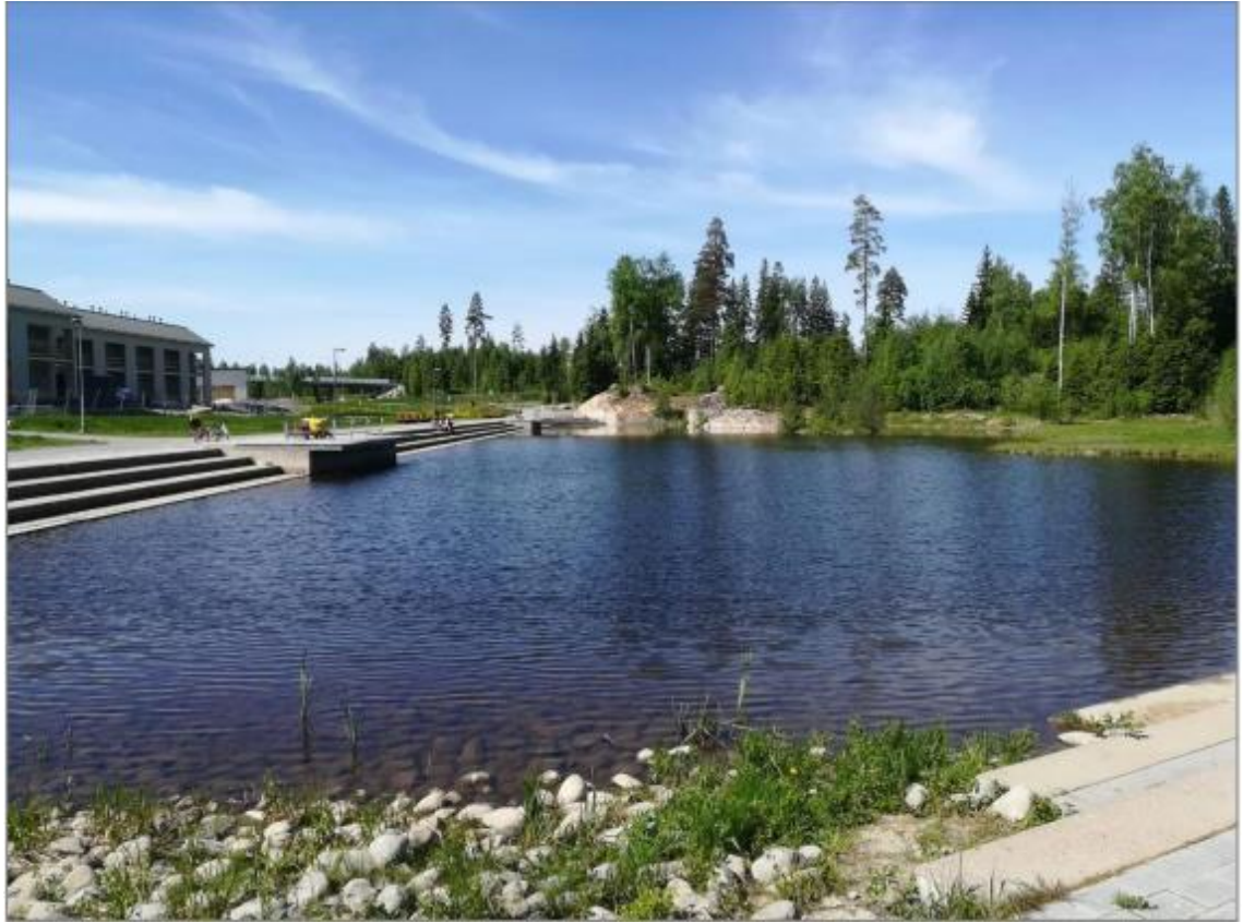
Kuva 6. Hulevesiallas Tampereen Vuoreksessa (Zacheus 2021)
