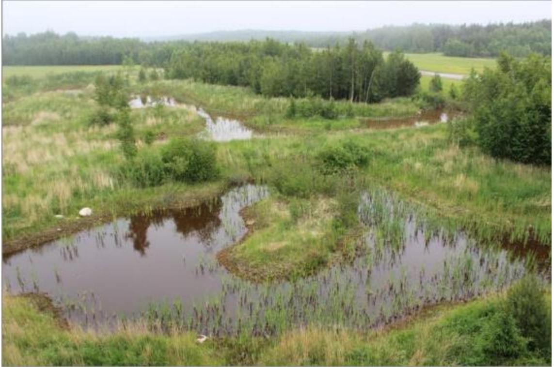
Kuva 8. Merenlahteen johdettavia valumavesiä puhdistava kosteikko Hangossa. (Zacheus 2021)
