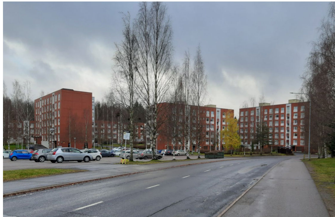
Kuva 21: 1980- ja 1990-luvuilla täydentynyt lamellitaloalue on kaupunkikuvallisesti yhtenäinen kokonaisuus.
