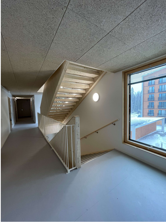
Kuva 11: Lumipuussa portaiden reisipuut, askelmat ja kaiteet jätetty näkyvälle puupinnalle (Kuva: Elina Lahdensivu)
