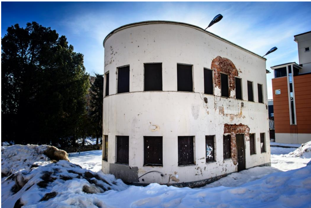
Kuva 1 Vanhan Teboilin huoltoasemarakennuksen vuonna 2023 jäljellä oleva suojeltu osa.
