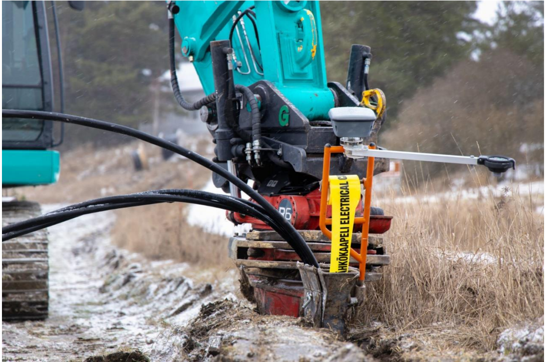
Kuva 7. Maakaapelin aurausta kaivinkoneella. [14]
