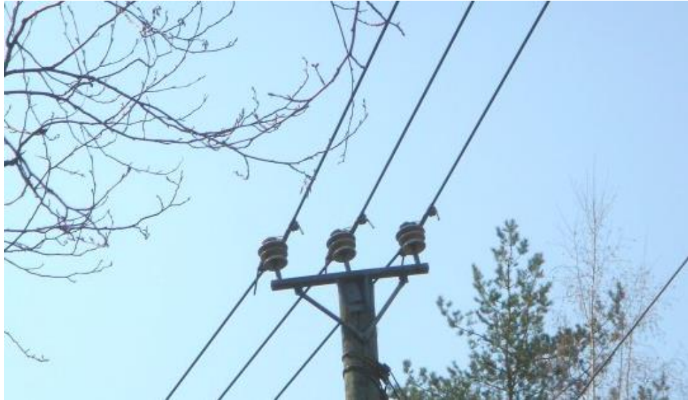
Kuva 3. 20 kV PAS-johtopylväs. [9]
