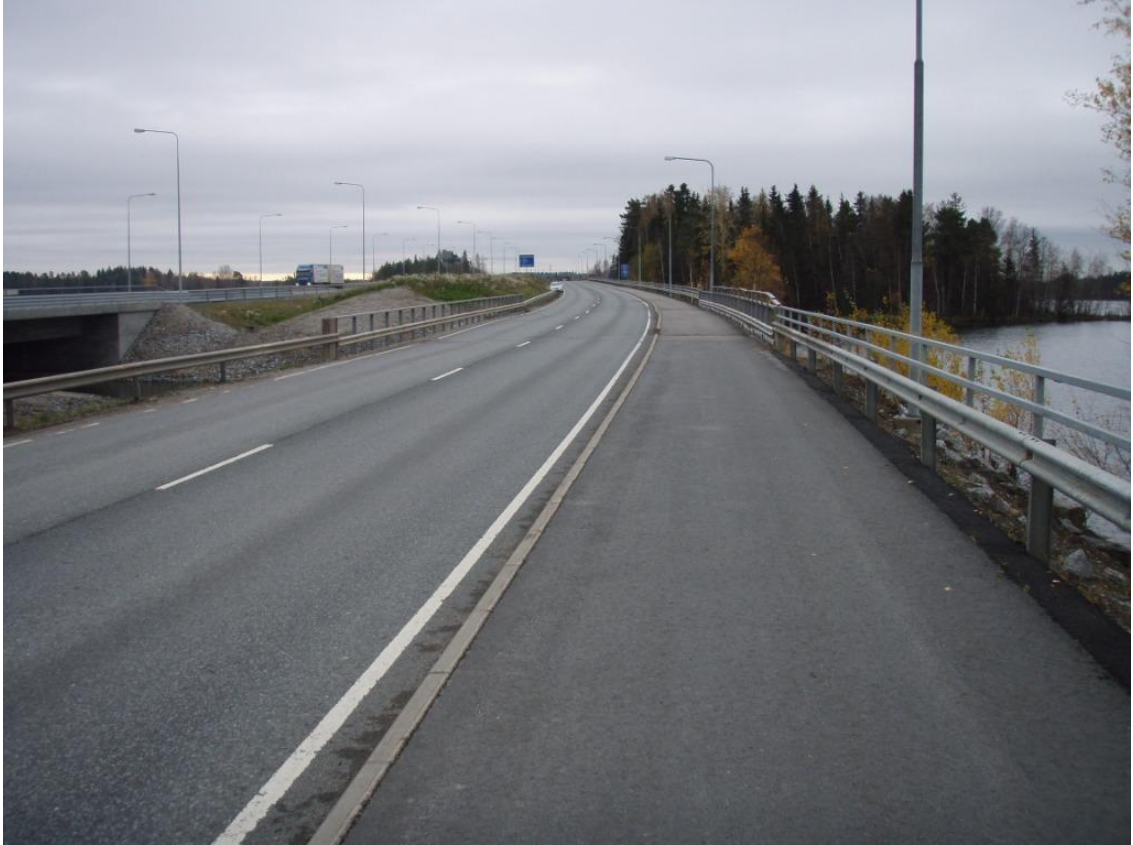
Kuva 16 Sillan kannen ja ajokaistojen kuva (Taitorakennerekisteri, 2023)
