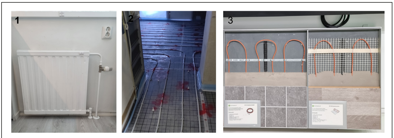
Kuva 10: Vesikiertoinen patterilämmitys (1), vesikiertoinen lattialämmitys (2) sekä kylpyhuoneen sähköisen mukavuuslattialämmityksen termostaatti (3). Kuva: Aki Kortetmäki.
