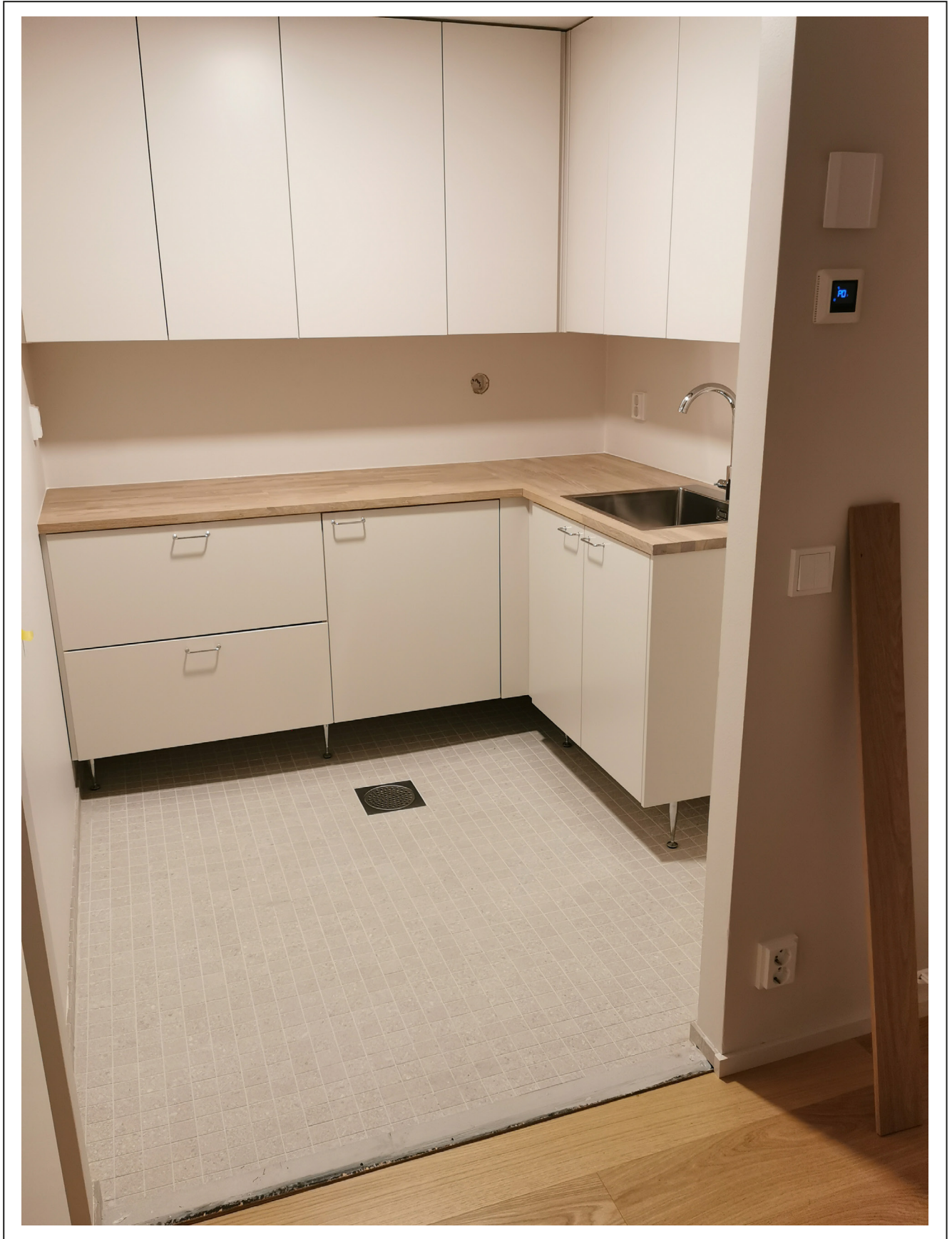
Kuva 39: Kohteessa kaksi asuntoa yhdistettiin jo rakentamisvaiheessa yhdeksi isommaksi asunnoksi. Toisen asunnon kylpyhuone muutettiin kodinhoituhuoneeksi. Alkuperäisten tekniikkavarausten ansiosta alkuperäinen asuntojako voidaan palauttaa tarvittaessa. Kuva: Aki Kortetmäki.
