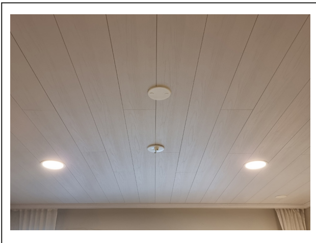
Kuva 19: Mikäli kuvan huonetila suunniteltaisiin väliseinällä jaettavaksi, vaihtoehtoinen tilajako voitaisiin huomioida tuomalla seinän kohdalle tarvittavat johtovaraukset esimerkiksi jakorasialle valmiiksi (kuvassa ylhäällä). Tällöin johdotusta seinälle ei tarvitse rakentaa jälkikäteen esimerkiksi pinta-asenteisia johtokouruja hyväksi käyttäen. Kuva: Aki Kortetmäki.
