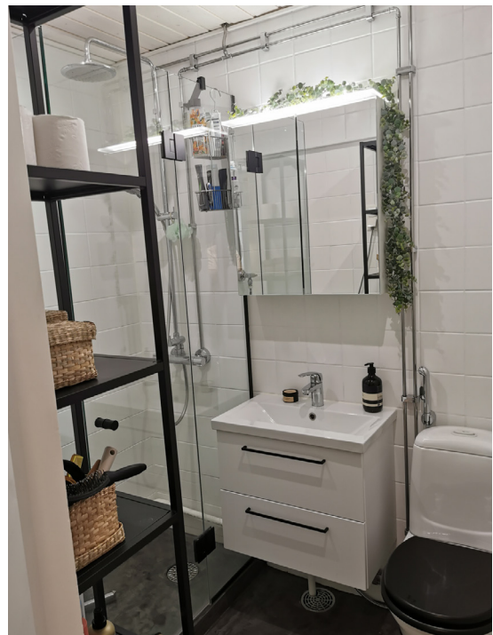
Kuva 16: Tässä kohteessa kylpyhuoneeseen tehtiin pintasaneeraus, vaihdettiin kalusteet ja uusittiin käyttövesiputket. Kuva: Aki Kortetmäki.
