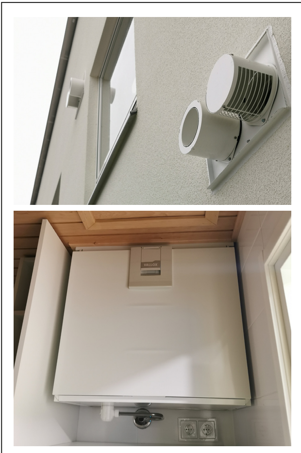
Kuva 34: Asuntokohtainen ilmanvaihtokone ja ulkoseinällä olevat tulo- ja poistoilmakanavan päätelaitteet. Kuva: Aki Kortetmäki.
