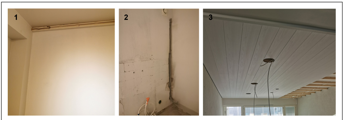
Kuva 4: Uudet johdot asennuskanavassa ja LVIS-saneerauksessa rakennetussa koteloinnissa (1). Sähköasennusputki on upotettu kouruamalla ennen pinnan tasoittamista ja keittiön kalusteiden asentamista (2). Johtoreitit alaslasketun katon sisällä (3). Kuva: Aki Kortetmäki.
