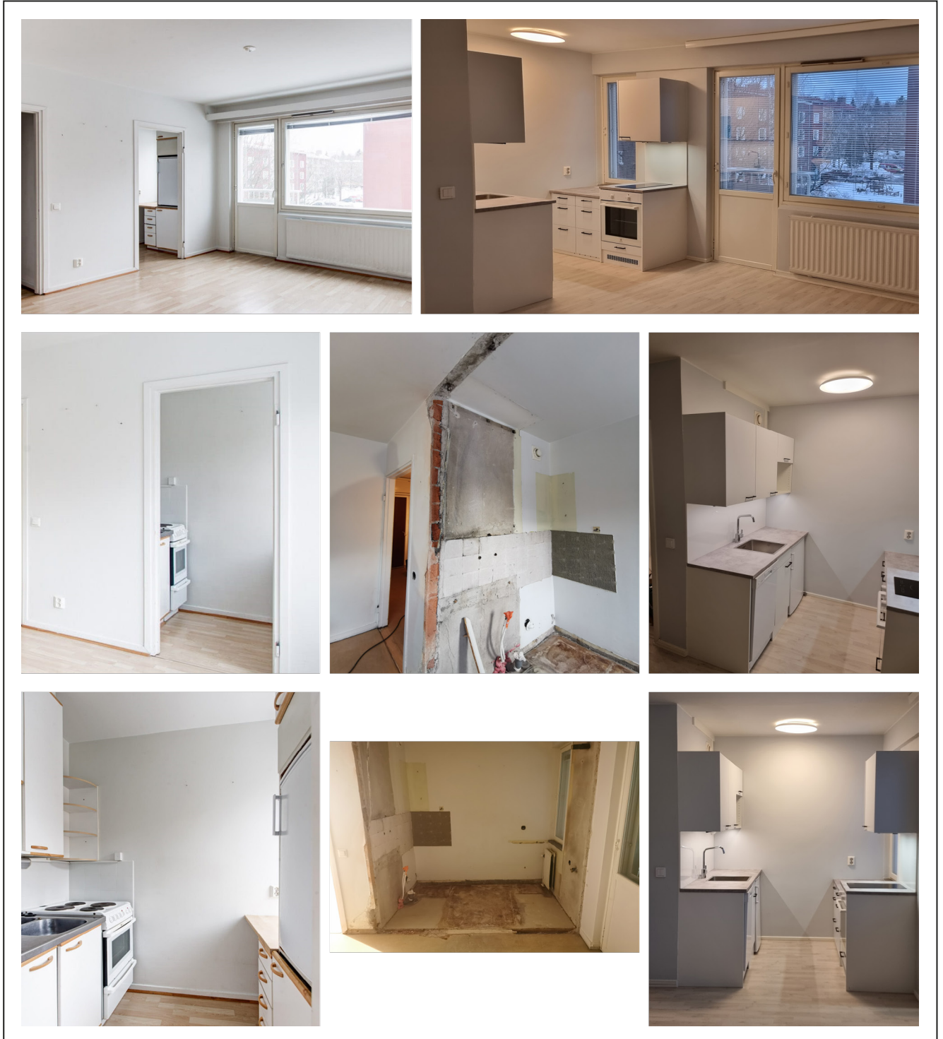
Kuva 15: Keittiösaneeraus ja väliseinän purku. Vasemmalla tilanne ennen purkua, keskellä purkamisen jälkeen ja oikealla valmiina. Kuva: Aki Kortetmäki.
