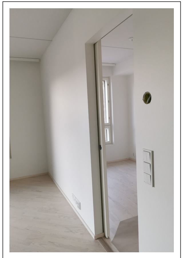
Kuva 22: Tässä asunnossa väliseinä olisi suhteellisen pienellä työllä purettavissa huoneistoremontin yhteydessä. Kuvassa näkyy, että IV-koneen kanavointit kulkevat viereisen tilan vastapäisellä seinällä kylpyhuoneesta ulkoseinälle. Tämä on joustavuuden kannalta hyvä ratkaisu, sillä kanavointien sijoittaminen väliseinän puolelle olisi vaikeuttanut tilan avaamista huomattavasti. Kuva: Aki Kortetmäki.
