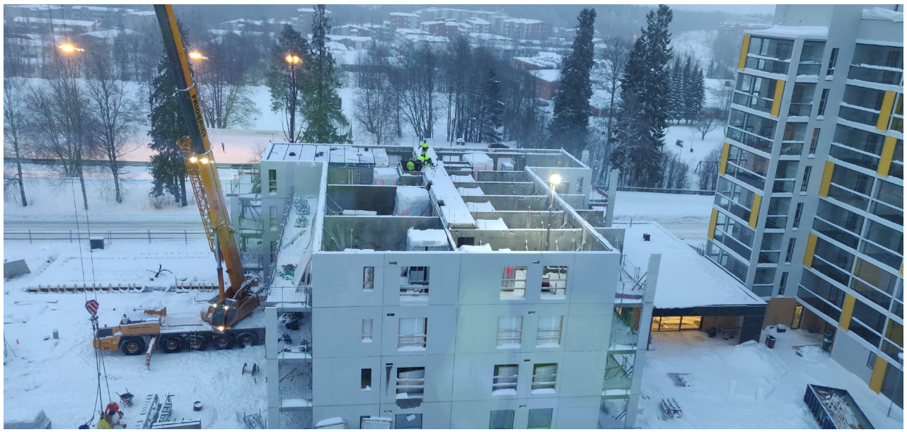
Kuva 29: Ontelolaattojen asentamista työmaalla. Ontelolaattaratkaisussa tekniikkareittien kulkuun laattojen sisällä ei voi vaikuttaa yhtä paljon kuin paikallavalettujen välipohjien yhteydessä. Kuva: Aki Kortetmäki.
