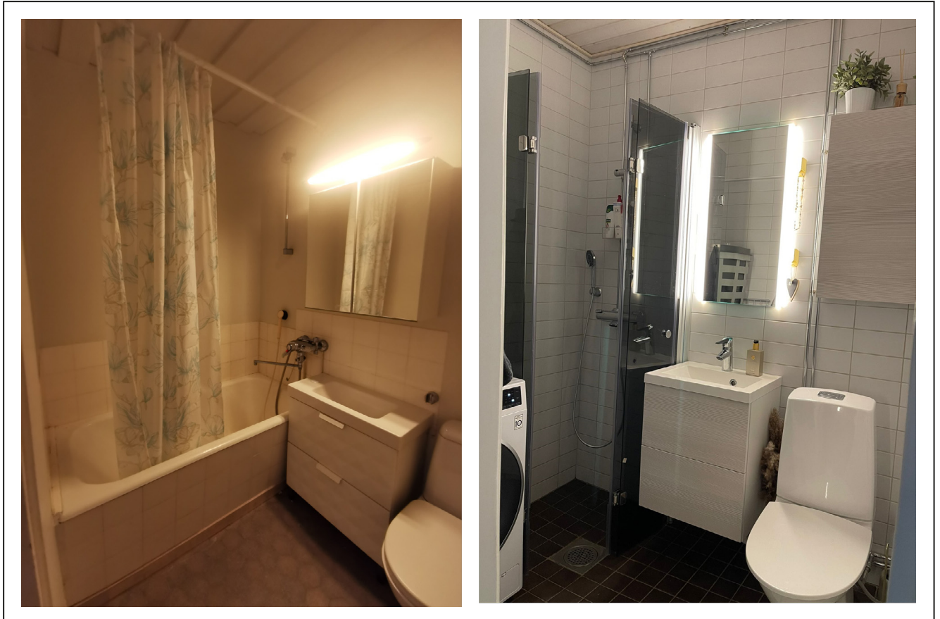
Kuva 17: Tässä kohteessa uusittiin kylpyhuoneen pintarakenteet. Samassa yhteydessä oli mahdollista tehdä muutoksia myös viemärintiin. Kuva: Aki Kortetmäki.
