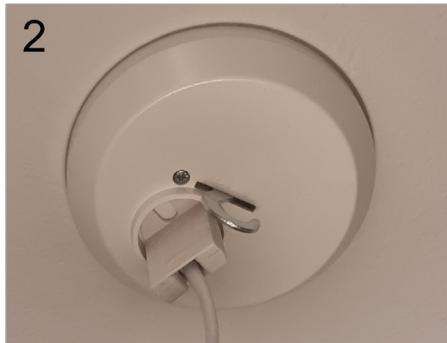
Kuva 5: Suojamaadoittamaton (0-luokan) kaksiosainen pistorasia (1) ja suojamaadoittamaton (0-luokan) valaisinpistorasia (2). Suojamaadoitettu kaksiosainen pistorasia (3) ja suojamaadoitettu valaisinpistorasia (4). Kuva: Aki Kortetmäki.
