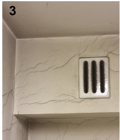
Kuva 9: Kylpyhuoneen ja keittiön KSO-tyyppiset poistoilmaventtiilit koneelliseen ilmanvaihtoon (1 ja 2). Ritilämallinen KGA-poistoilmaventtiili painovoimaiseen ilmanvaihtoon (3). Kuva: Aki Kortetmäki.
