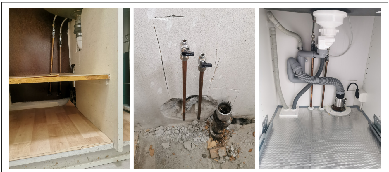
Kuva 14: Käyttövesi- ja viemäri-liitäntä ennen ( vasemmalla ), purettuna ( keskellä ) ja jälkeen ( oikealla ). Kuva: Aki Kortetmäki.
