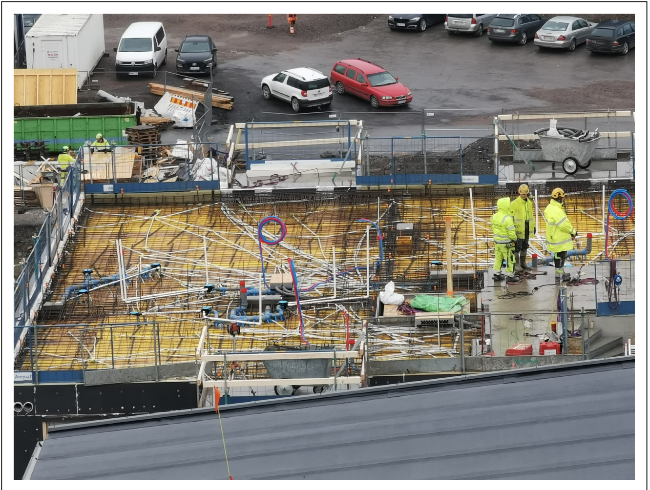
Kuva 28: Välipohjan valutyöt meneillään. Tässä esimerkissä nähdään, miten vapaasti sähkö-, käyttövesi- ja viemärireitit pystytään välipohjaan rakentamaan. Kuva: Aki Kortetmäki.
