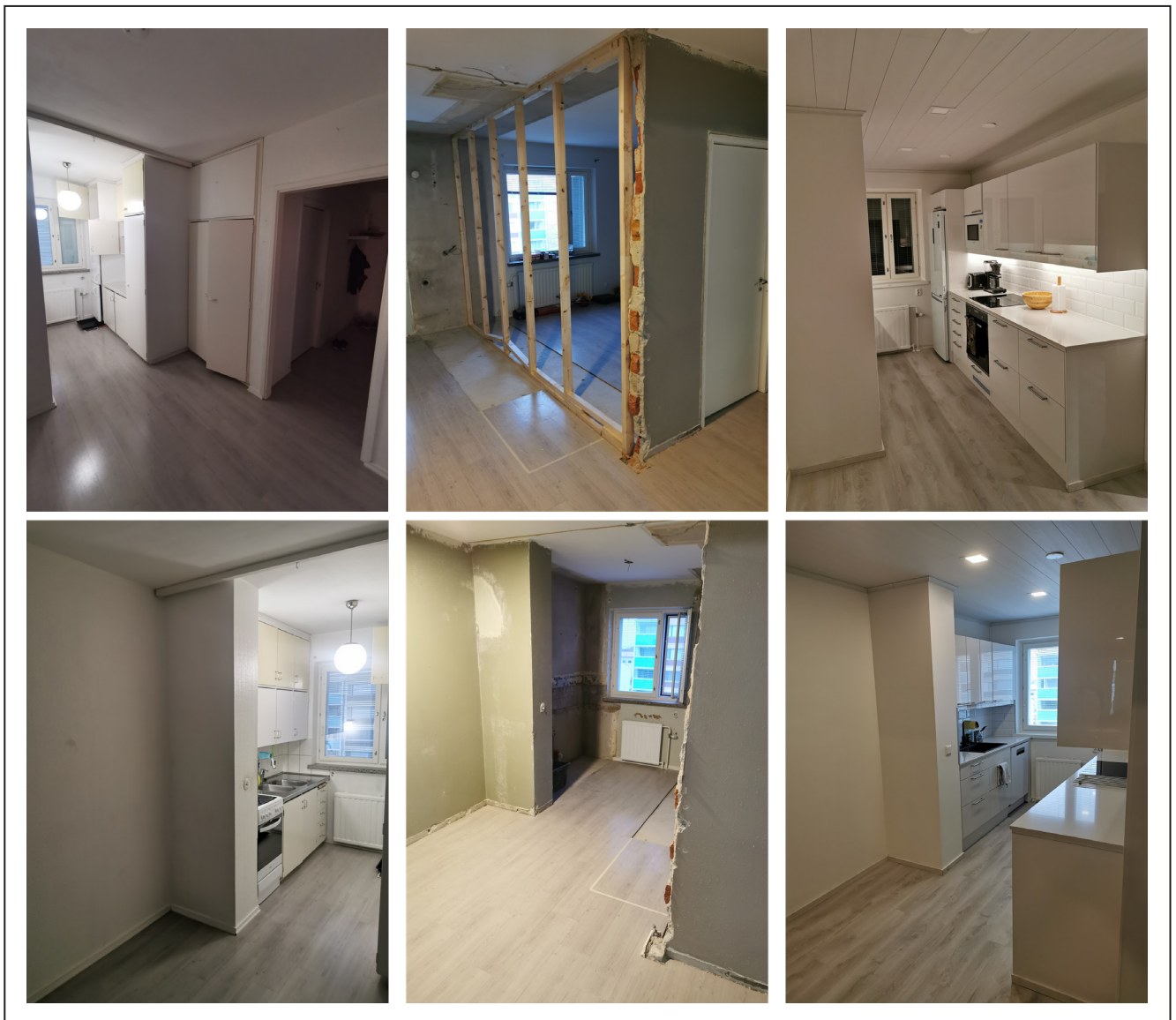
Kuva 13 : Keittiö ennen ( vasemmalla ), purettuna ( keskellä ) ja jälkeen ( oikealla ). Kuva: Aki Kortetmäki.
