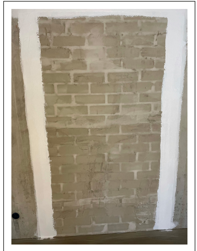
Kuva 27: Bonavan Duo-asunnon muurattu aukkovaraus. Kuva: Bonava.
