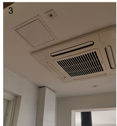
Kuva 11: Olohuoneen paneloitu alakatto (1), kylpyhuoneen alakatto ja huoltoluukku (2) sekä eteisen alakatto ja huoltoluukku jäähdytyskonvektorille (3). Kuva: Aki Kortetmäki.
