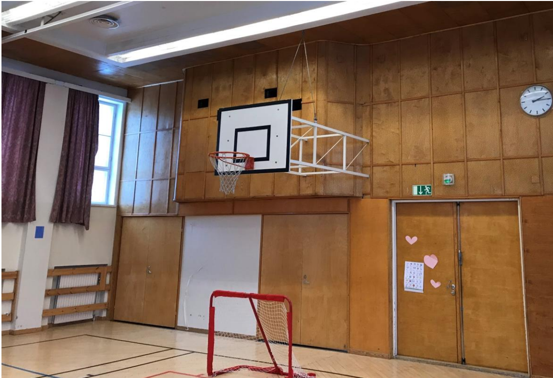
Kuva 8.1. Vuonna 1950 valmistuneen Tampereen Kissanmaan koulun juhla- ja liikuntasalin takaseinällä sekä katon reunoilla on "kaiunpoistolaitteita" eli absorptiomateriaalina toimivia vanerisia reikälevyjä, joiden takana on ilmatila (Suutarla 2018). Kuvälähde: A-Insinöörien arkisto, kuvaaja Tuomas Pelli.
