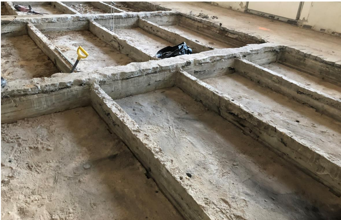
Kuva 13.4. Betoninen alalattapalkkisto, jonka pintarakenteet on purettu ja palkkien välistä on poistettu vanha rakennusaikainen täyte. Kuvälähde: A-Insinöörien kuva-arkisto, kuvaaja Tuukka Lyly.
