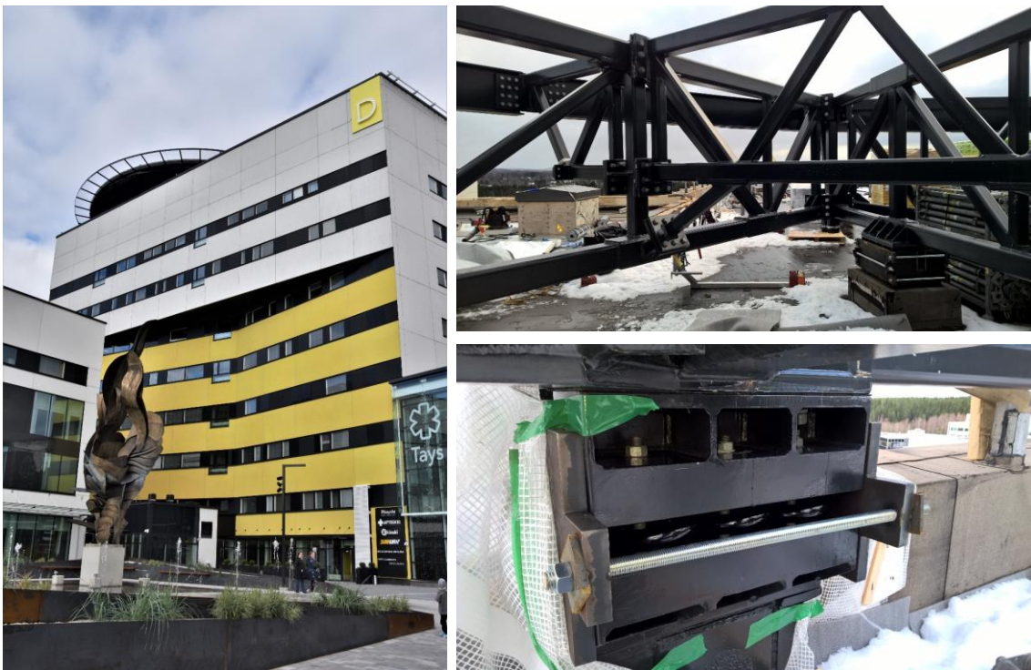
Kuva 10.3. Tampereen yliopistollisen sairaalan D-rakennuksen katolla näkyy helikopterikenttä (vas.), joka on eristetty muusta rakennuksesta värinäeristiminä toimivin jousin (oik.). Kuvalähde: A-Insinöörien kuva-arkisto, kuvaajat Simo Laitakari ja Timo Huhtala.
