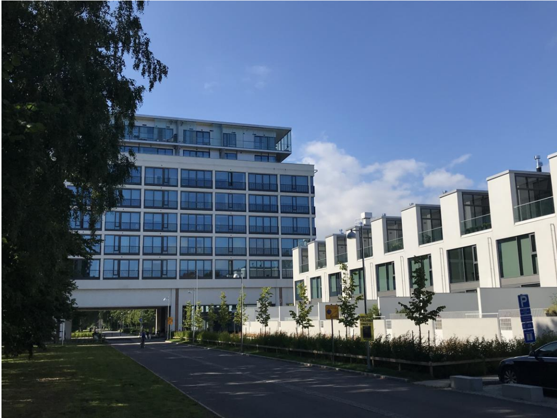
Kuva 13.1. Vuonna 1973 valmistunut toimistorakennus, jonka käyttötarkoitus muuttui asunnoiksi. Rakennusta myös korotettiin kahdella uudella asuinkerroksella. Oikealla on hankkeen yhteydessä uudisrakennuksena toteutettu rivitalo. Kuvälähde: A-Insinöörien kuva-arkisto, kuvaaja Mikko Kylläinen.
