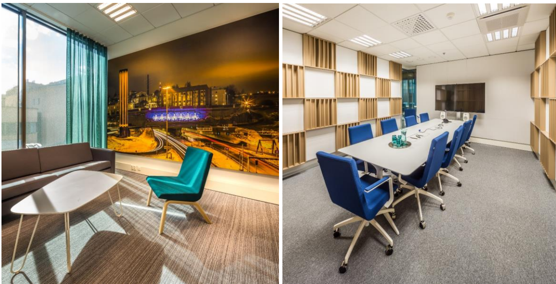
Kuva 9.5. Pienessä neuvottelutilassa (vas.) nähdään seinälle kiinnitetty absorptiopinta. Suuremmassa neuvottelutilassa (oik.) kaikilla pinnoilla on joko absorptiota tai diffuusoreita, jolloin puheenerotettavuus on erittäin hyvä. Kuvälähde: A-Insinöörien kuva-arkisto, kuvaaja Marjo Lalli.
