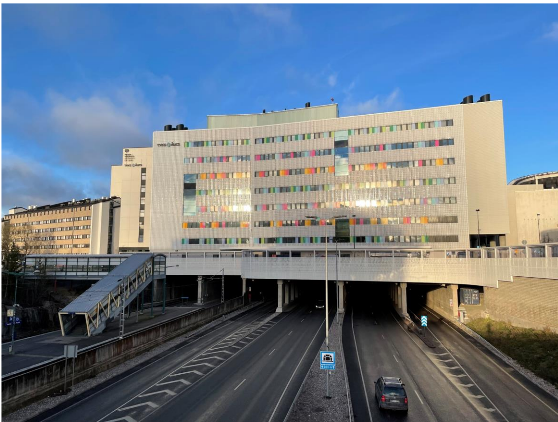
Kuva 10.2. Turun yliopistollisen keskussairaalan Majakkasairaala on rakennettu vilkkaan tien ja rantadan päälle. Rakennuksen tärinän- ja runkomelunvaimennusratkaisu on toteutettu väylien päälle rakennetun kannen laakeroinnin yhteydessä (Mikkilä et al. 2021). Kuvälähde: A-Insinöörien kuva-arkisto, kuvaaja Simo Laitakari.
