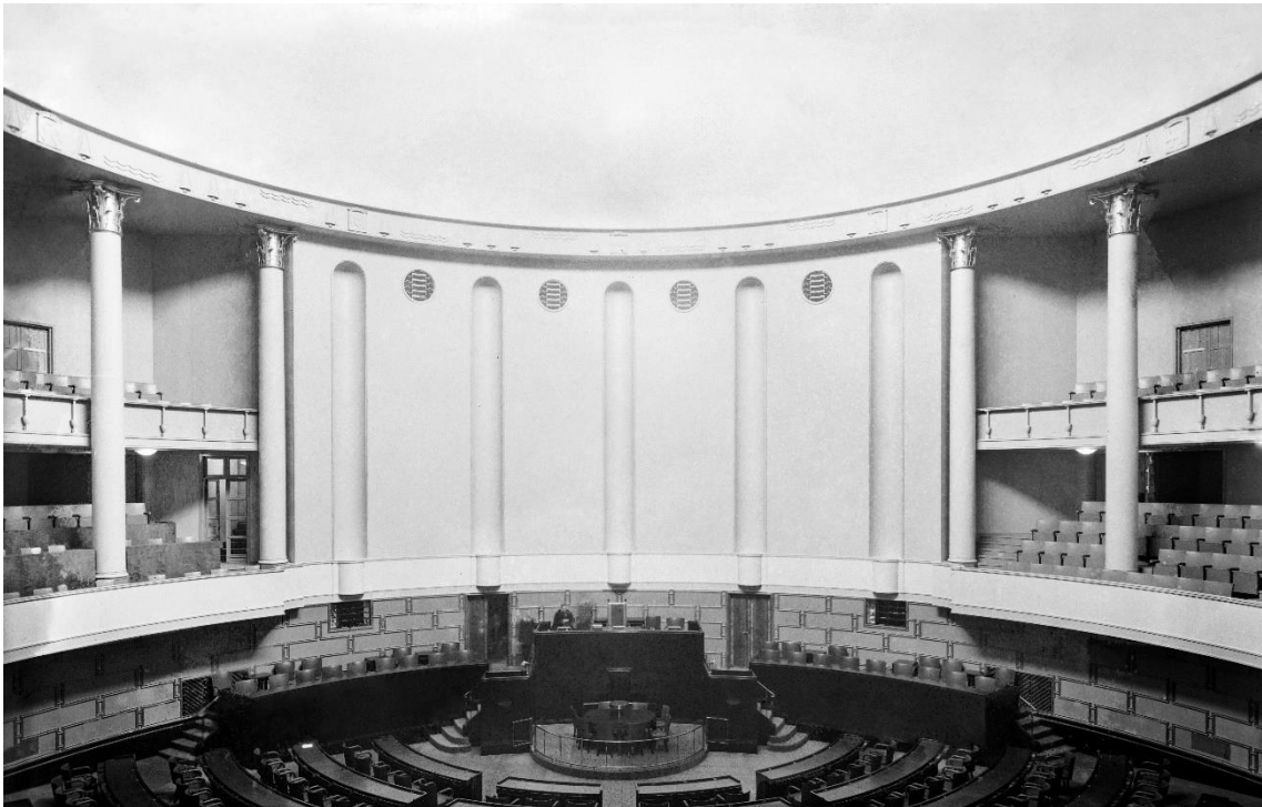
Kuva 1.2. Eduskunnan istuntosalin kupoli on verhoiltu sokeriruo'osta tehdyillä ääntä absorboivilla levyillä. Vuonna 1931 valmistuneen Eduskuntatalon rakenne- ja akustiikkasuunnittelijana toimi diplomi-insinööri Jaakko Packalén (1886–1935), joka selvitti myös rakennuksen välipohjien ääneneristävyden toteuttamista (Kylliäinen 2009b). Kuvälähde: Museovirasto, kuvaaja Hugo Sundström 1931.
