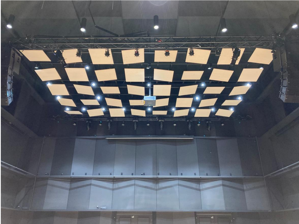
Kuva 11.11. Konserttisalin lava-akustiikan vuoksi ja orkesterin yhteissoiton tukemiseksi lavan päälle tehdään useimmiten heijastinrakenne, joka lisää nopeita heijastuksia lavan alueella. Kuvalähde: A-Insinöörien kuva-arkisto, kuvaaja Mikko Kylliäinen.
