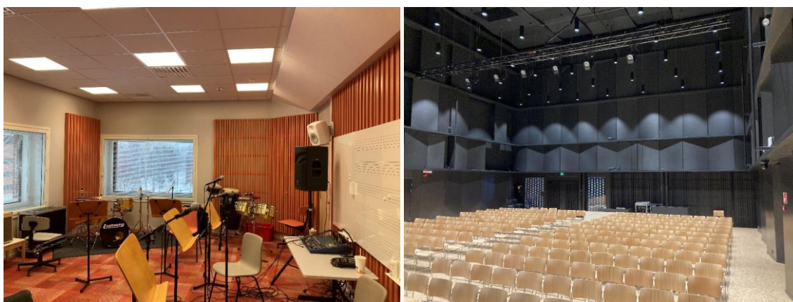
Kuva 8.6. Bänditila (vas.) edellyttää lyhyttä jälkikaiunta-aikaa ja absorptiota bassotaajuuksilla. Musiikkioppilaitoksen konserttisalin tulee olla kaiuntainen, mikä edellyttää riittävän suurta tilavuutta (oik.). Esimerkit ovat Joensuun konservatorion 2021 valmistuneesta uudisrakennuksesta. Kuvallähde: A-Insinöörien kuva-arkisto, kuvaaja Mikko Kylliäinen.
