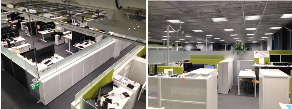
Kuva 9.1. Esimerkki hyvin suunnitellusta avotoimistosta. Tilan koko katon alalla on ääntä tehokkaasti absorboivaa materiaalia. Lisäksi absorptiota on jonkin verran kalusteissa ja lattian tekstiilimatto absorboi jonkin verran suurimpia taajuuksia. Työpisteiden ja ryhmien välillä on riittävästi tilanjakajina toimivia seinäkkeitä ja kalusteita. Tilassa on myös peittoäänijärjestelmä koko työpisteiden alalla. Kuvälähde: A-Insinöörien kuva-arkisto, kuvaaja Mikko Kylliäinen.
