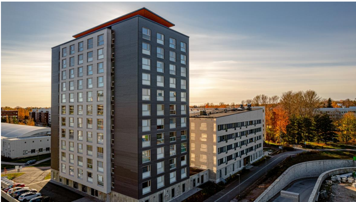
Kuva 12.8. Esimerkki korkeasta tilaelementtirakenteisesta kerrostalosta: Espoossa sijaitseva HOAS Tuuliniitty, joka 13-kerroksisena on maailman korkein tilaelementtitekniikalla toteutettu puukerrostalo. Kuvalähde: A-Insinöörien kuva-arkisto.
