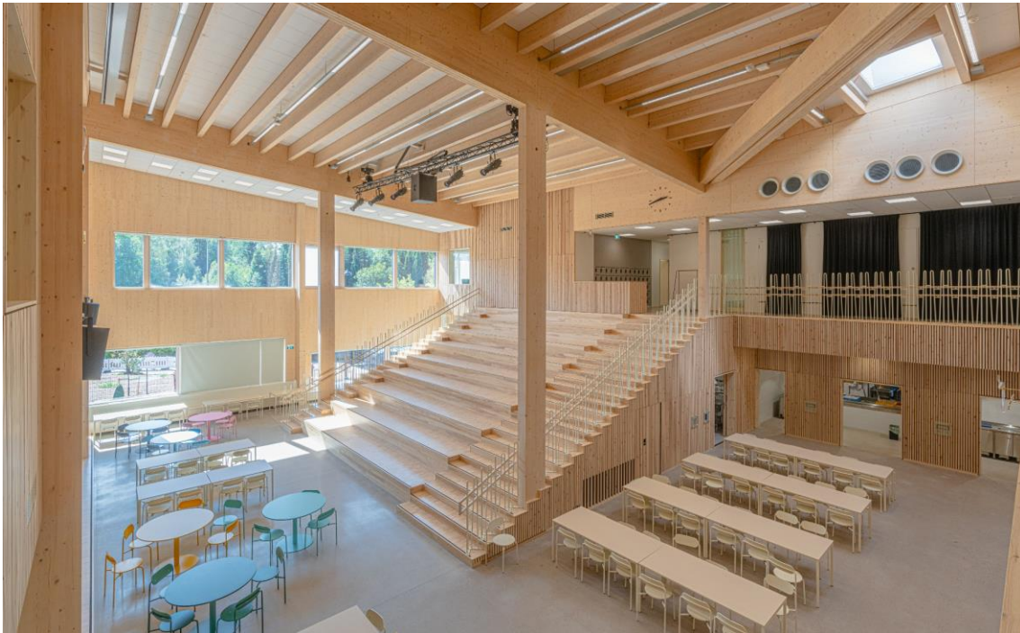
Kuva 12.7. Pilari–palkkirunko puurakenteisessa koulussa (Suomalais-venäläinen koulu Helsingissä). Kuvalähde: A-Insinöörien kuva-arkisto.
