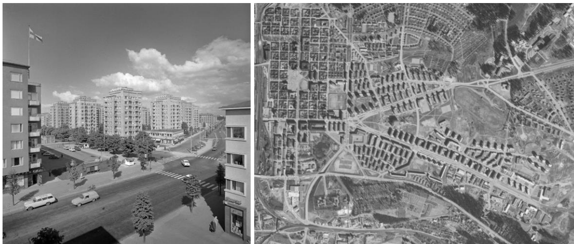
Kuva 6.6. Kalevan kaupunginosaa Tampereella vuonna 1962 (vas.). Yhdeksänkerroksisten pistetalojen, Kalevantornien, rakentaminen oli alkanut vuonna 1949. Teiskontiellä, kaupungin keskeisellä sisääntuloväylällä, autoja kulkee harvaksen. Puolikunnallisten talojen katolta kuvattu näkymä olisi vuonna 2023 jokseenkin samanlainen, mutta autoja olisi jonoiksi asti. Lisäksi kuvaan olisivat ilmestyneet raitiotien kiskot ja johtimet. Ilmakuvassa vuodelta 1966 (oik.) nähdään, kuinka Kalevan kaupunginosa rakentuu Teiskontien ja Sammonkadun varsille lamellitaloista, joiden välistä melu pääsee esteettä leviämään. Kuvälähteet: Museoviraston kuvakokoelma, kuvaaja Matti Poutvaara (vas.), Tampereen kaupunki (oik.).
