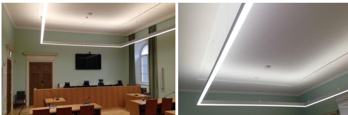
Kuva 13.5. Suojellun puhutilan huoneakustiikkaratkaisu perustuu paksuihin verhoihin sekä katon reunoilla kiertävään ruiskutettuun pintaan. Kuvälähde: A-Insinöörien kuva-arkisto, kuvaaja Mikko Kylliäinen.
