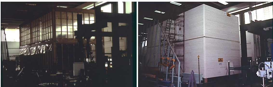
Kuva 12.1. Tampereen teknillinen korkeakoulu tutki puukerrostalon ilma- ja askelääneneristysratkaisuja vuonna 1995 mittauksin laboratoriahalliin pystytetyssä kaksikerroksisessa koerakennuksessa (Keronen & Kylliäinen 1997). Vasemmalla nähdään keskeneräisen koerakennuksen runko ja oikealla koerakennus valmiina ulkovalloksineen. Tutkimustuloksia käytettiin Ylöjärven asuntomessuille 1996 valmistuneiden Suomen ensimmäisten nykyaikaisten puukerrostalojen rakentamisessa. Kuvalähde: Tampereen yliopisto, rakennustekniikan yksikön kuva-arkisto, kuvaaja Mikko Kylliäinen.
