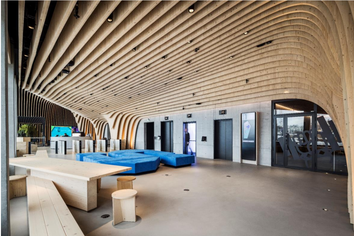
Kuva 12.15. Toimistorakennuksen vastaanottoaulaan on saatu aikaan rauhalliset ja miellyttävät ääniolosuhteet yhdistämällä voimakkaasti muotoiltu puu tehokkaaseen absorptiomateriaaliin, joka on sijoitettu pystysuuntaisten puulevyjen väliin. Kuvälähde: A-Insinöörien kuva-arkisto.
