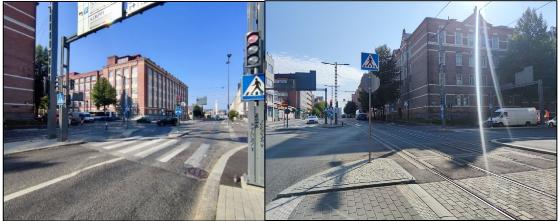
Kuva 37. Itsenäisyydenkadulla Yliopistonkadun – Tammelan puistokadun liittymässä on ollut useita törmäyksen vaaratilanteita. Radan suuntaiselta ajoradalta on käännytty vasemmalle raitiovaunun eteen.
