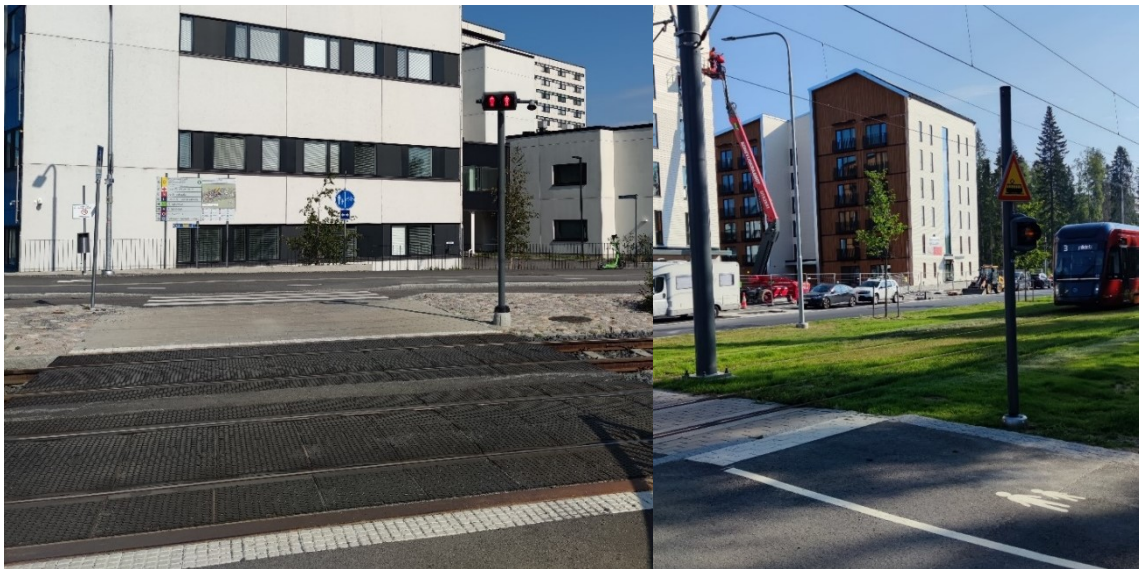
Kuva 3. VAROVA-valot ylityspaikalla Lääkärintiellä. Lähestyvistä raitiovaunusta varoittava vilkkuva keltainen valo lähestyvästä ylityspaikalla Makkarajärvenkadulla.
