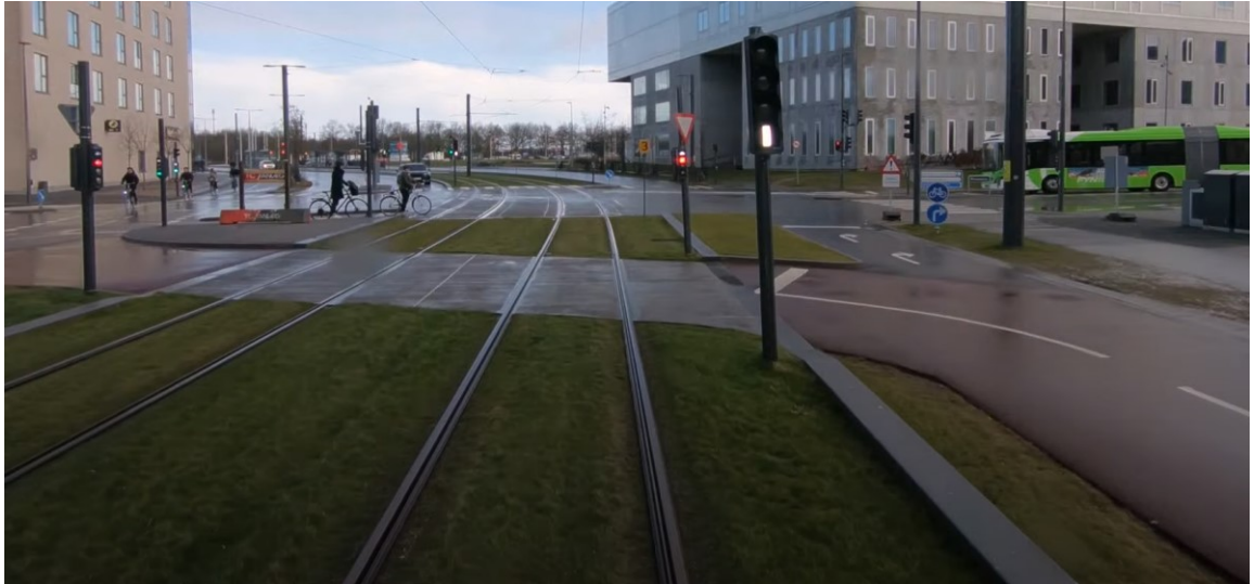
Kuva 26. Pyöräilijälle on merkitty väistämisvelvollisuus liikennevalo-ohjatussa ylityksessä. Punainen asfaltti ei jatku raitiotien yli. (Odense Letbane, 2022a)
