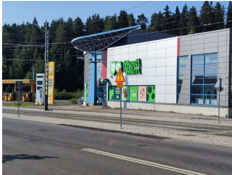
Kuva 39. Rieväkadulta on poistettu tonttiliittymä.
