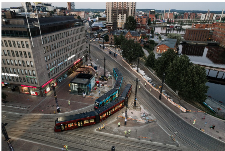
Kuva 38. Hatanpään valtatie ja Hämeenkadun liittymässä ajoneuvojen väistämisvelvollisuuden noudattaminen on aiheuttanut vaaratilanteita (Tampereen Raitiotie Oy 2021d)
