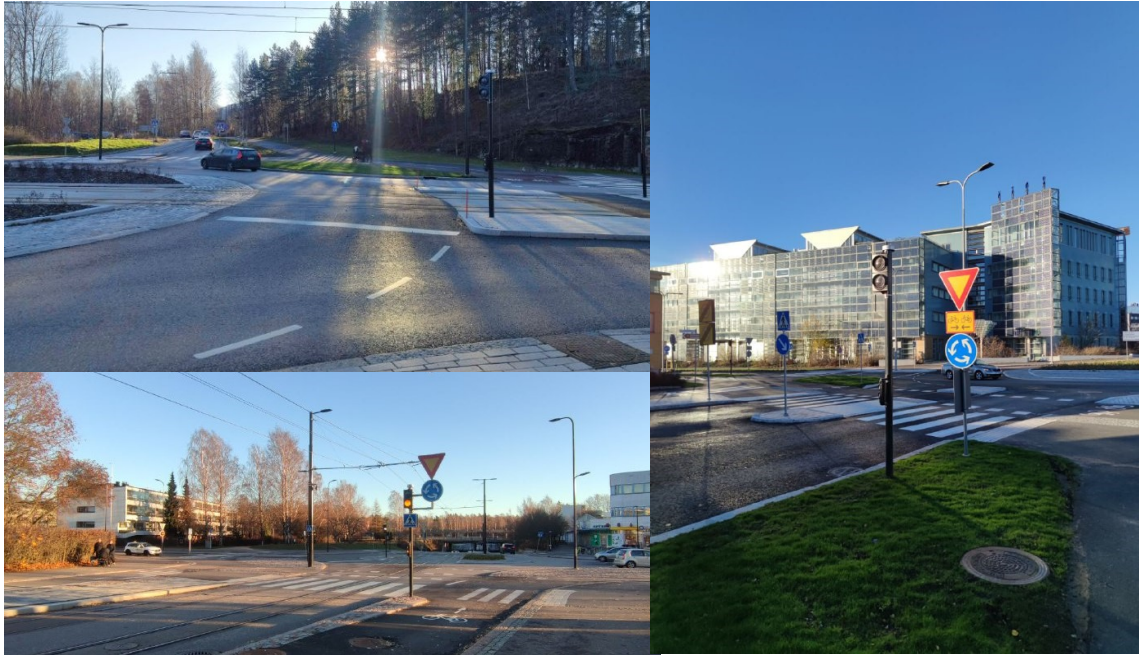
Kuva 35. Vasemmalla ylhäällä Viikintien ja Viilarintien kiertoliittymä, jossa ajoneuvot pysäytetään ennen radan ylitystä. Vasemmalla alhaalla Oulunkylän kiertoliittymä, jossa osa suunnista pysäytetään ennen kiertotilaa ja osa ennen radan ylitystä. Oikealla Viikinkaaren ja Viikintien kiertoliittymä, jossa ajoneuvot pysäytetään ennen kiertotilaa.
