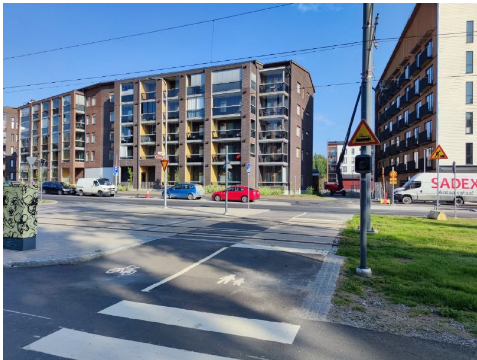
Kuva 43. Makkarajärvenkadulla ylityspaikalla on raitiovaunusta varoittava merkki A25 Raitiovaunu sekä eroteltu kulkumuodot.
