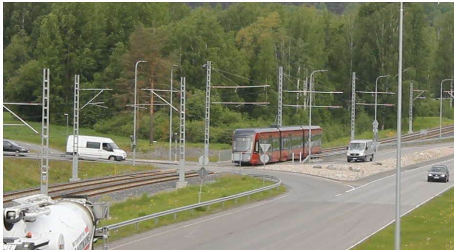
Kuva 40. Tasoristeyksessä ajoneuvot pysäytetään raitiovaunuvaloilla.
