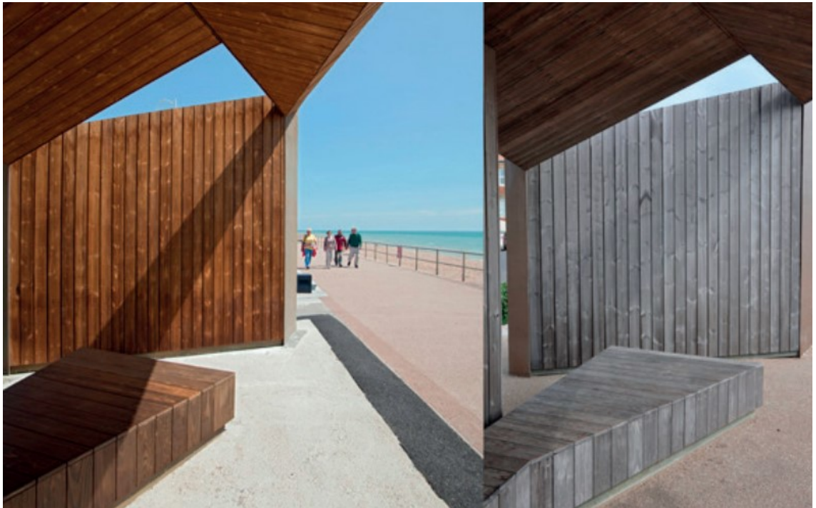
Kuva 9. Kebony-puu patinoituu ajan kuluessa, jos pintakäsittelyä ei tehdä. Vasemmalla on uusi puu ja oikealla patinoitunut puu. (Novenberg Oy 2017)
