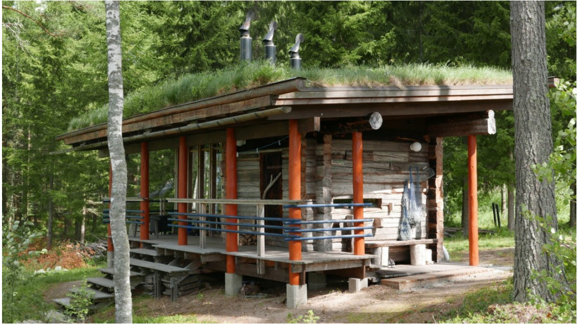
Kuva 3. Georg Grotenfeltin suunnittelema saunarakennus Vesannossa on valmistunut vuonna 2014. Kierrätys-hirsistä rakennetun saunan hirret ovat ajan kuluessa harmaantuneet. (Georg Grotenfelt 2020)
