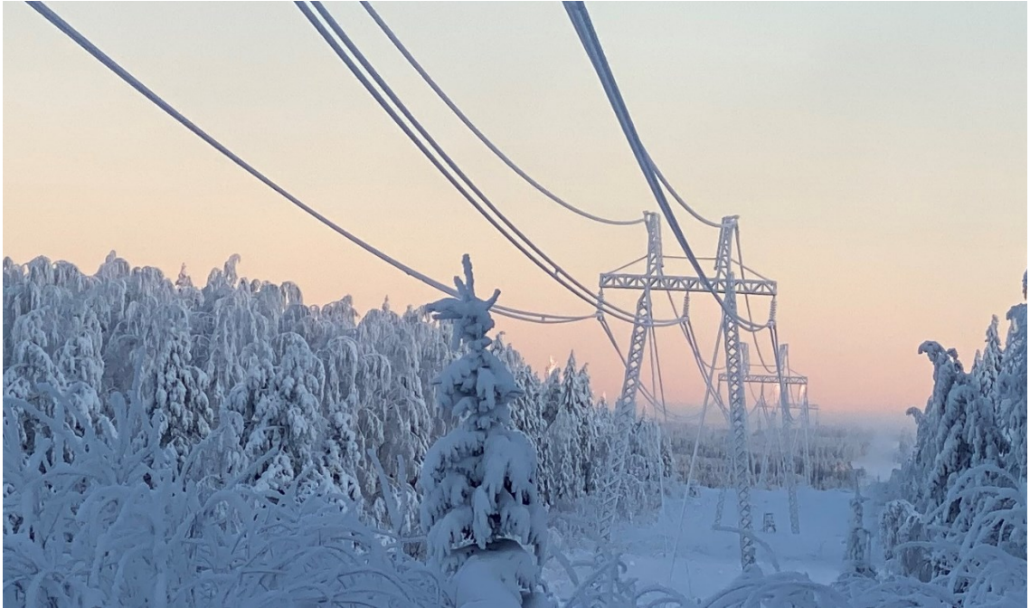
Kuva 11. Jääkuormaa johtimissa ja jääkuormapylväs [35.]
