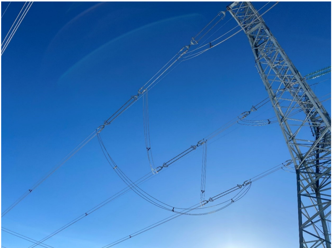
Kuva 6. Vaiheiden vuorottelu pylväällä.
