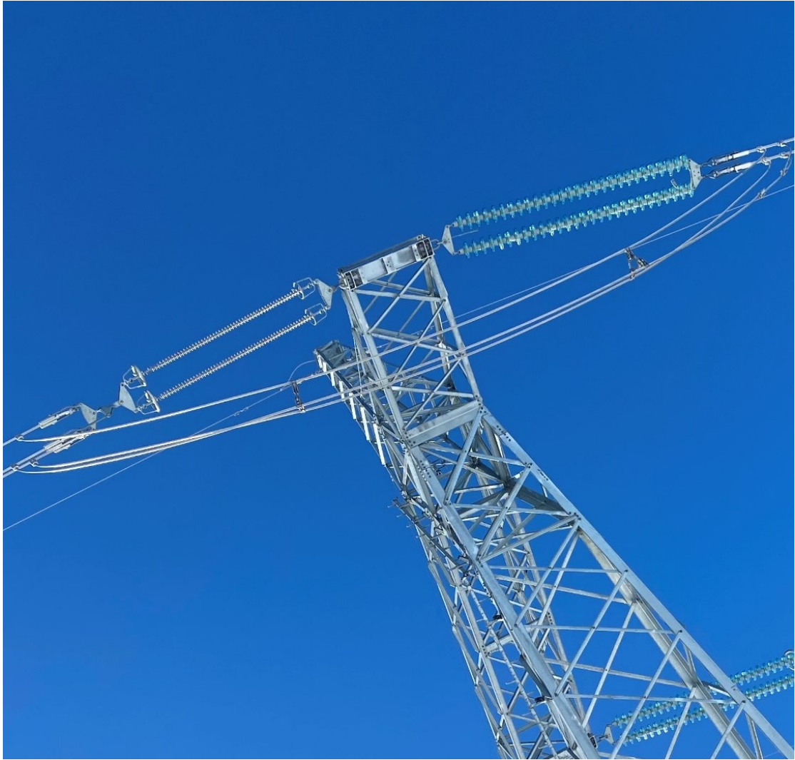
Kuva 5. Kiristyspylväällä komposiittieristinsauvat (vasemmalla) ja lasieristinketjut (oikealla.)
