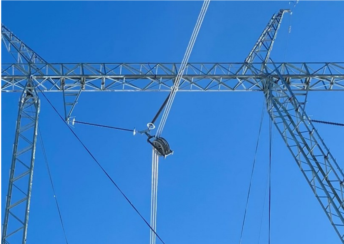
Kuva 10. Virtajohtimet vedossa johdinvetopyörällä 400 kV johdolla.
