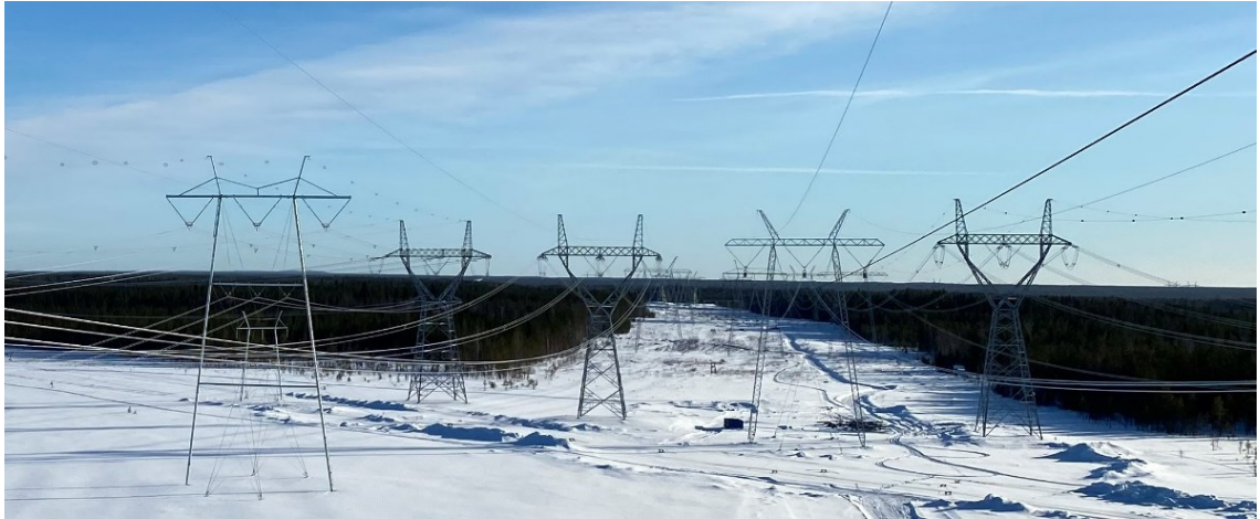
Kuva 3. Yleisiä 400 kV teräspylvästyyppejä Suomessa.
