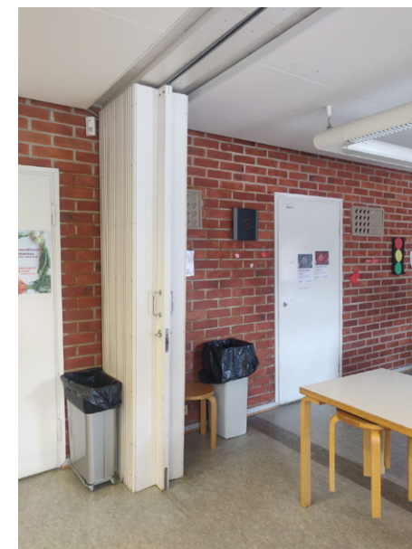
Kuva 43. Rakennuksen alkuperäisen osan tiiliseiniä.
