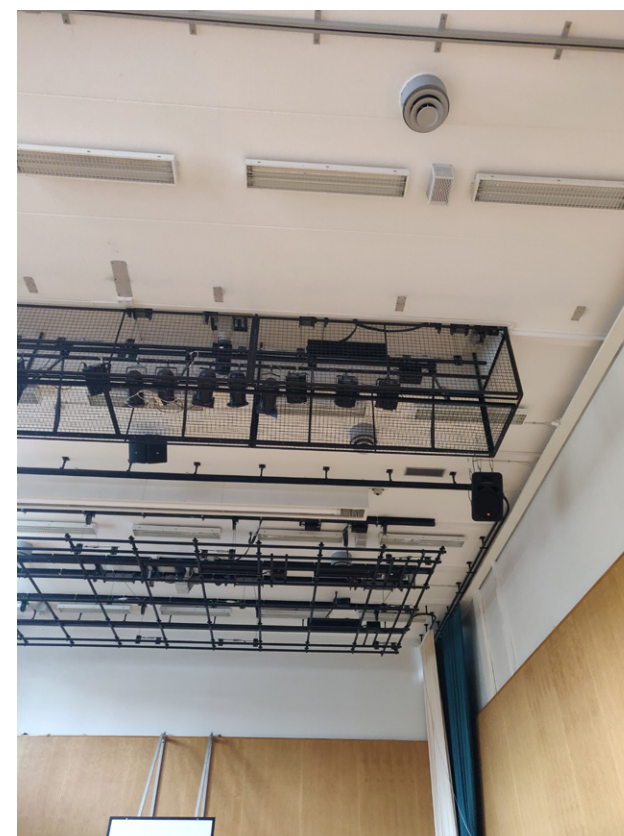
Kuva 27. Liikuntasalin yläpohjan ontelolaattoja.
