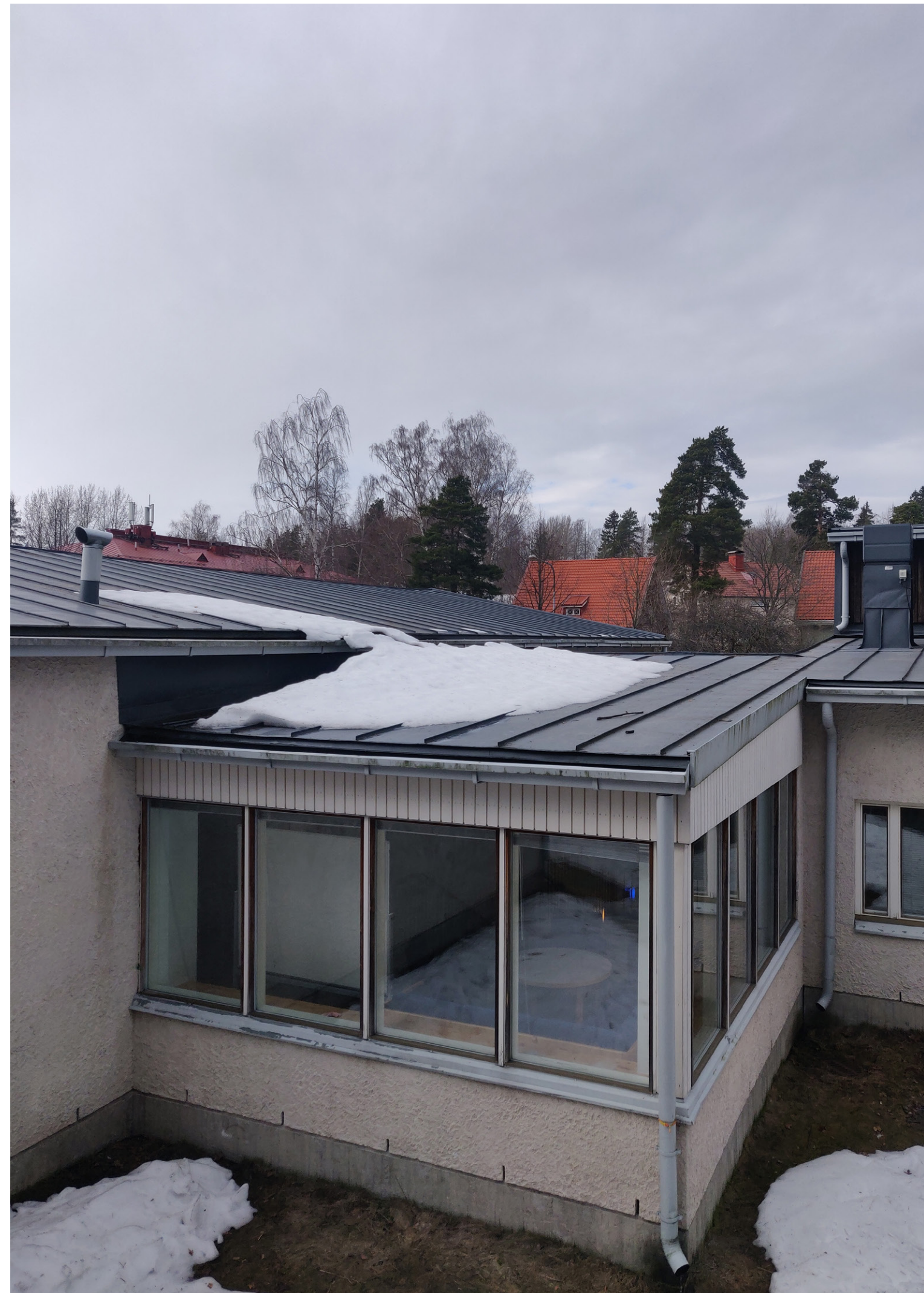
Kuva 36. Rakennuksen vesikate on pääosin konesaumattua peltiä.
