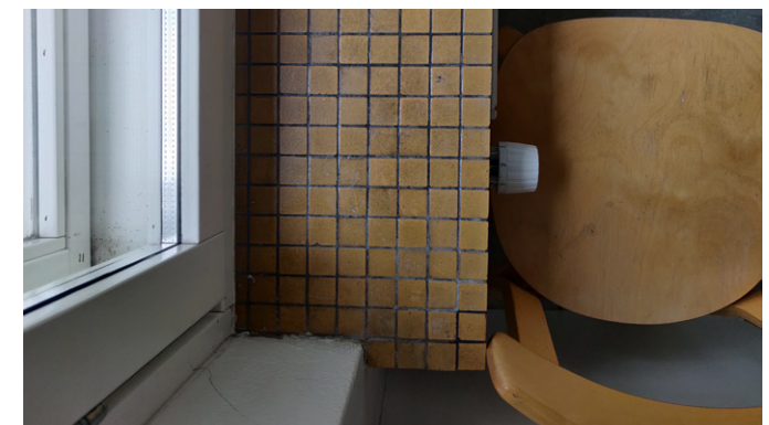
Kuva 16. Ikkunapenkki rakennuksen sisältä.
