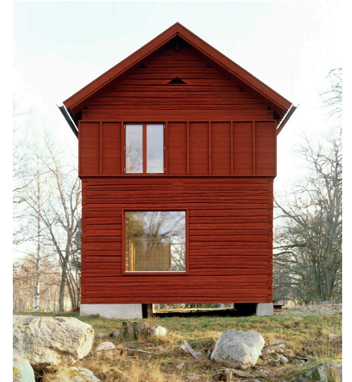
Kuva 6. Arkkitehtitoimisto General Architecture käytti vanhan hirsiaitan purettua runkoa yksityistalon kantavana rakenteena. (Kuva: Mikael Olsson 2019)
