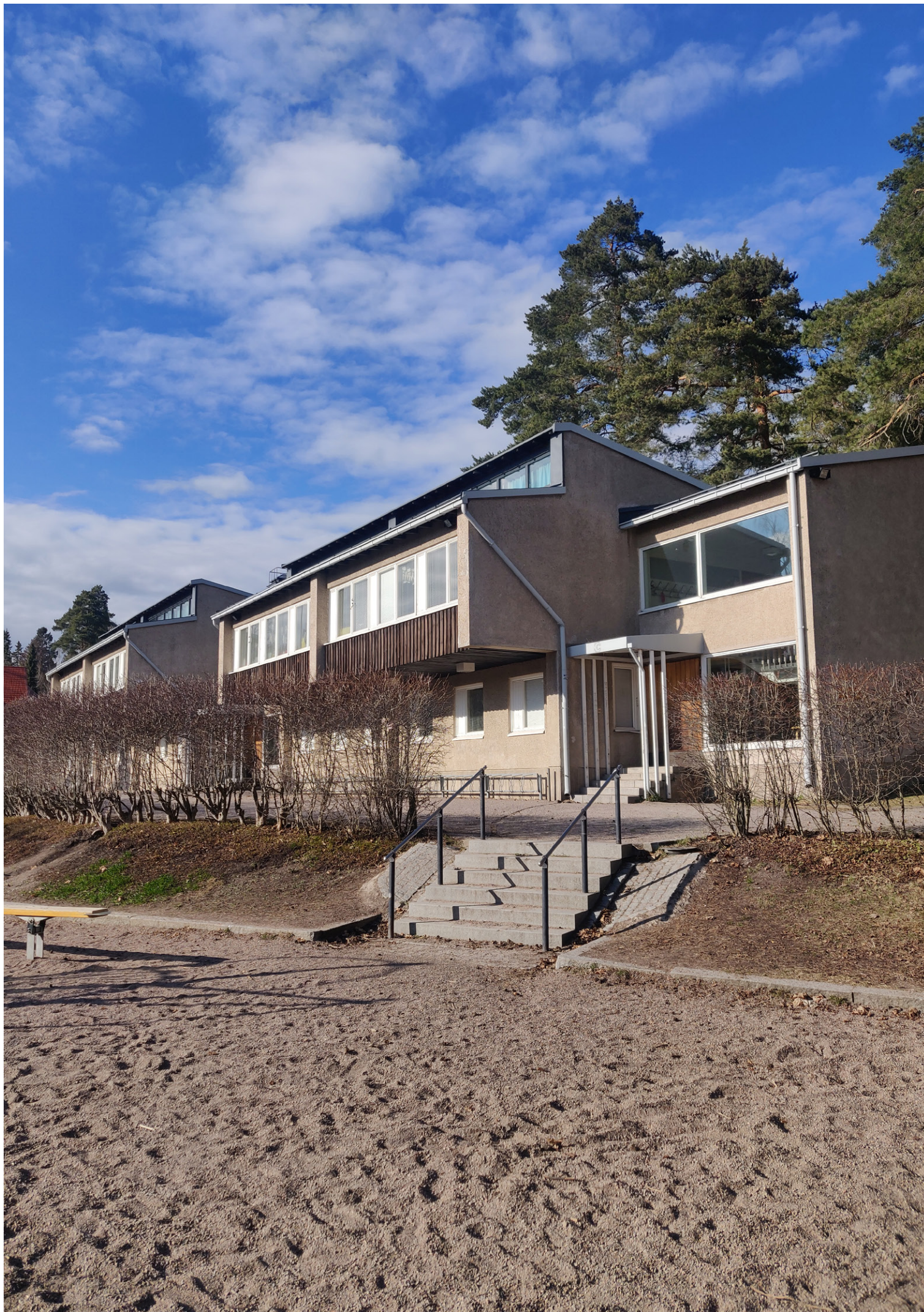
Kuva 20. Rakennus lounaasta päin katsottuna.
