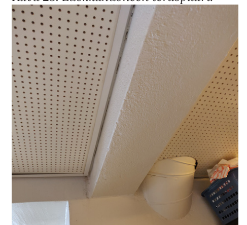
Kuva 24. Välipohjaa kannatteleva paikallavalettu teräsbetonipalkki rakennuksen alkuperäisessä osassa.
