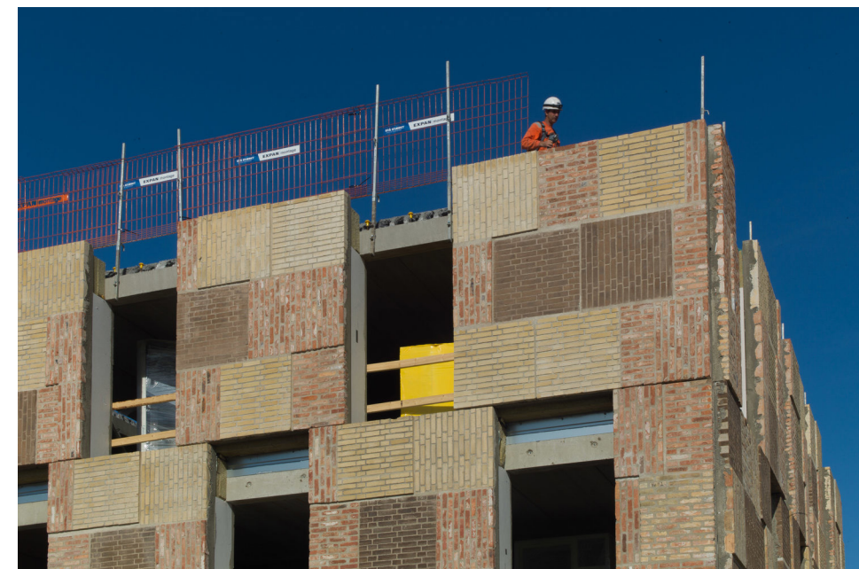
Kuva 11. Nykyään tiilimuurausten laastissa käytetty sementti on niin kovaa, että tiiliä on mahdotonta irrottaa toisistaan ehjänä. Tanskalainen Lendager Group on käyttänyt kohteessaan Resource Rows kokonaisia osia purettujen rakennusten tiiliseinistä julkisivuelementtien verhouksena. (Kuva: Tuntematton, Danish Design Review 2019)
