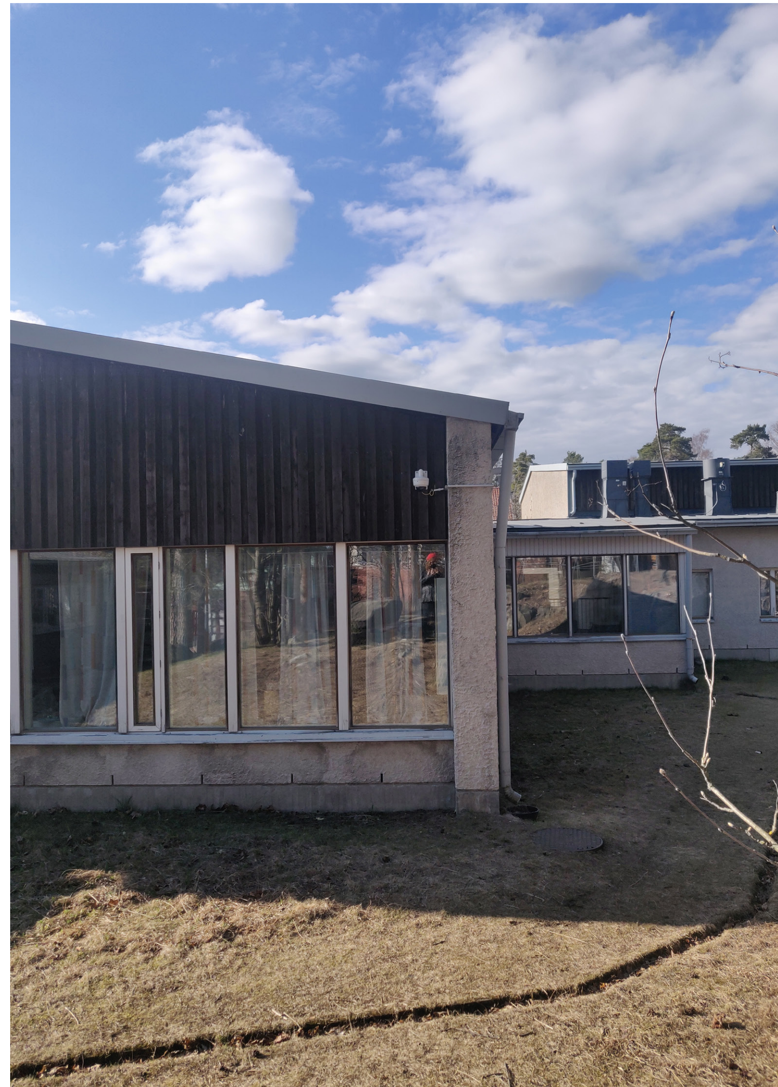
Kuva 29. Rakennuksen toisen kerroksen julkisivua.
