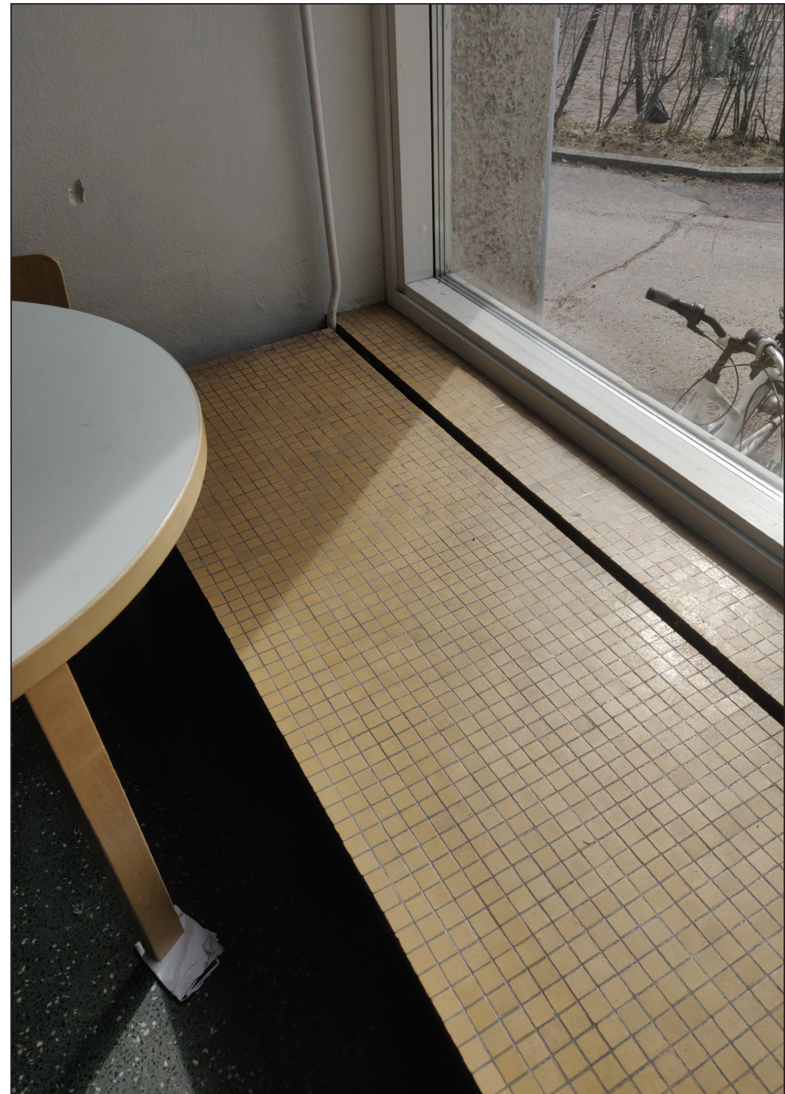
Kuva 58. Alkuperäisessä osassa ikkunapenkeissä on käytetty pieniä keltaisia kaakeleita.
