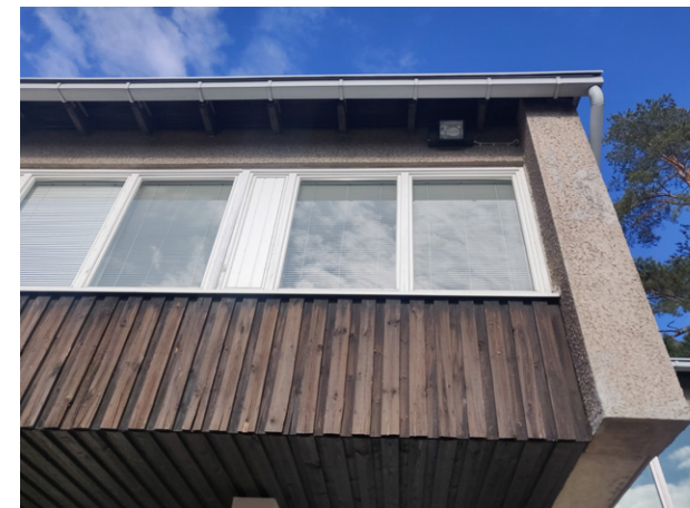
Kuva 31. Erkkerin julkisivupinnan lomalaudoitusta.
