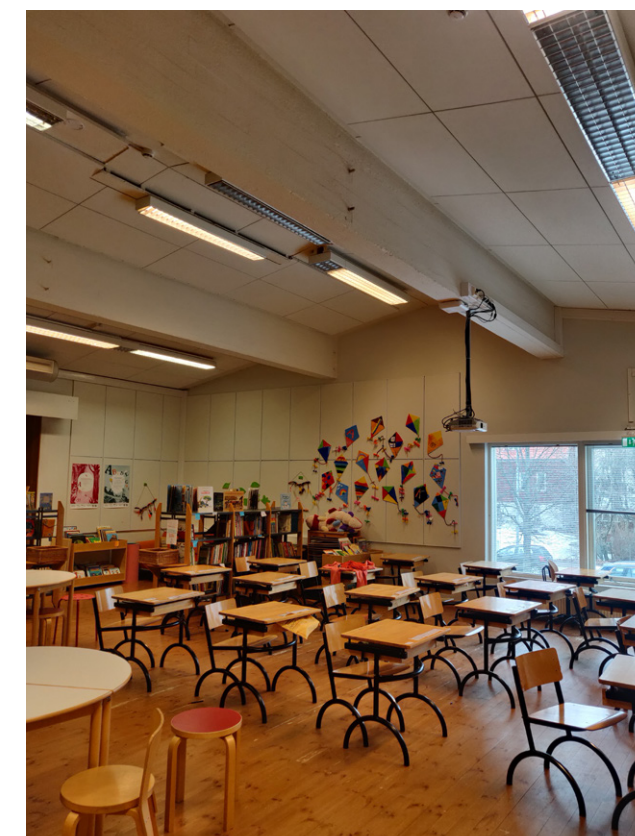
Kuva 28. Yläpohjia kannattelevia betonipalkkeja rakennuksen alkuperäisessä osassa.
