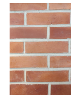
Paljaaksi jätetty tiiliseinä.
