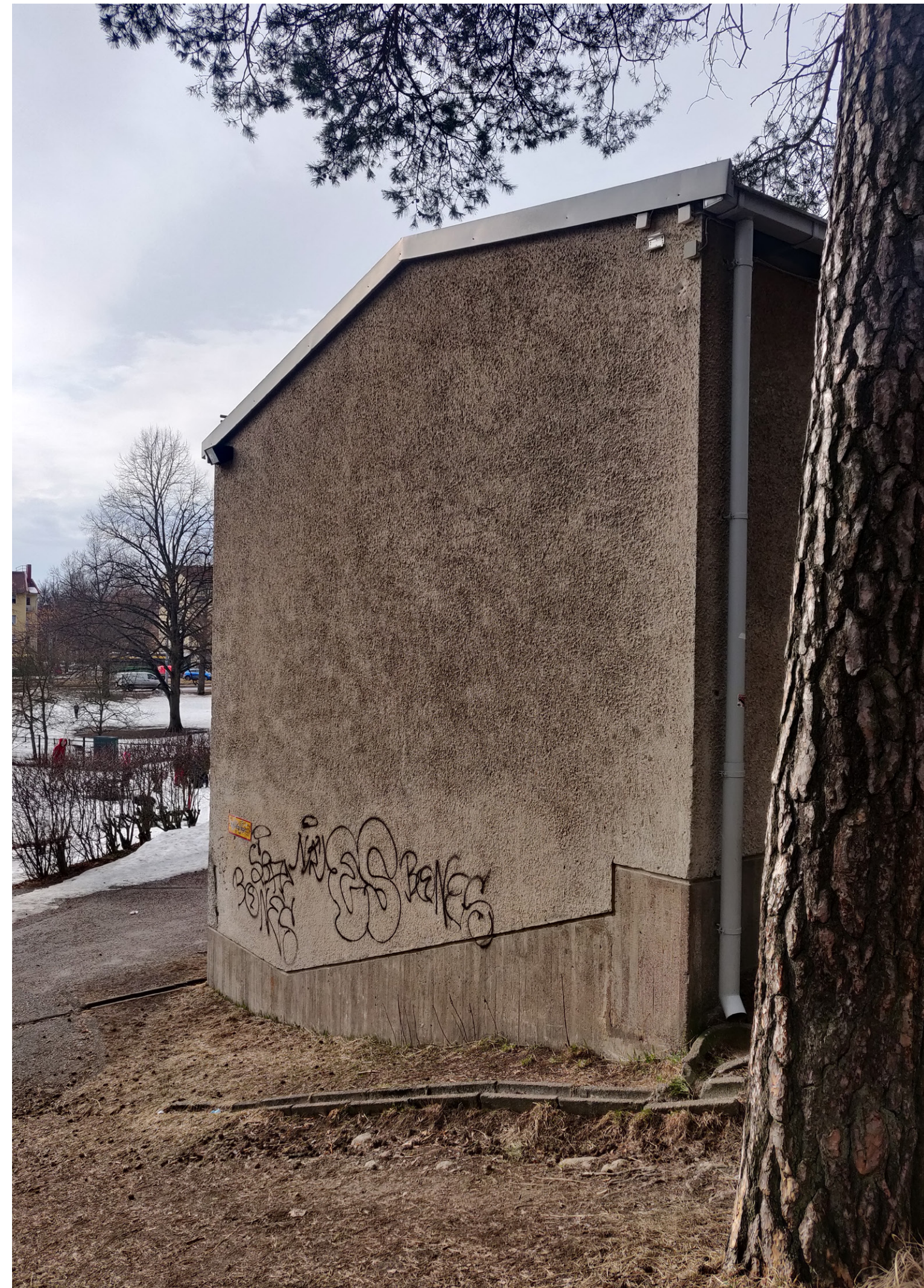
Kuva 18. Rakennus on perustettu osittain rinteeseen.
