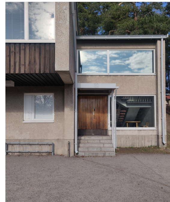
Kuva 34. Yksi rakennuksen pääovista.
