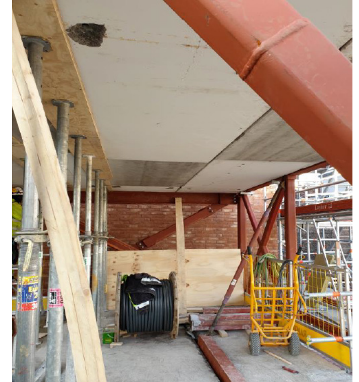
Kuva 7. Välipohjissa uudelleenkäytettyjä ontelolaattoja. (Kuva: Noora Khezri, Mad arkitekter)
