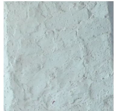
c. Maalattu ikkunasyvännys
