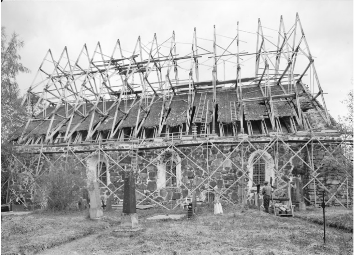
Kuva 17. Rakenteilla oleva uusi kattorakenne. Kuvalähde: P. O. Welin 1960-luvulla, Museoviraston kuvakokoelmat.
