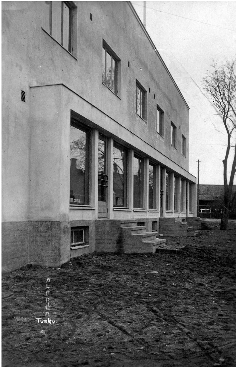
Kuva 67. Rakennus ei ole ulkoisesti kokenut merkittäviä muutoksia.
