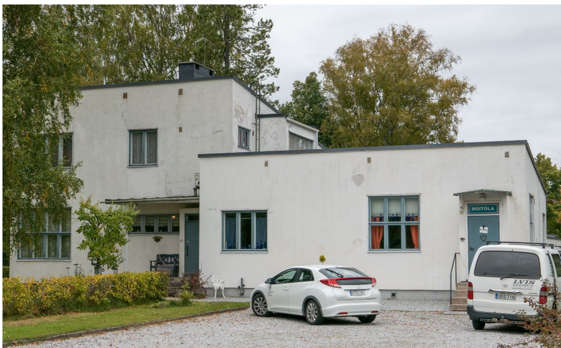
Kuva 60. Erik Bryggmanin apteekkirakennus.
