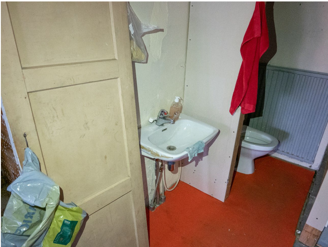
Kuva 36. Entisen varaston WC-tila on todennäköisesti toteutettu rakennuksessa toimineen baarin käyttöön.
