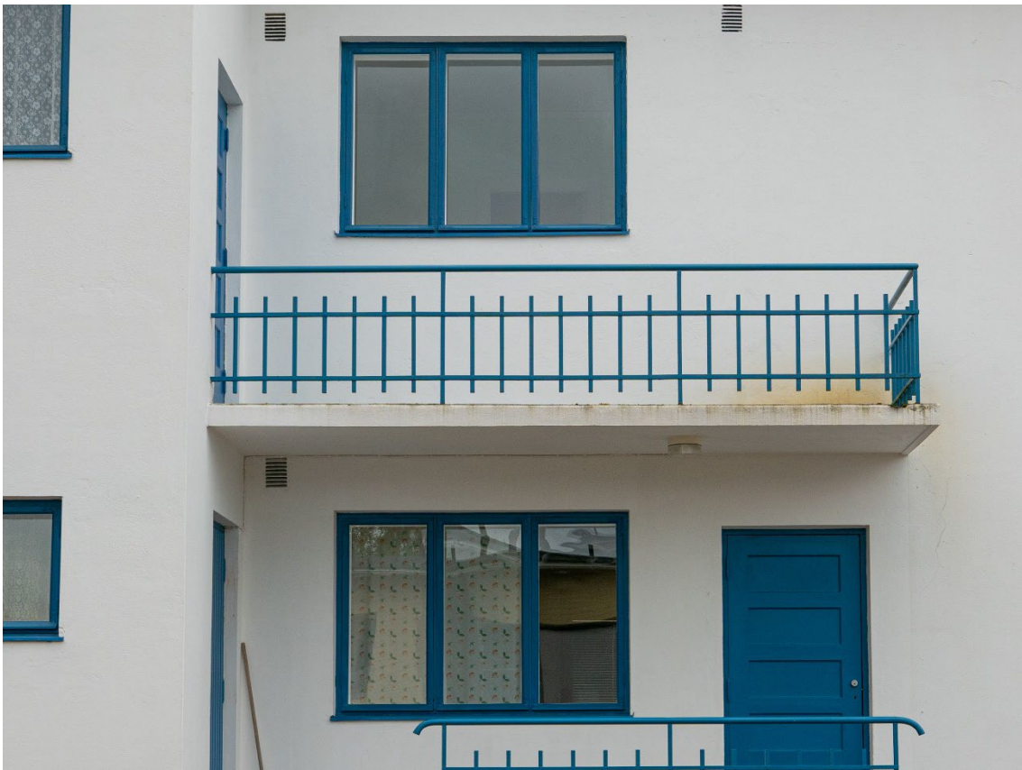
Kuva 57. Parveke sisäpihalta katsottuna. Putkiosien väri vastaa ikkunoiden sävyä.
