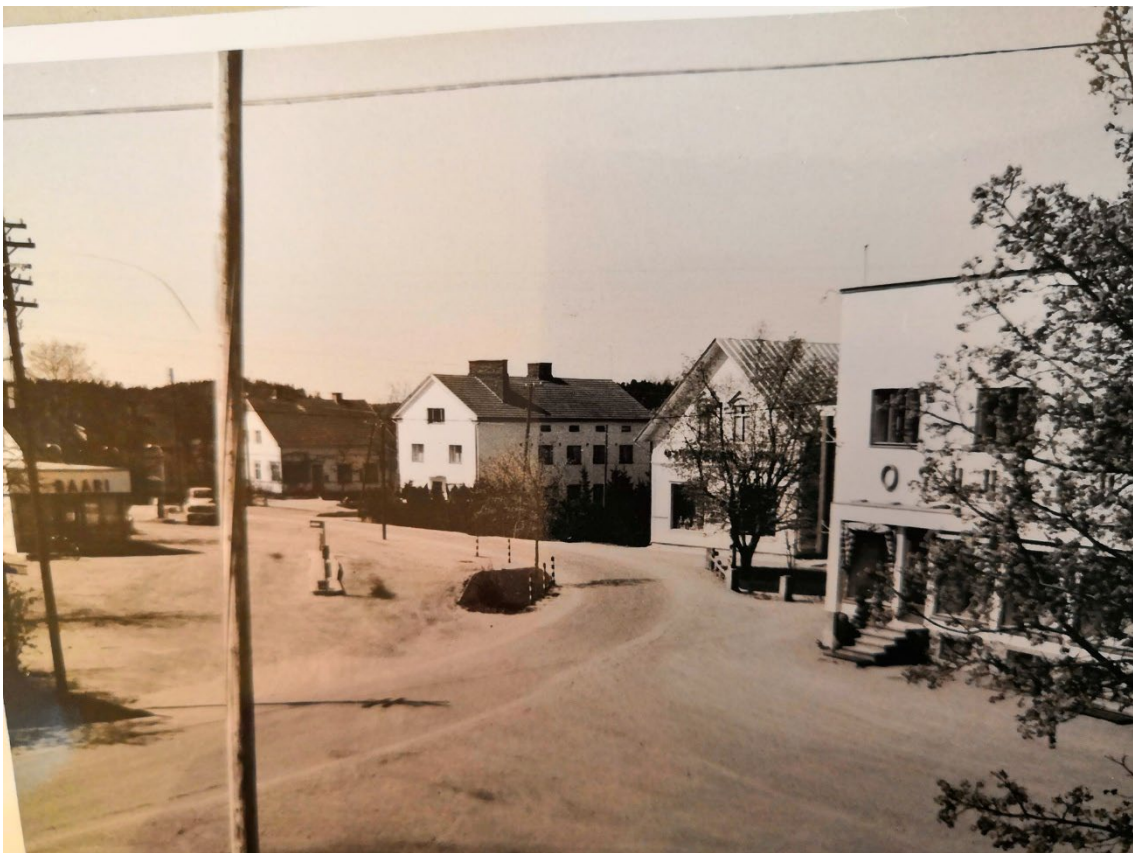
Kuva 65. Rakennuksen ympäristöä 1960-luvulla.
