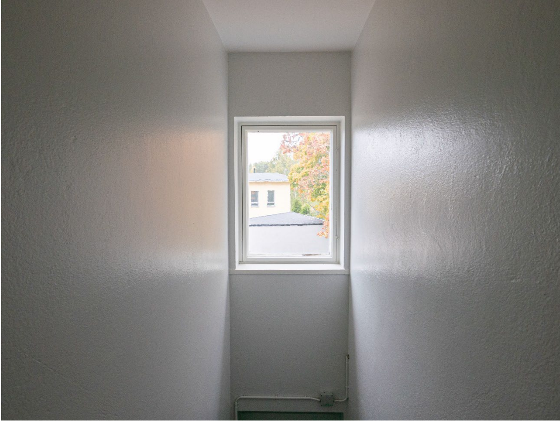
Kuva 49. Entinen työntekijöiden porrashuone on huomattavasti tiiviimpi.
