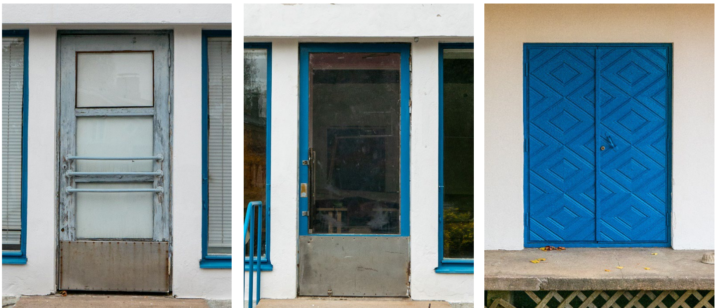
Kuva 28. Länsipuolen alkuperäinen ulko-ovi, muutettu ulko-ovi ja pihan jugend-tyylinen ovi.
