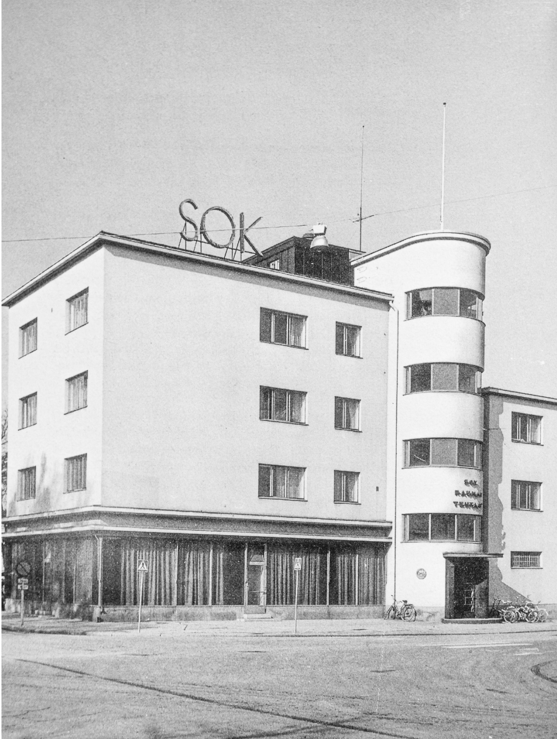
Kuva 10. SOK:n Rauman konttorin varastorakennus, 1930–31.
