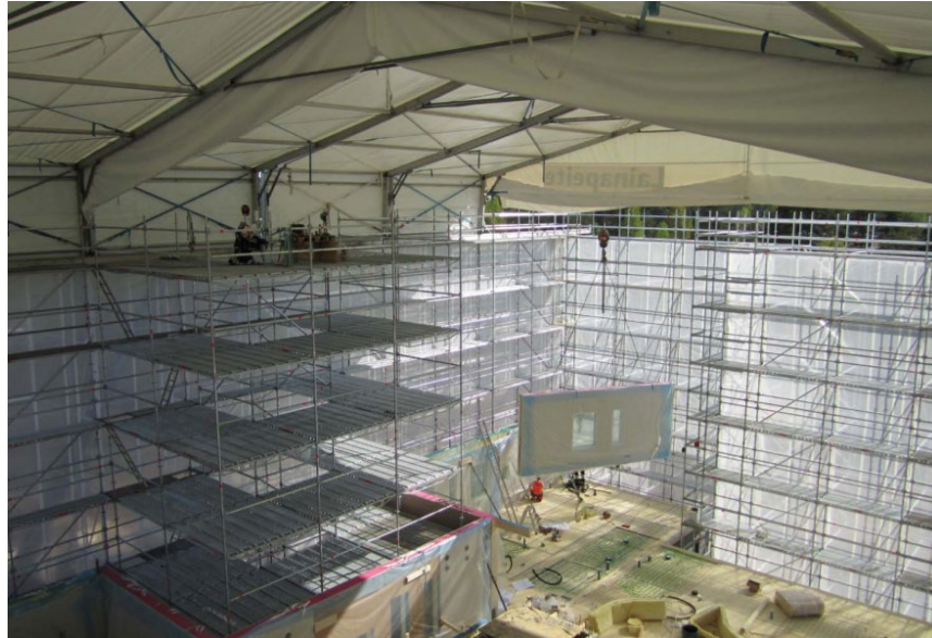
Kuva 17. Rakennus on huputettu sääsuojalla. Rakentaminen tapahtuu kokonaan suojan sisällä. (Talonrakennusteollisuus ry 2016)
