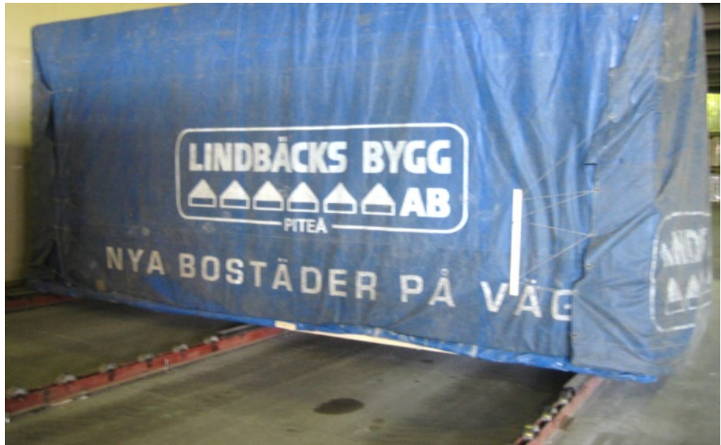
Kuva 19. Suojahuputettu tilaelementti (Puuinfo 2020a).
