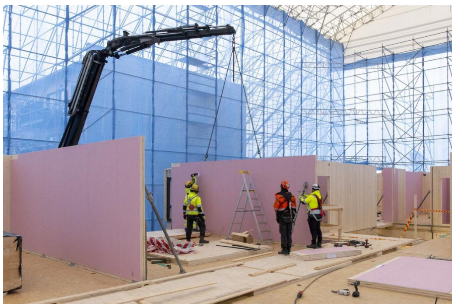
Kuva 22. Elementtejä nostetaan paikoilleen nosturiauton avulla (Välilä 2019).
