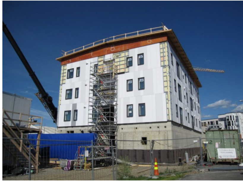
Kuva 25. Rakennuksen kastuminen on estetty väliaikaisella suojakatolla (Puuinfo 2020a).
