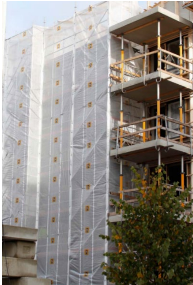
Kuva 16. Rakennuksessa on käytetty suojauksena julkisivusuojia (Talonrakennusteollisuus ry 2016).
