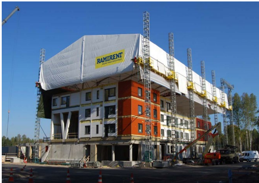
Kuva 21. Puukerrostaloa rakennetaan sääsuojateltan alla (Viljakainen 2017).
