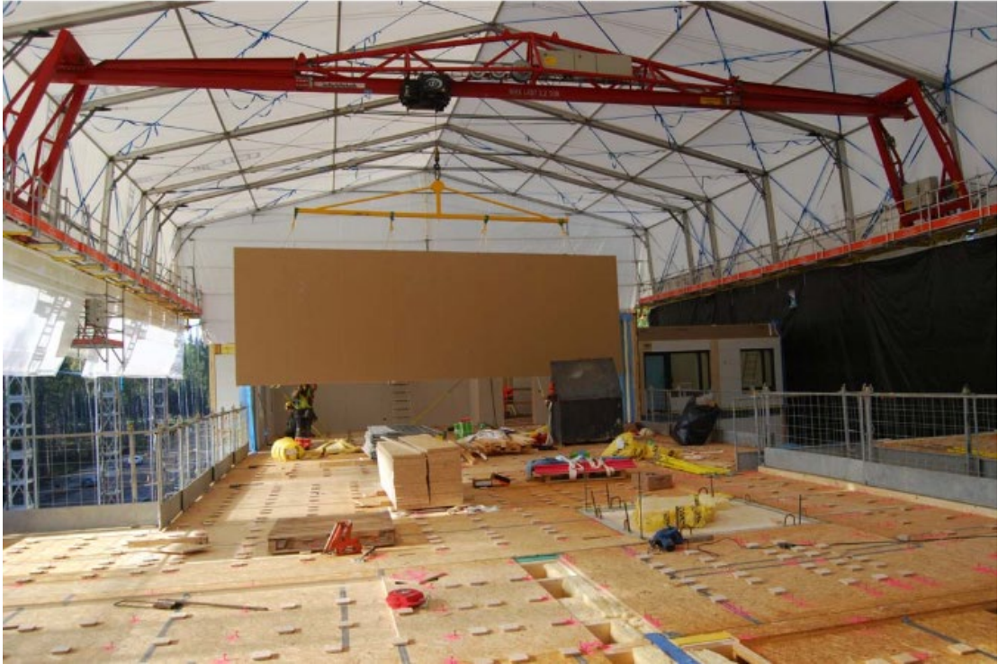
Kuva 23. Sisäkuva suojateltasta, jossa elementit nostetaan paikoilleen siltanosturin avulla (Viljakainen 2017).
