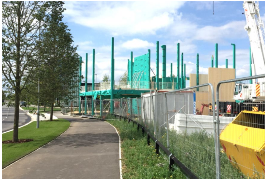
Kuva 29. Muovikalvolla suojattu pilari-palkkirakenteinen runko (Puuinfo 2020a).
