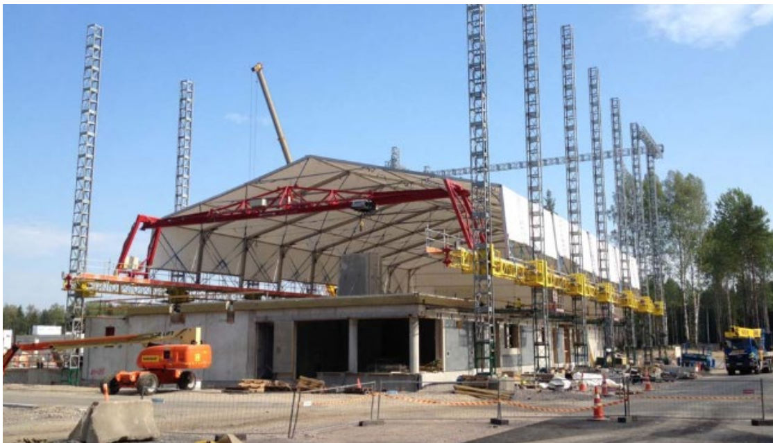
Kuva 24. Ulkopuolelta kuva teltasta, jossa käytetään siltanosturia apuna elementtien asentamisessa (Viljakainen 2017).
