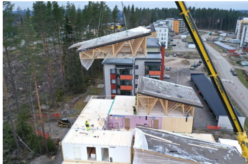
Kuva 26. Rakennuksen oikea vesikatto toimii rakennuksen sääsuojana (Puuinfo 2020a).
