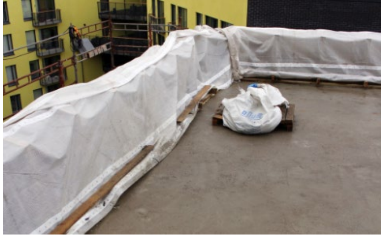
Kuva 15. Rakenteiden suojaamisessa voidaan käyttää erilaisia suojapeitteitä. Kuvassa suojaamiseen on käytetty pressua (Kosteudenhallinta 2022).
