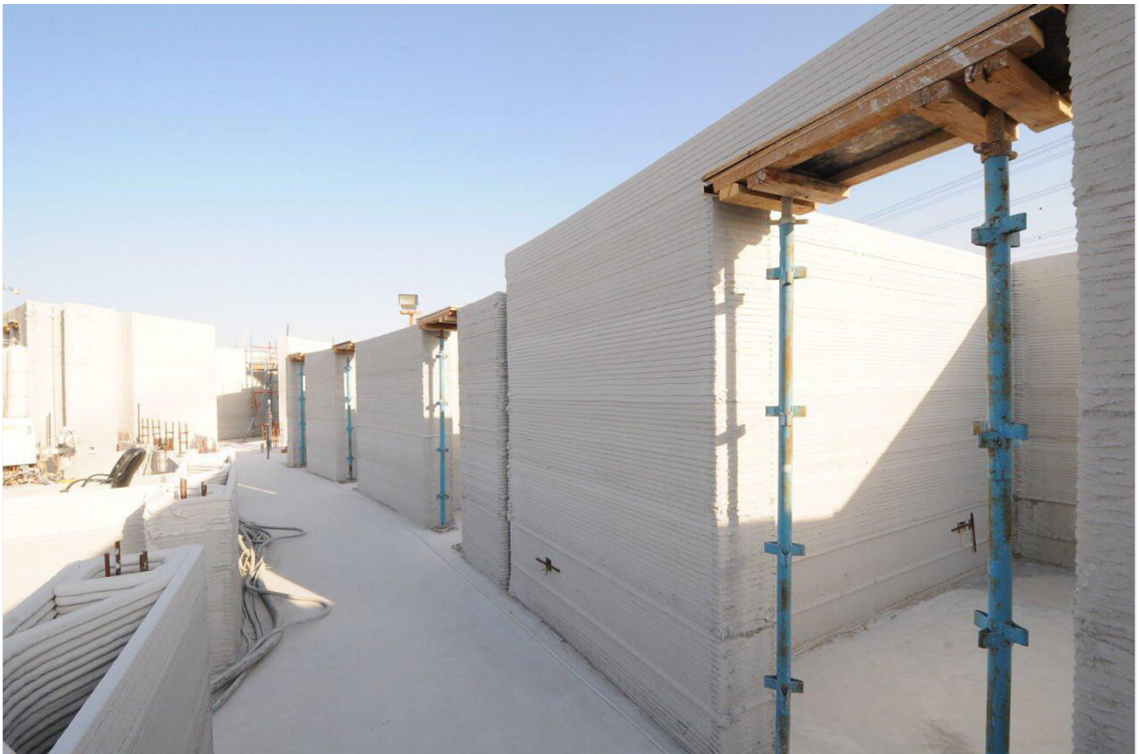
Kuva 3. Betonista 3D-tulostetussa rakennuksessa ikkuna- ja oviaukkojen kohdille rakennettuja väliaikaisia tukia, joiden päälle 3D-tulostin tulostaa. (Apis Cor)
