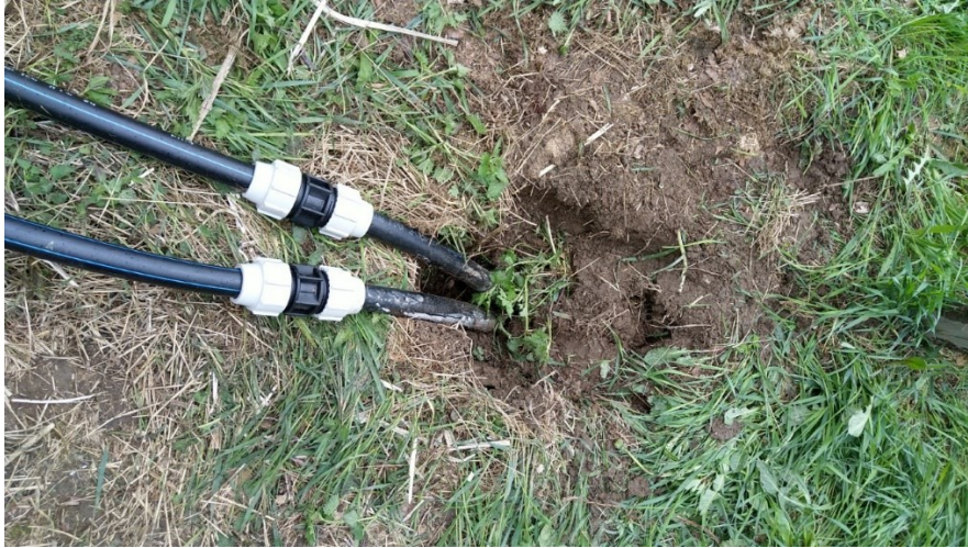
Kuva 4 Savimaahan upotettu pilottipaalu
