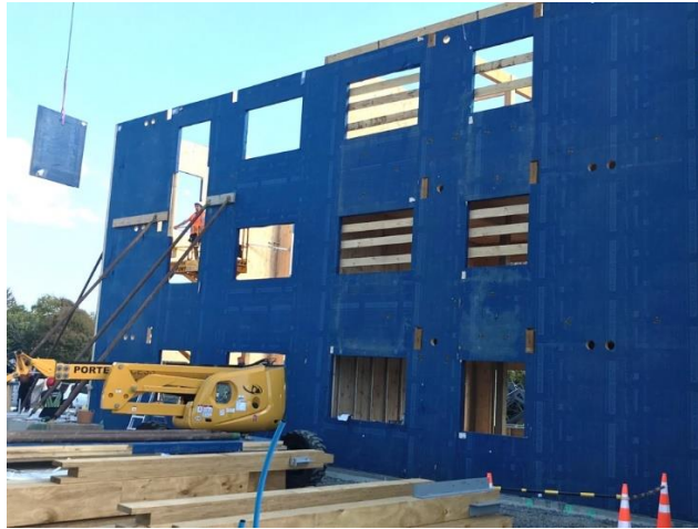
Kuva 9. CLT-elementit esiasennetulla mikrokuitukankaalla suojattuna (Puuinfo 2020)
