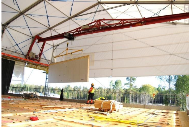
Kuva 7. Telttasuojaus ja suurelementin asennus (Puuinfo 2020)
