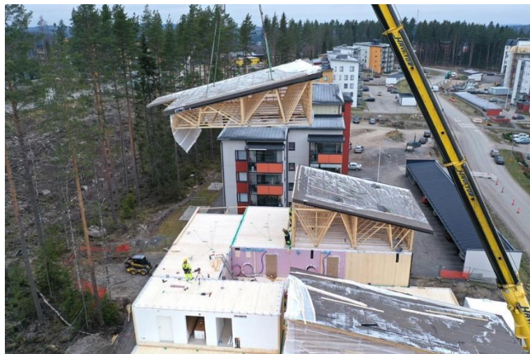
Kuva 8. Suojakaton asennus menossa (Puuinfo 2020)
