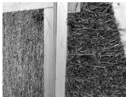
Kuva 5 malli Elementtijärjestelmän kantavasta puurungosta (Rakenteessa 6% puuta, 94% olkea)
