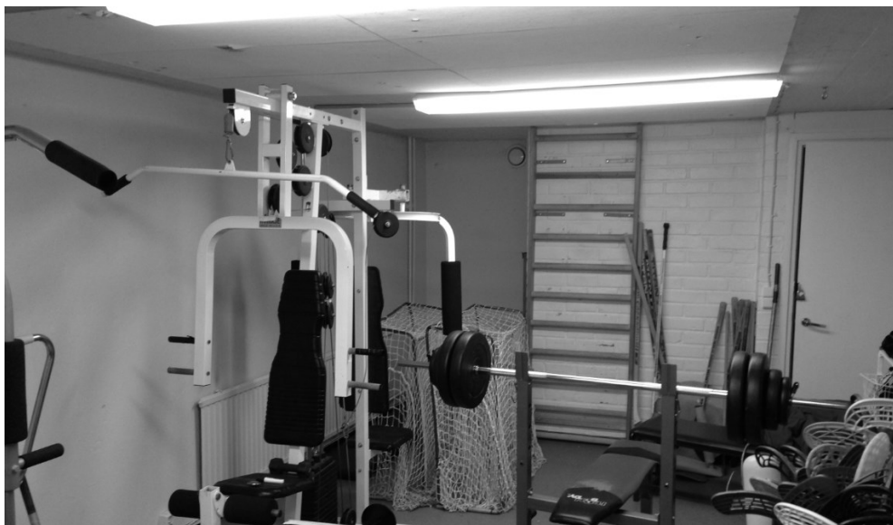
Kuva 1. Tuleva tarkkaamo eli kellarivarasto. Kuvassa näkyvä tiiliseinävarasto purettiin.
