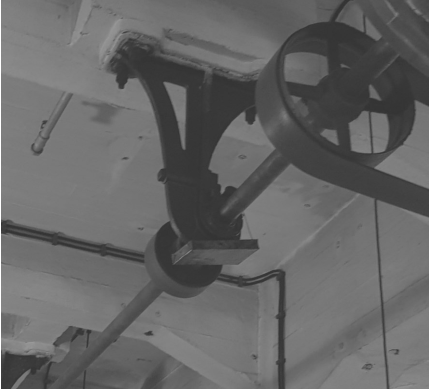
Kuva 3. Verlan tehdasmuseossa on voimansiirtoakselien alla öljyn keräysastiat. Palkkirakenteissa on akselien kannattimien kohdilla erillisiä betonirakenteita.
