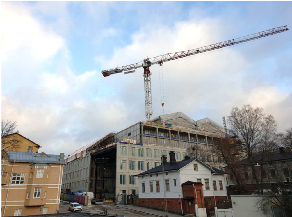
Kuva 7 Rakennuksen sadevesien hallinta toteutettiin koko rakennuksen kattavalla sääsuojalla.
