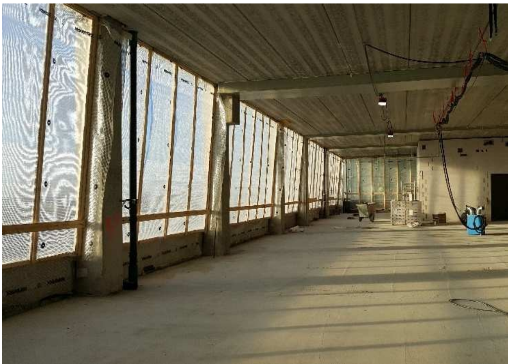
Kuva 9 Kohteen sääsuojausta ja lämmittämistä runkotyövaiheessa.
