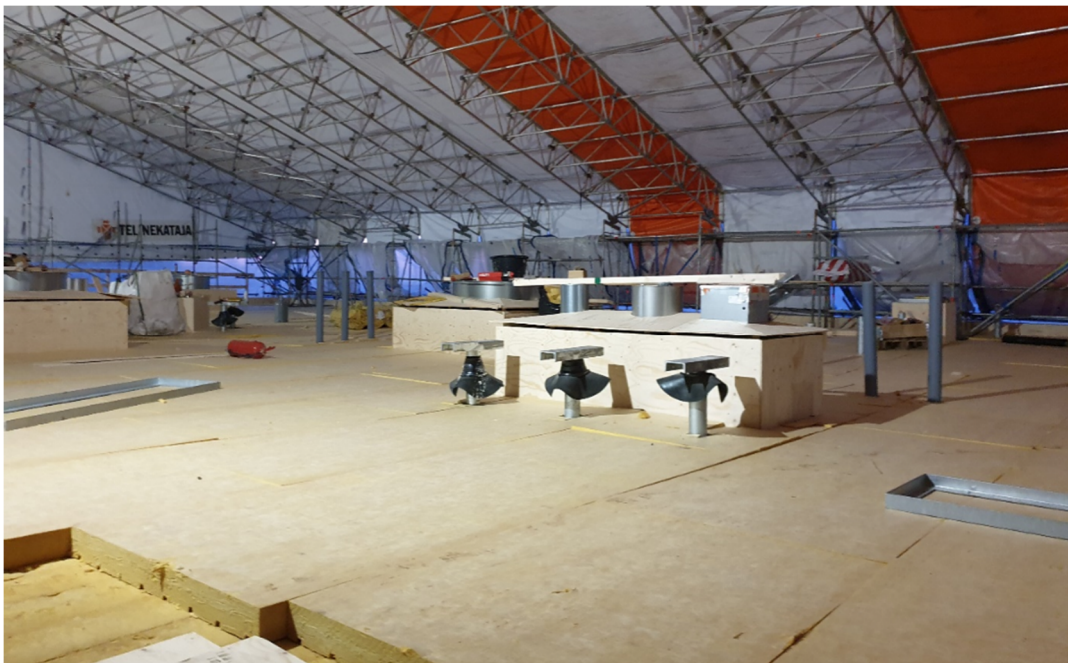
Kuva 8 Yläpohjan lämmöneristystyöt toteutettiin sääsuojan alla.
