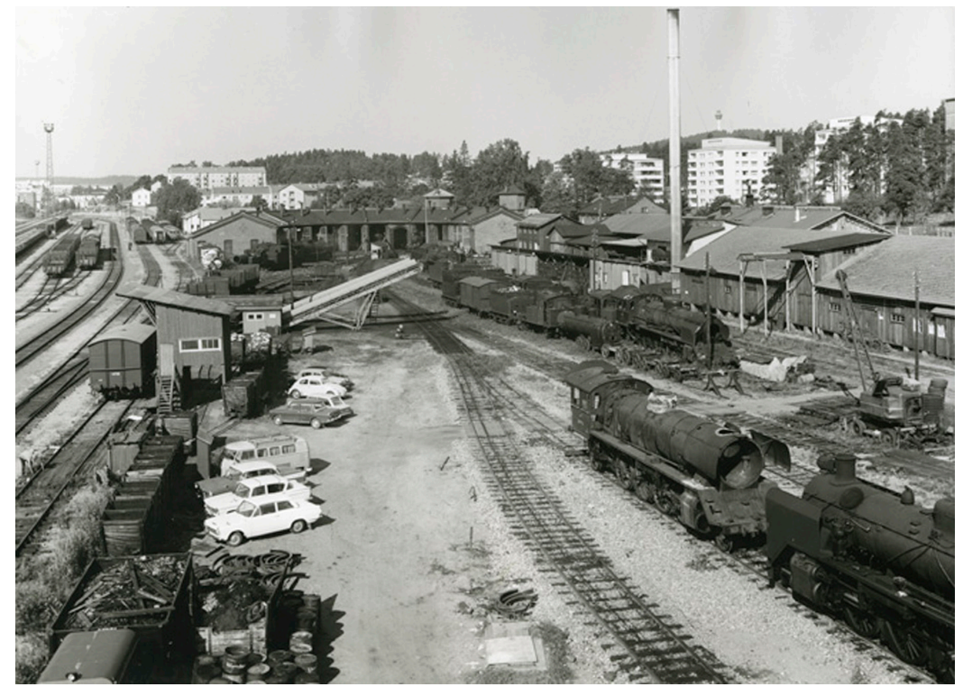
Kuva 20. Näkymä ratapihalta kohti veturitallia vuonna 1969. (Kuva: Lehtonen 1969, SRM)
