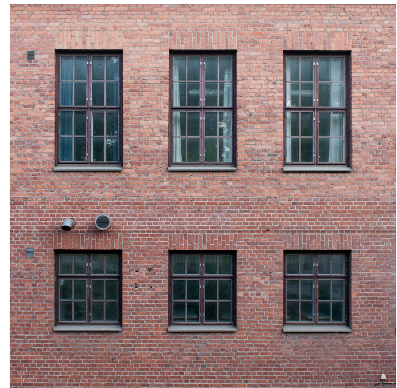
Kuva 40. Konepajan julkisivujen tiililadonnasta ja sävyeroista voi tunnistaa rakennuksen vaiheita ja kerrostumia.
