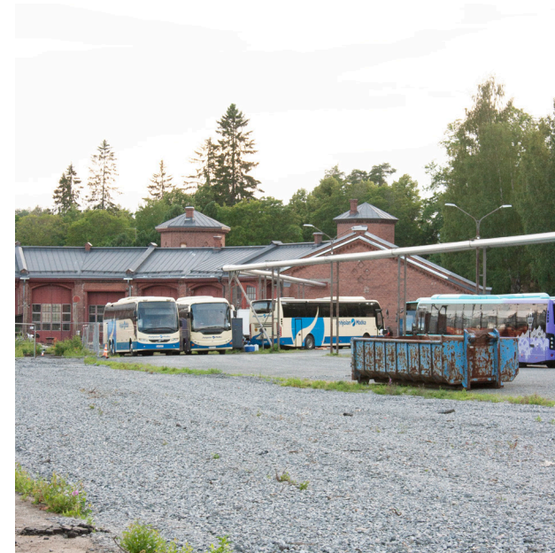
Kuva 23. Näkymä kohti Veturitallia. Vanhat pihan poikki kulkeneet raiteet on poistettu ja vanha ratapiha on nykyisin pysäköintikäytössä. Ilmassa kulkeva kaukolämpöputki kulkee koko pihan poikki Veturitallilta Konepajalle.
