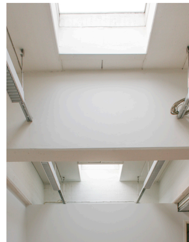
Kuva 92. Kattoikkunat tuovat valoa rakennuksen rungon keskelle.
