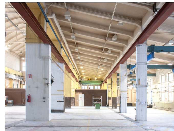
Kuva 45. Pulpettikattoista hallin osaa jakavat betoniset pilaririvistöt.
