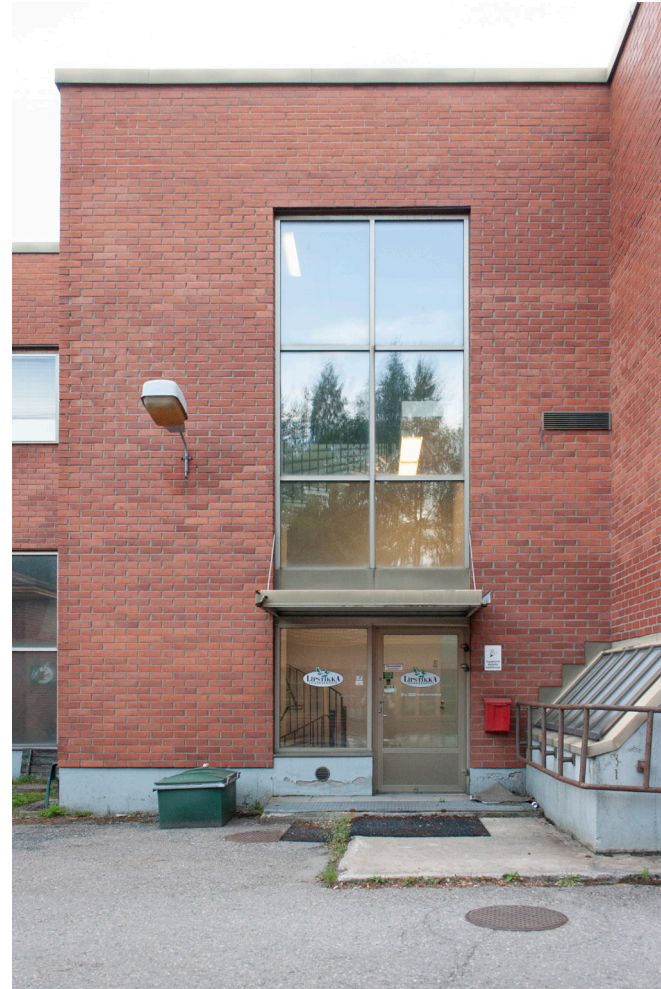
Kuva 107. Porrashuoneesta on käynti yläkerran ruokalaan ja alakerran hallitiloihin.
