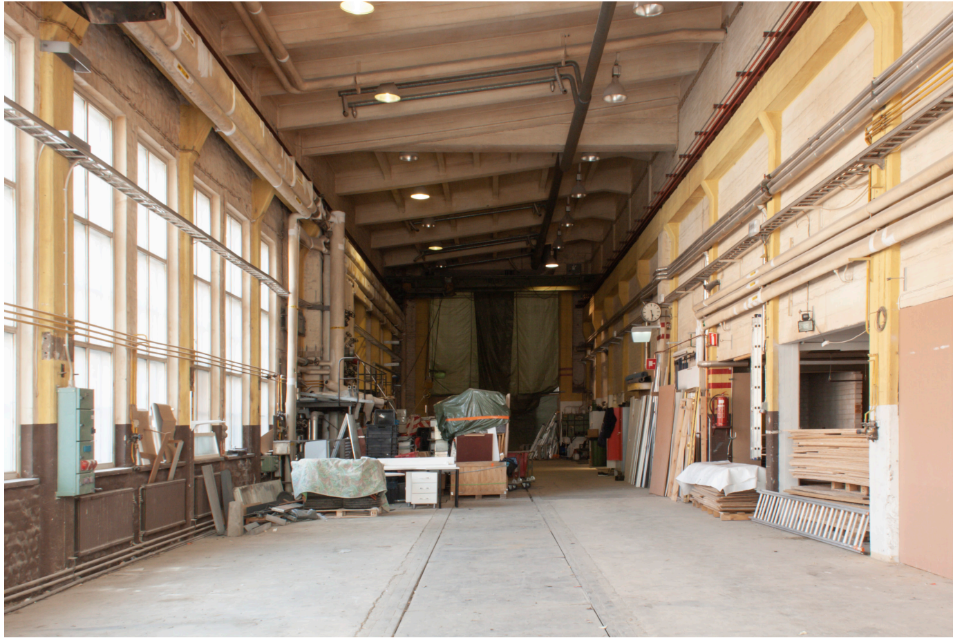
Kuva 62. Näkymä sisäpihan puoleisesta hallisiivistä kohti veturinkorjaushallia. Lattiassa näkyvät vanhat raiteet. Päätyseinän oviaukko on peitetty pressuilla.
