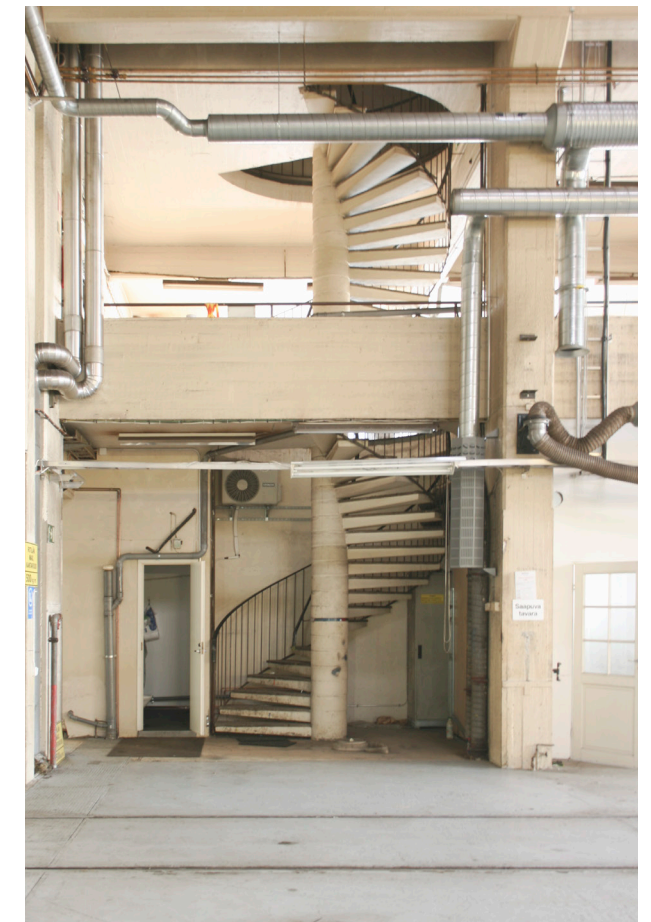
Kuva 80. Alkuperäinen betonirakenteinen kierreporras johdattaa toisen ja kolmannen kerroksen tiloihin.
