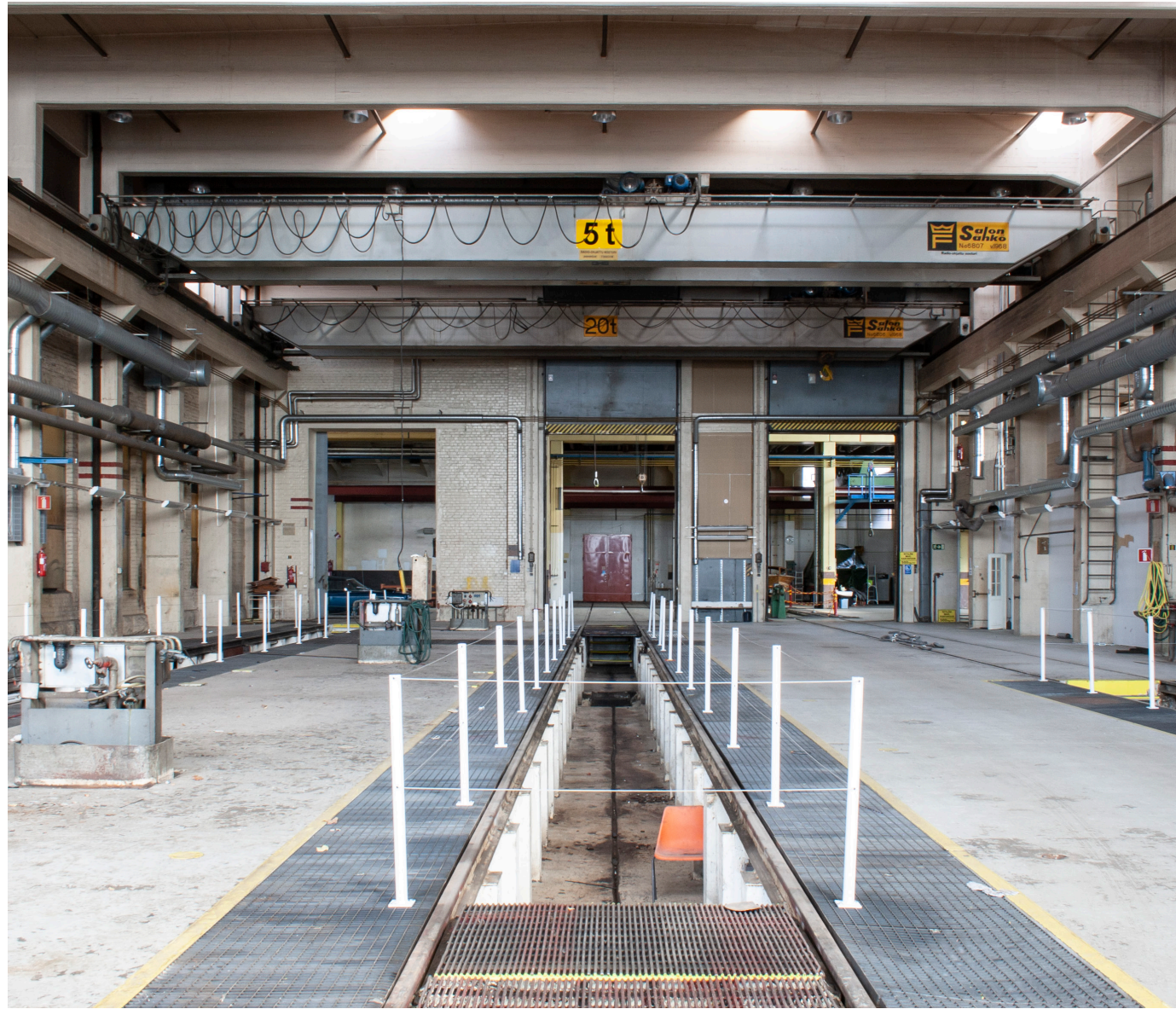
Kuva 78. Näkymä hallin länsipäädystä kohti kaarikattoista hallia.
