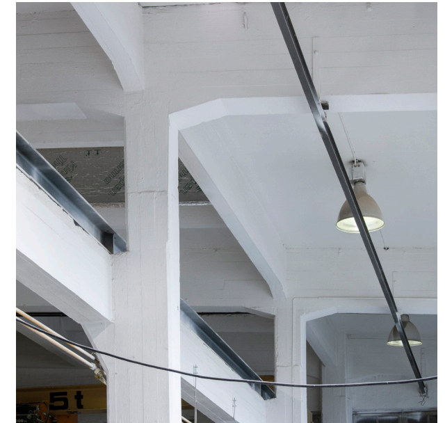
Kuva 71. Sirot ja valkoiseksi maalatut betonirakenteet kiinnittävät katseen tilassa. Palkiston välistä pilkottaa entinen, umpeen eristetty, kattoikkuna.
