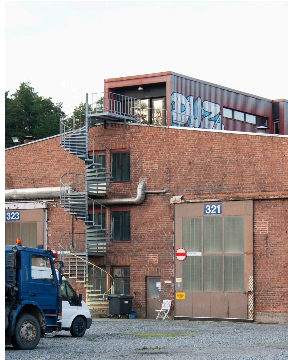
Kuva 63. Päätyjulkisivun liukuovet avautuvat halleihin. Pukuhuone- ja saunatiloista on yhteys ulkoportaaseen.
