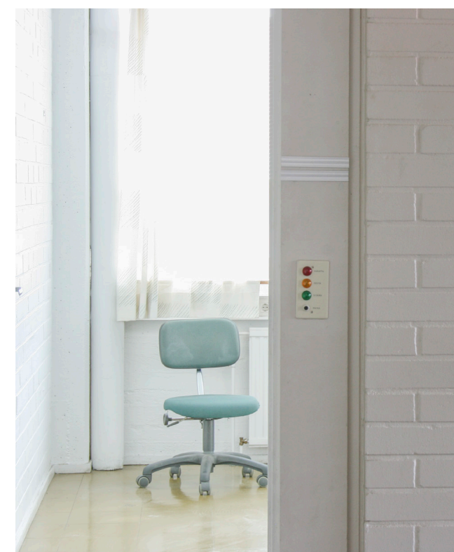
Kuva 93. Kolmannen kerroksen tilat on jaettu toimistohuoneiksi. Huoneita jakavat tiilimuuratut väliseinät.
