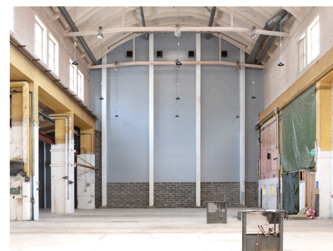
Kuva 47. Hallin pohjoispääty katkeaa Konepajan toiminnan päättymisen jälkeen lisättyyn teräselementtiseiniin. Kuvassa oikealla vanha oviaukko on peitetty pressulla.
