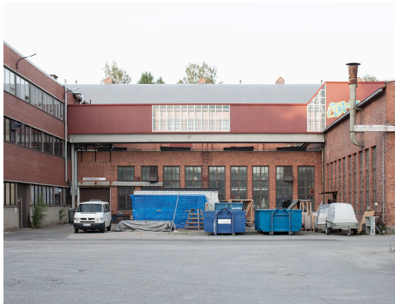
Kuva 69. Näkymä kohti vanhaa koneistushallia.
