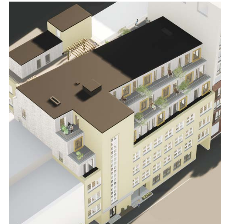
Porrastavassa päädyssä tiilimuuraus
