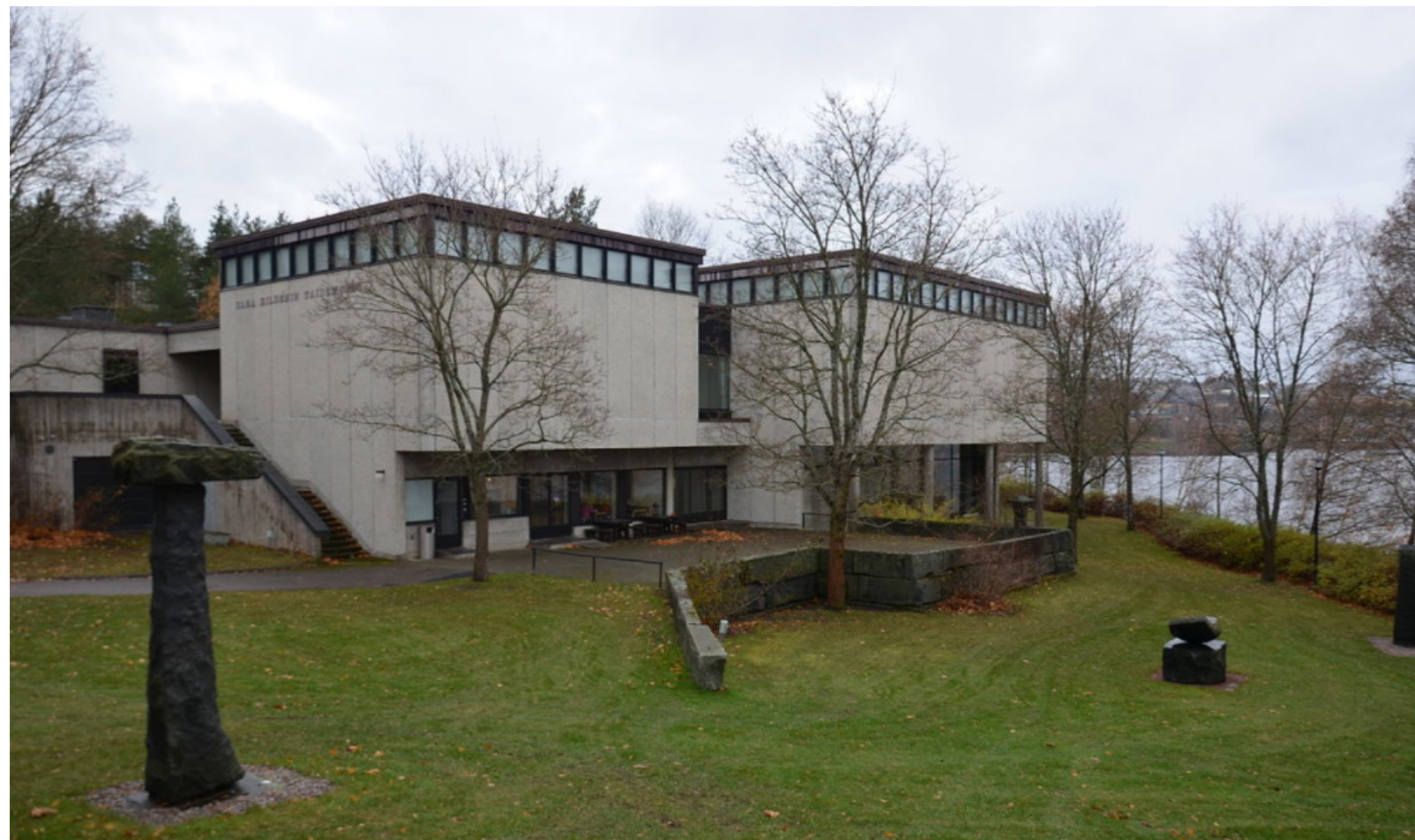
Kuva 11. Sara Hildénin julkisivuja ja loggioita. (Bengt Oberger)
