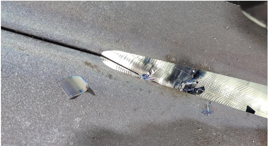
Kuva 56. Polttoleikatun railon keskeneräinen jrsintä
