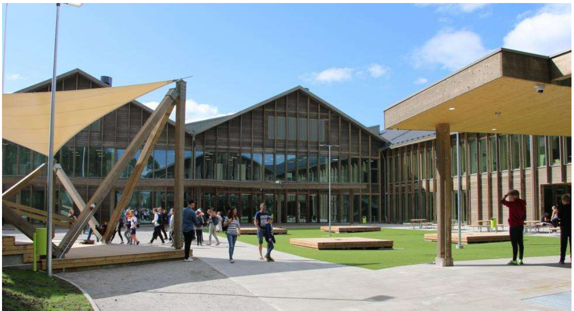
Kuva 10: Mansikkalan puukoulu, ulkokuva (Kauppi 2020)
