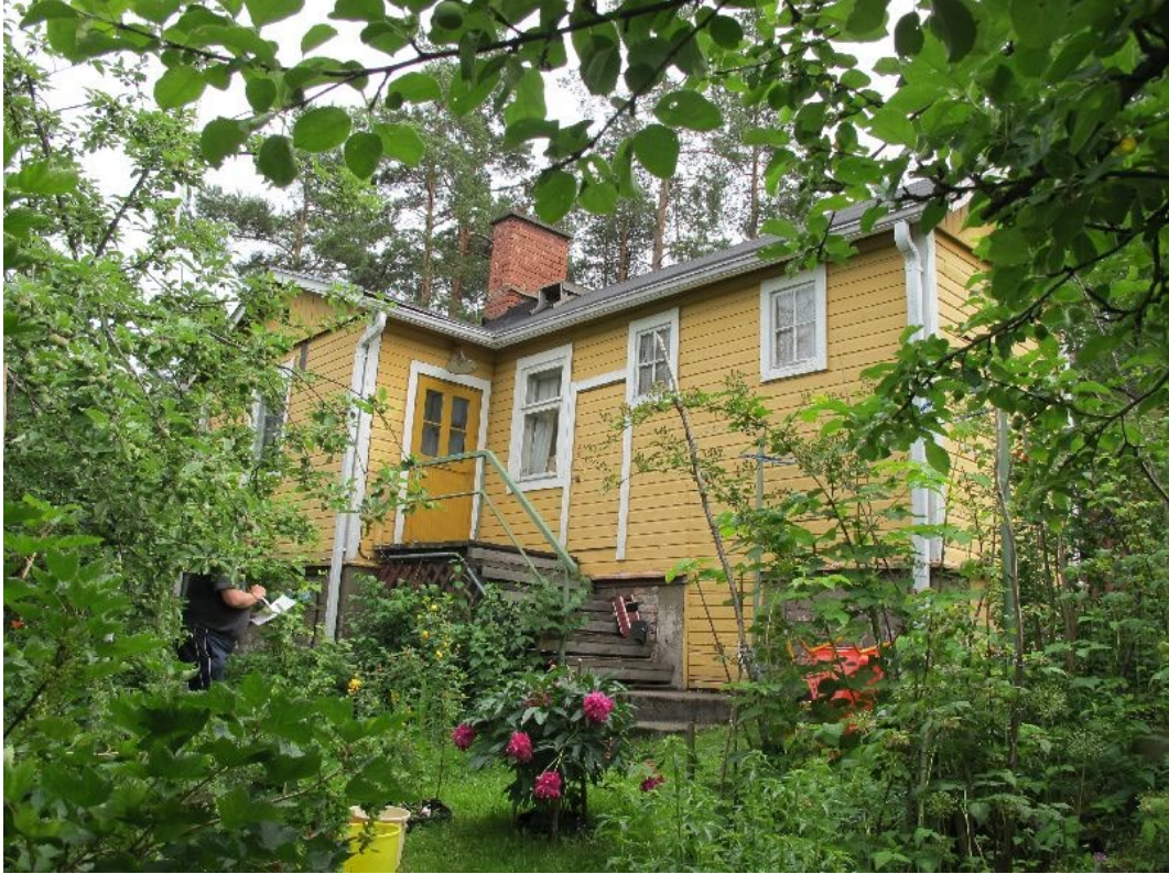
Kuva 4. Alkuperäinen 1920-luvun piharakennus. Käpytie 32. (Haavisto, 2013).
