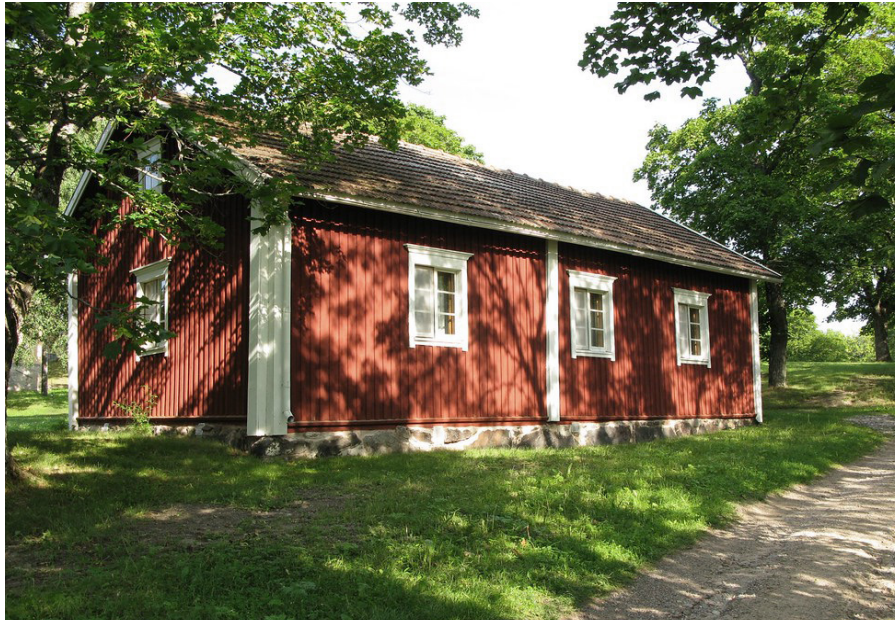
Kuva 11. Klassismi ilmeni vaatimattomissakin rakennuksissa. Julkisivuvärytyksessä kopioitiin kivirakennuksia: punamulta jäljitteli tiiltä ja keltainen väri hiekkakiveä. (Kuva: Leo-Setä 2011)
