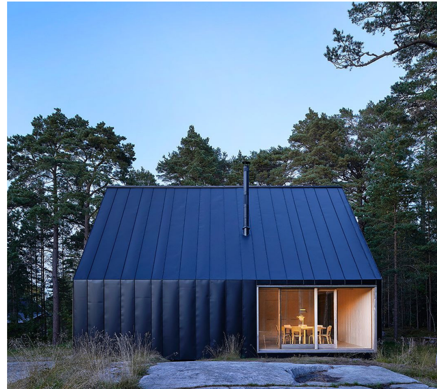
Kuva 37. Puun lisäksi pelti kestää erilaisia sääolosuhteita hyvin hoidettuna ja huollettuna pitkään. Tham&Videgård arkkitehtien suunnittelemassa saaristohuvilassa tumma pelti jatkuu katolta rakennuksen julkisivuille. (Kuva: Lindman 2012)
