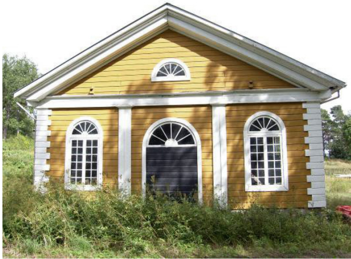
Kuva 13. Taalintehtaan makasiinin leveä vaakalaudoitus ja kaarevat ikkunat ovat tyypillisiä empirejulkisivuille. (Kuva: Curatio 2012, 11)
