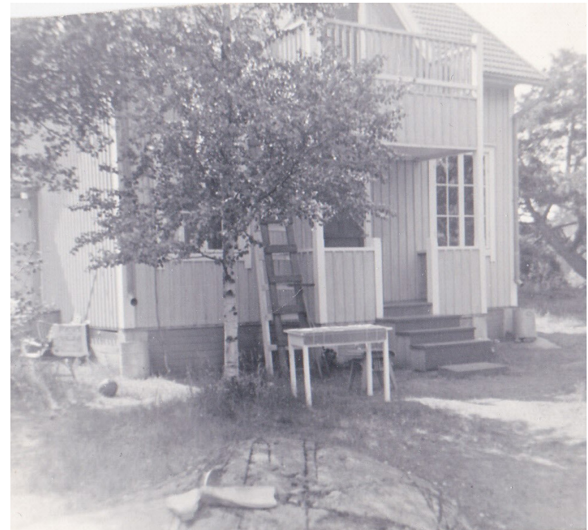
Kuva 26. Mökin alkuperäinen kuisti oli perinteinen kaksikerroksinen avokuisti. Avokuisti on kuistityypeistä varhaisin (Museovirasto 2000a). (Kuva: Tuntematon 1962)
