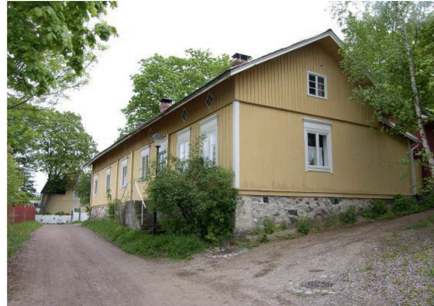
Kuva 12. Paraisten Vanhalla Malmilla sijaitsevasta talosta on nähtävissä, kuinka klassistisen kapeaa rakennusta voitiin laajentaa vain pituussuuntaan. Rakennusten pituutta pidettiin varallisuuden ja ahkeruuden mittana. (Kuva: Curatio 2012, 9)
