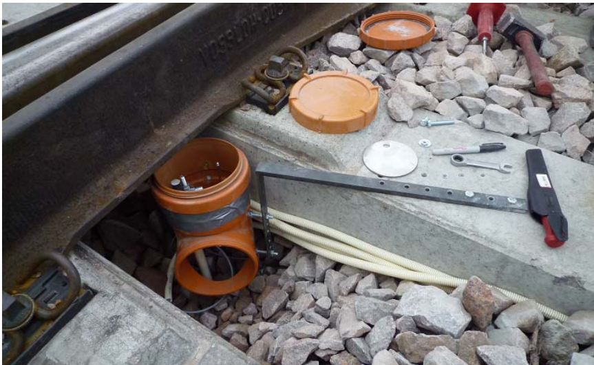
Kuva 13. Risteysalueen siirtymäanturikiinnitys.
