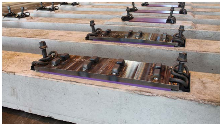
Kuva 5. Kiskon kiinnitys vaihdealuslevyn avulla risteyskärjen läheisyydessä, jossa kiskot kulkevat hyvin lähellä toisiaan.
