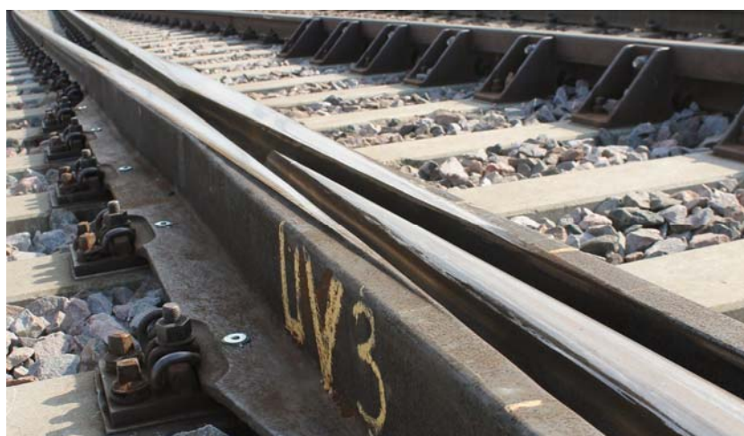
Kuva 49. Risteyksen korotus Kaipiaisten vaihteessa V213.
