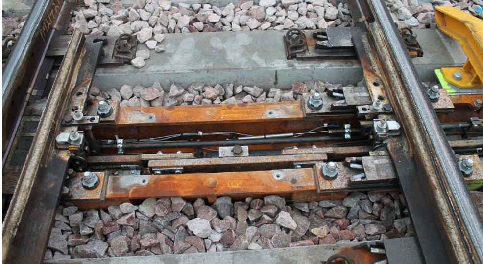
Kuva 23. Ontto teräspölkky kahden betonipölkyn korvaajana. Kääntötankojen sijainnin havainnollistamiseksi pölkystä on poistettu kuvan ajaksi kansirakenne.
