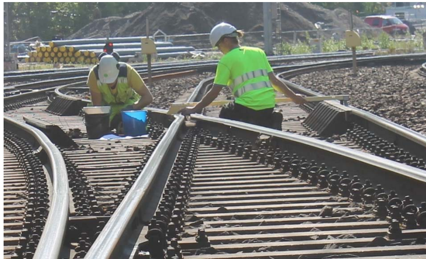
Kuva 55. Tampereen vaihteen V051 poikkeavan raiteen ulkokiskon painuma
