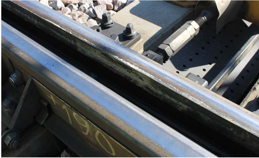
Kuva 53. Avoimen kielen ulkoreunan kulumisjäljet Taavetin vaihteessa V415.
