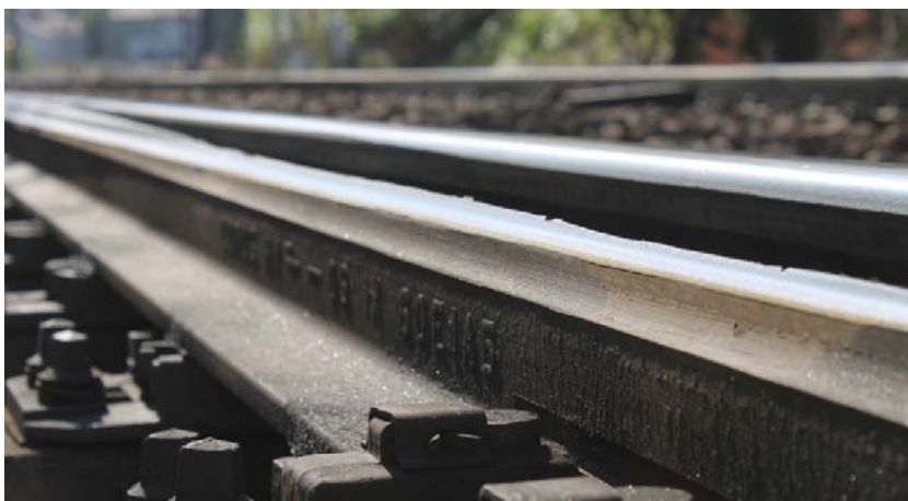
Kuva 54. Tampereen vaihteen V051 oikeanpuoleinen kielisovitus.
