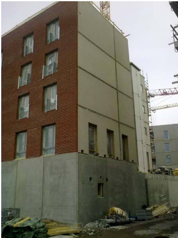
Kuva 3.13 Eristerappauselementit asennettuna ulkoseinällä (kuva Jukka Lahdensivu).
