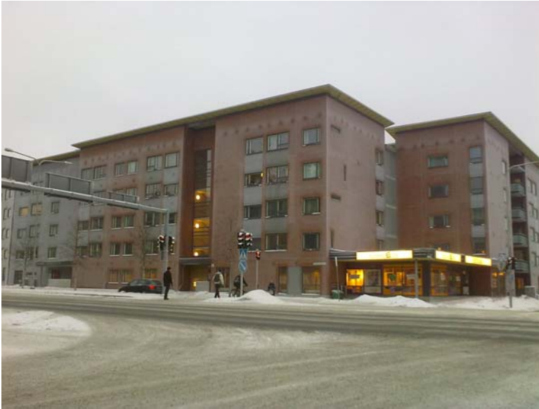
Kuva 1.1 Seinän ulko-osat altistuvat ankarammalle pakkasrasitukselle lämpövuotojen vähentyessä. Kuvassa ulkoseinän kylmä-siltakohdat erottuvat selvästi muuten huurtuneesta julkisivusta.
