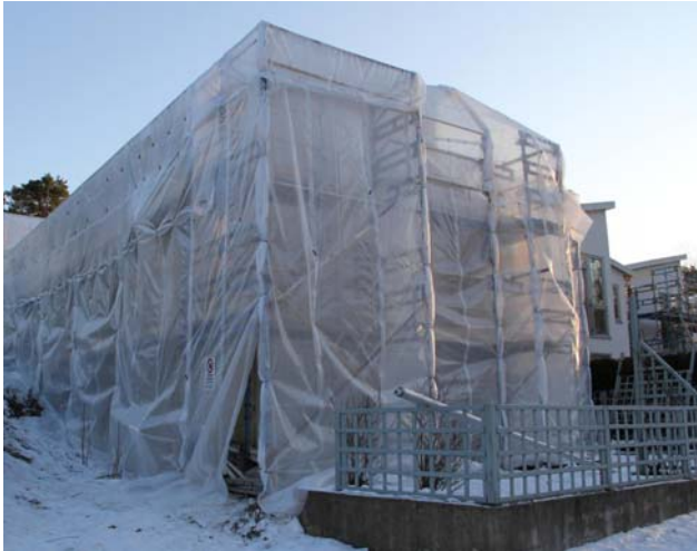
Kuva 1.3 Esimerkki rakennustyömaan sääsuojauksesta. Omakotitalon julkisivukorjaus tehtiin kokonaan huputettuna Ruotsissa Göteborgissa.
