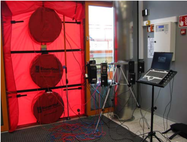
Kuva 1.6 Usean puhaltimen painekoe-laitteistolla saadaan mitattua suurempienkin rakennusten ilmatiiviys.
