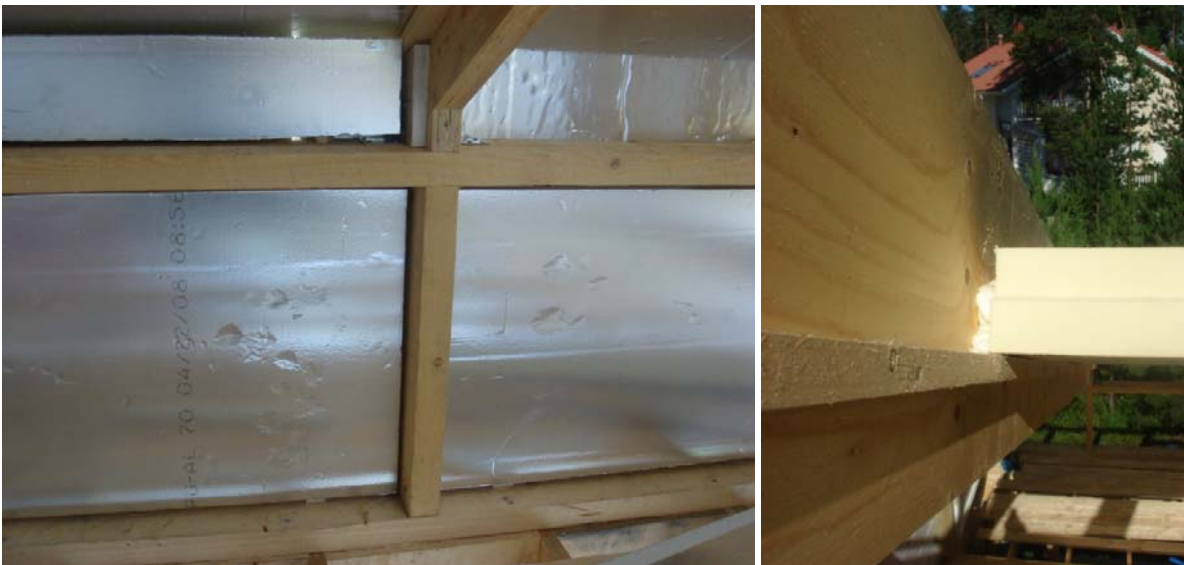
Kuva 1.8 Lämmöneristelevyjen kiilaus paikoilleen eristemateriaalista tehtyjen kiilojen avulla (vasemmalla) ja kertopuukannattavien kylkiin asennetuilla puurimoilla (oikealla). Saumojen täyttö elastisella polyuretaanivaahdolla kerroksittain (kuvat Jukka Lahdensivu).
