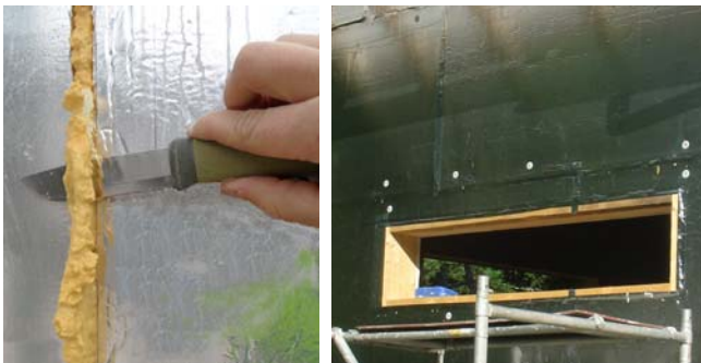
Kuva 1.9 Saumasta ylipursuneen sauma-vaahdon leikatut pinnat on tiivistetty ilmatiiviiden varmistamiseksi alumiiniteipillä.
