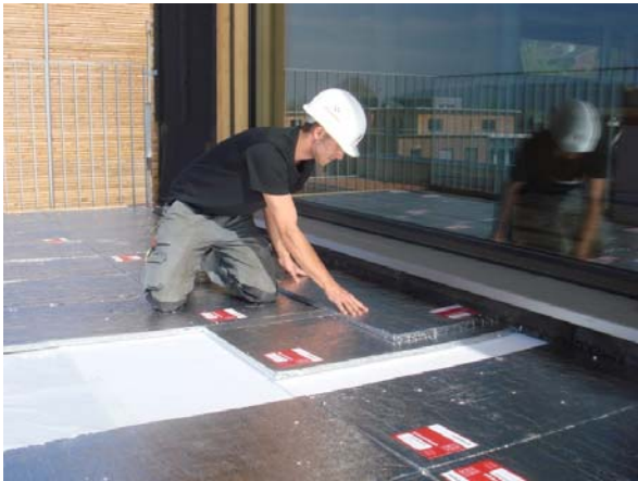
Kuva 8.1 Tyhjöeristeiden asentaminen käynnissä terassiparvekkeella ( www.vacuspeed.ch )
