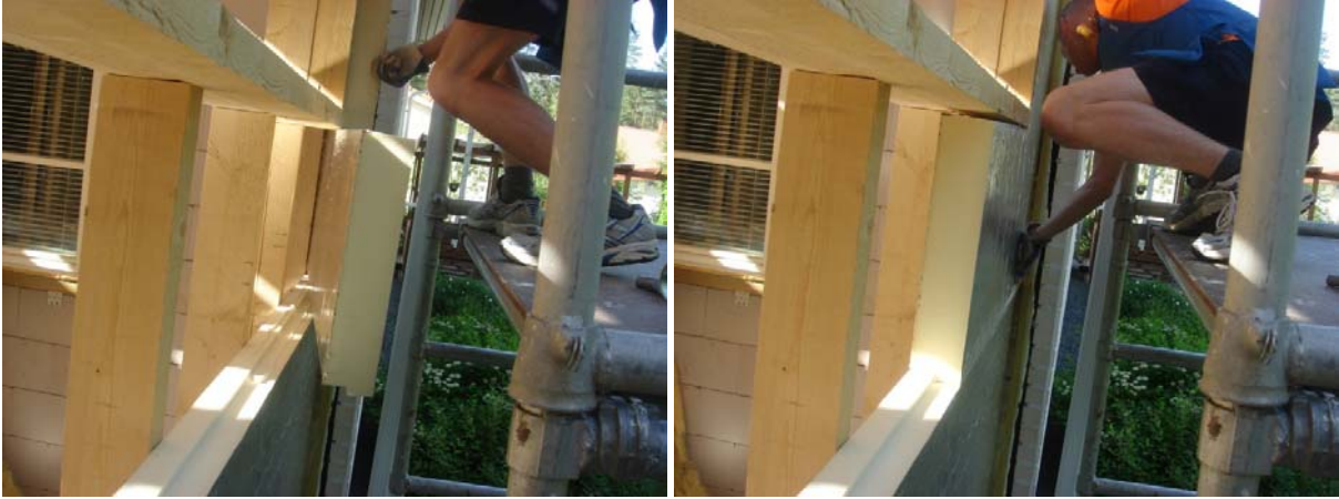
Kuva 1.7 Leikattu lämmöneriste ikkuna-aukon vieressä. Polyuretaanieristeen työstö on tehty käsisahalla ja leikkauspinnat pudistettu paineilmapuhalluksella ennen eristelevyn asentamista paikoilleen (kuvat: Satu Lahdensivu).
