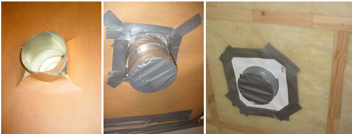
Kuva 4.2.2 Läpivientejä varten ilmansulkuun tehtiin koekappaleita kootessa X-viilto (vasemmalla). Ensimmäisessä koesarjassa yksittäiset putket tiivistettiin teippaamalla (keskellä). Yksittäisten läpivientien tiivistykseen kokeiltiin myös läpivientilaippoja (oikealla).
