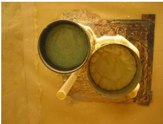
Kuva 4.3.3 Läpivientä varten ilmansulkuun tehty aukko teipattiin alumiiniteipillä PUR-levyyn. Läpivientiputket tiivistettiin levyyn vaahdolla (vasemmalla). Yksittäisten putkien tiivistykset olivat hyvin onnistuneet, mutta kolmen putken läpiviennissä tulos oli heikompi (oikealla).
